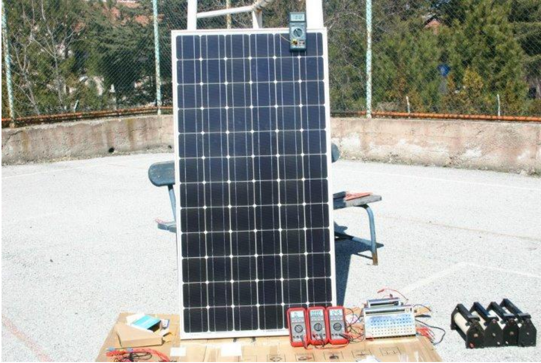
Resim 6.1. PV sistem kurulumu
