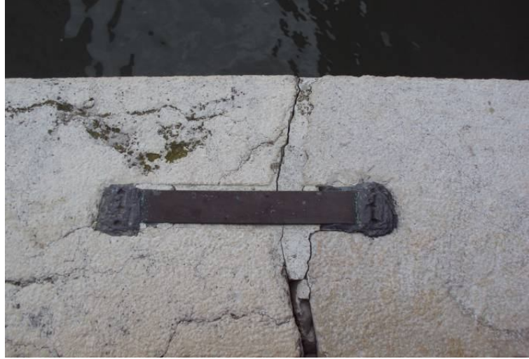
Şekil 5.17. Venedik’te bir köprüde kenet uygulaması
