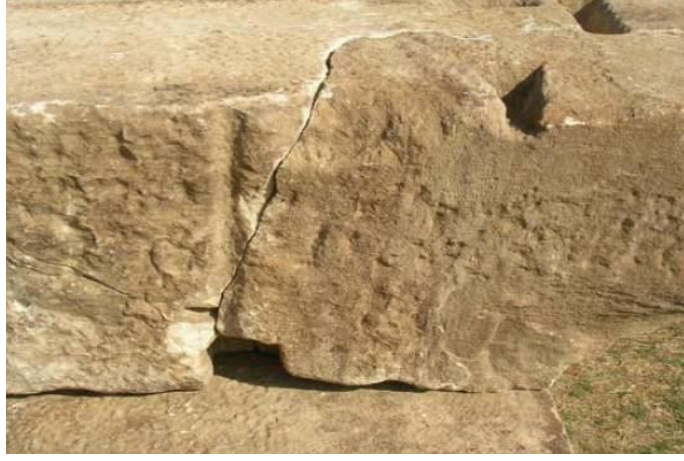
Şekil 5.38. Magnesia Artemis Tapınağında dikey akıtma kanalı örneği
