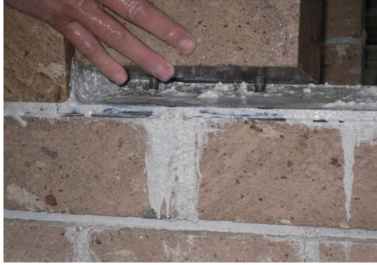
Şekil 6.25. Doğal taşın zıvanalara yerleştirilmesi işlemine ait resim
