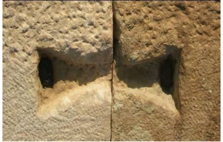
Şekil 5.7. Kırlangıç kuyruğu yuvası tip I örneği (Demirtaş, 2006)
