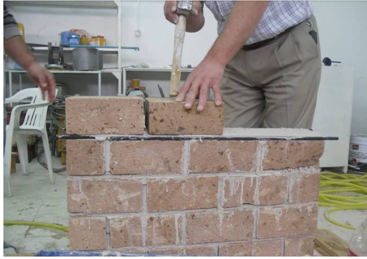
Şekil 6.21. Duvarın örülmesi işlemi ait resim
