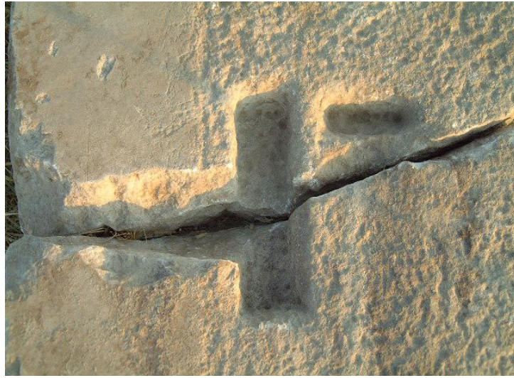
Şekil 5.30. Üst taşların altına açılan kapalı zıvana yuvası örneği (Demirtaş, 2006)
