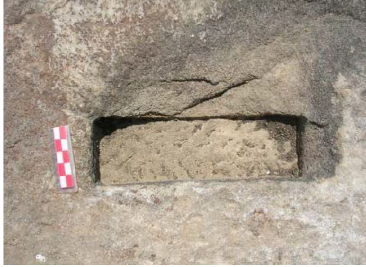
Şekil 5.29. Alt taşın üzerine açılan kapalı zıvana yuvası örneği (Demirtaş, 2006)
