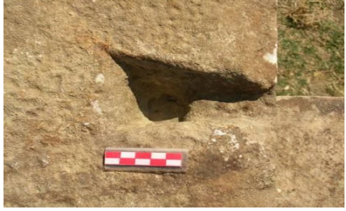
Şekil 5.10. Kırılmaç kuyruğu yuvası tip IV örneği (Demirtaş, 2006)
