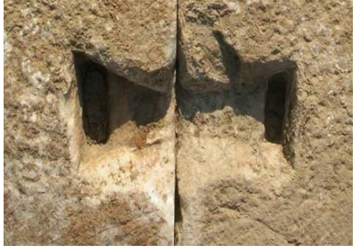
Şekil 5.8. Kırılmaç kuyruğu yuvası tip II örneği (Demirtaş, 2006)
