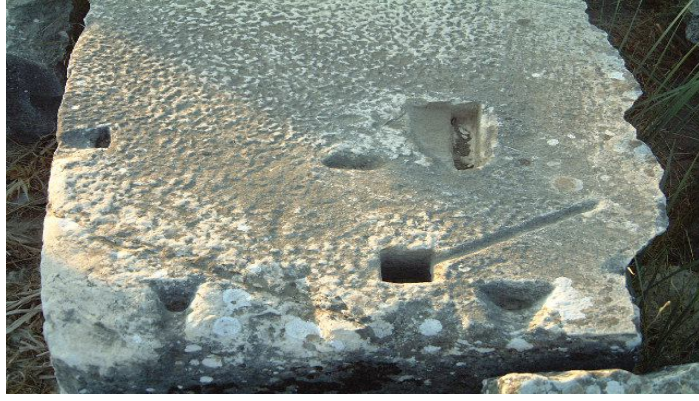
Şekil 5.23. Magnesia Artemis Tapınağı, prizmatik zıvana yuvası (Demirtaş, 2006)
