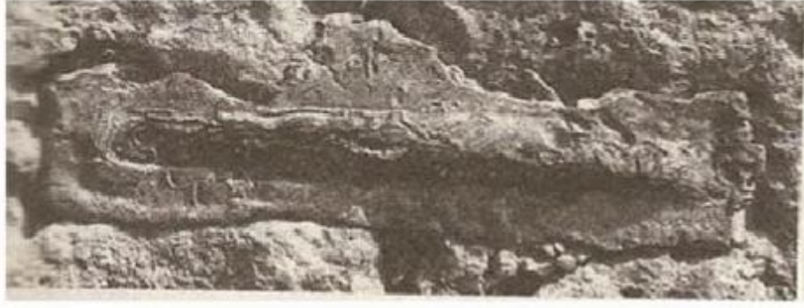
Şekil 5.35. Magnesia Artemis sunağında perçinlenmiş U tipi kenet (Bingöl, 2008)
