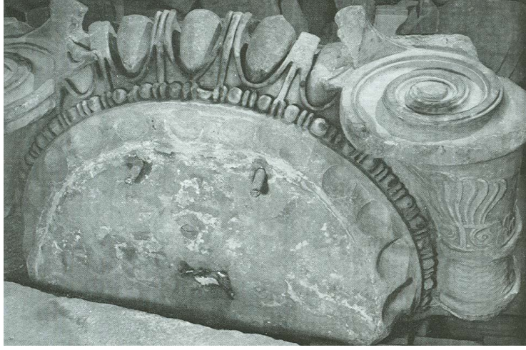
Şekil 5.27. Sütun başlığında silindir şekilli zıvana örneği
