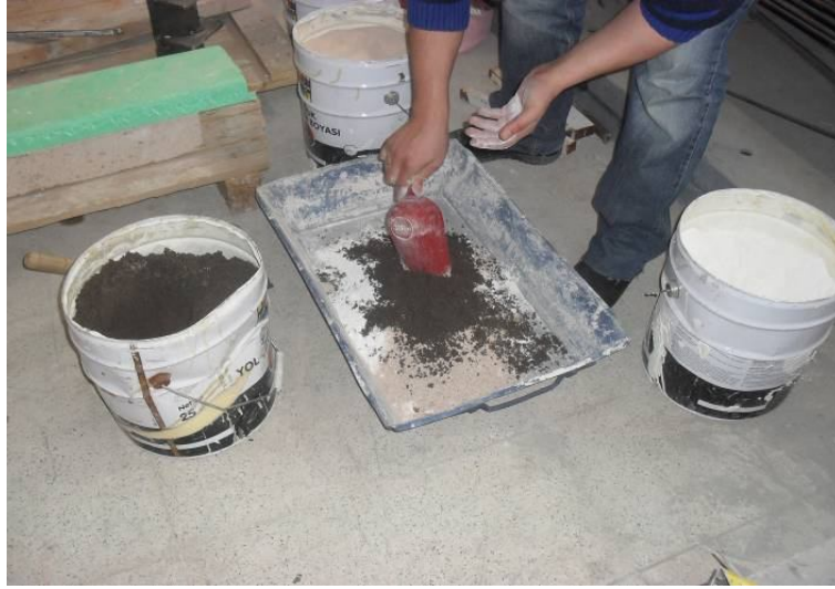
Şekil 6.9. Harç malzemesinin karılması
