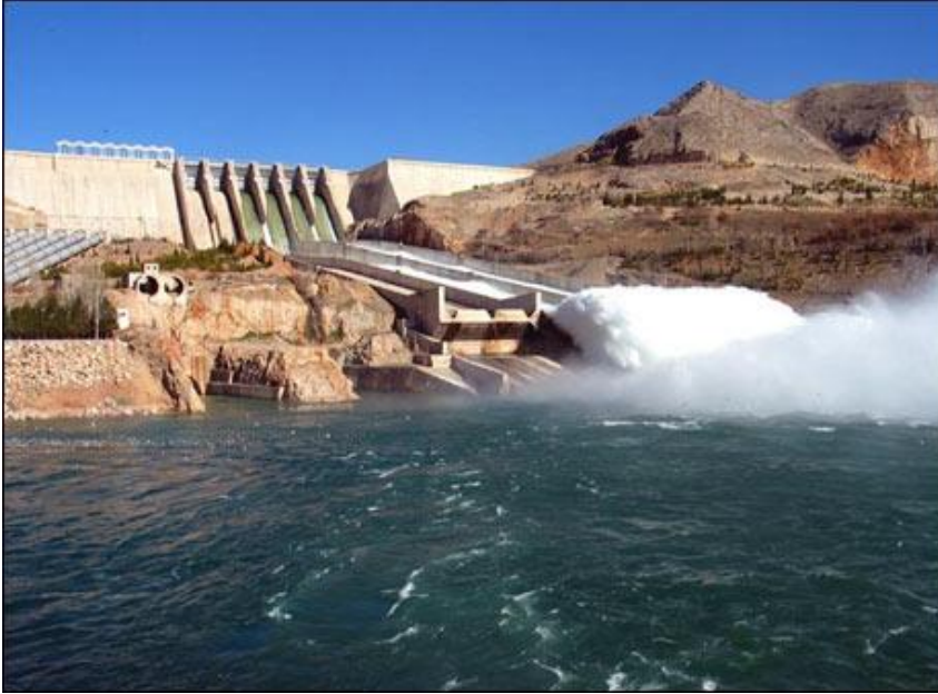
Şekil 3.7 Hidroelektrik Enerji Elektrik Santrali
