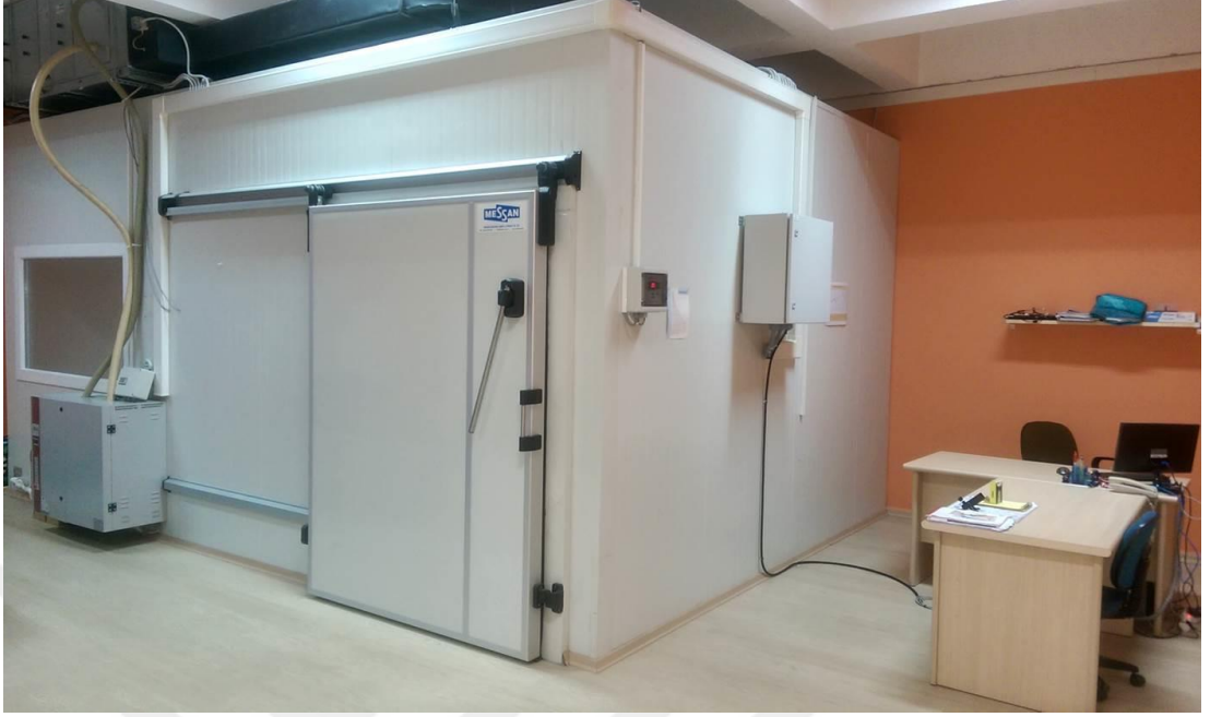
Fotoğraf 1: İklimlendirme Odası Dıştan Görünüm
