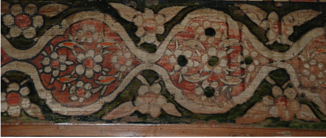
Şekil No: 34. Duvar pervazı ve gömme dolap kenarı
