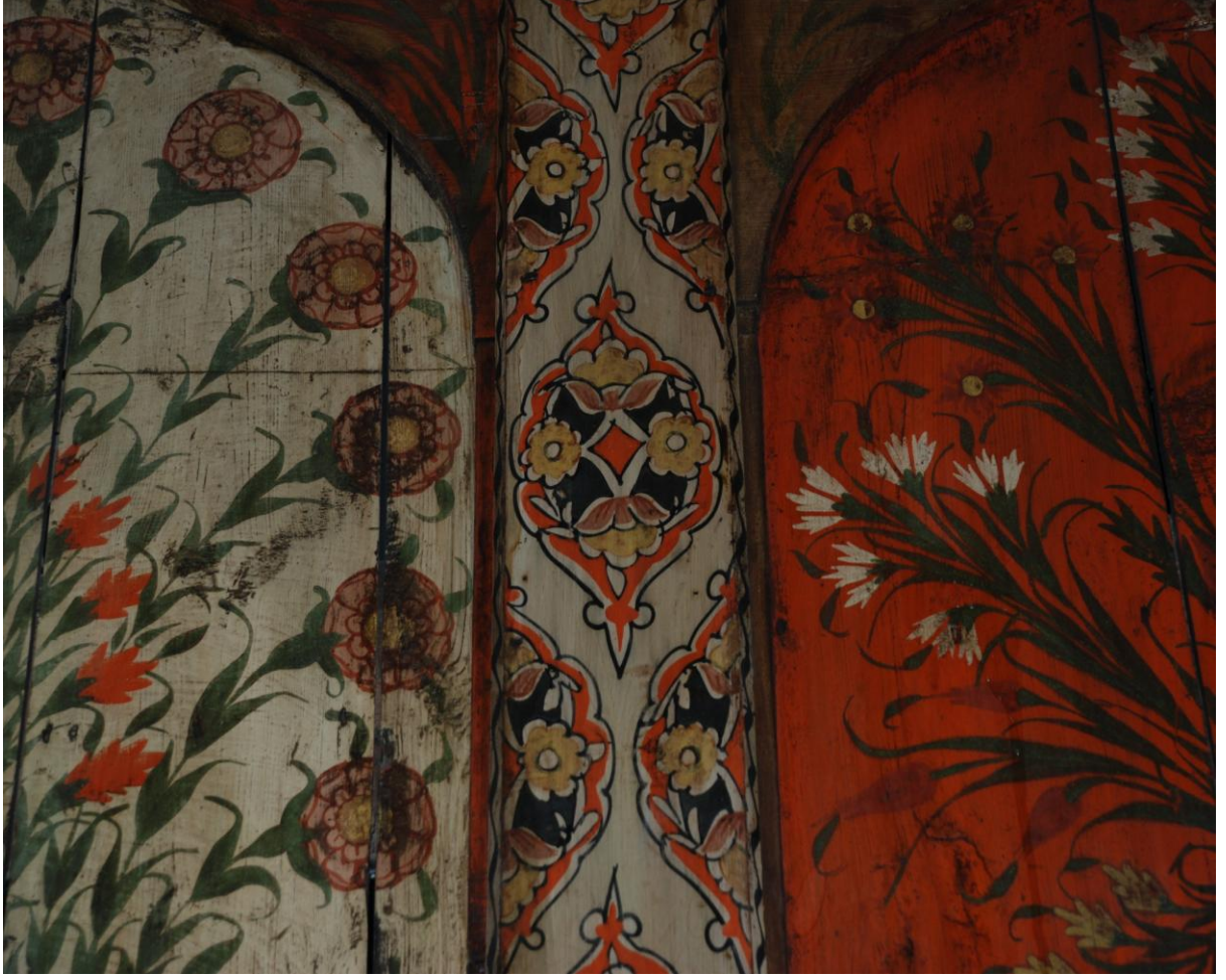
Şekil No: 29. Duvar pano kenarı genel görünüş
