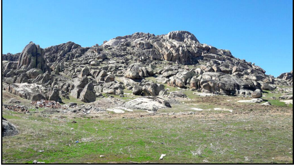
Şekil 3.4: Kalebalta granitoidlerin kırıklı çatlaklı görüntüsü.
