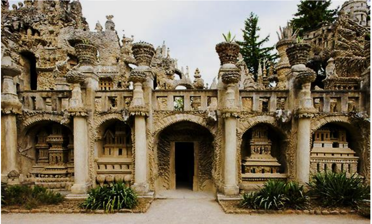
Şekil 3.29. Le Palais Idéal; Batı Cephesinden Görünüş. 44
