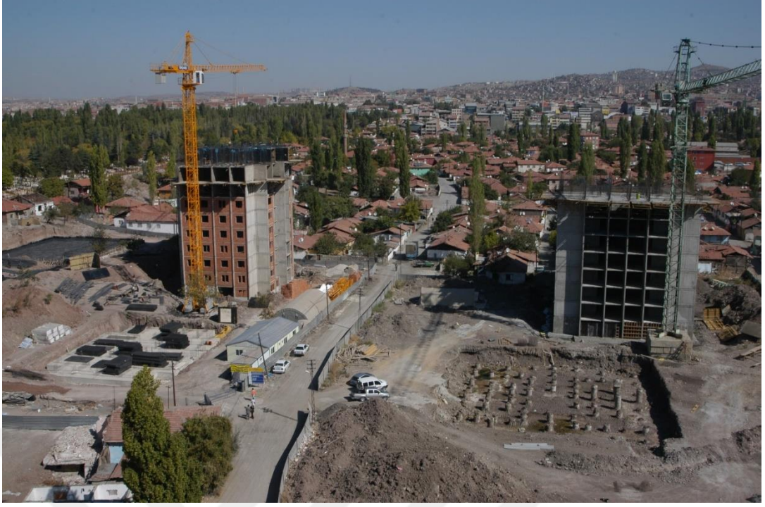
Şekil 7.12. Yatıkmsuluk kentsel dönüşüm projesi 3. etap yıkım öncesi görünüm (TOKİ).
