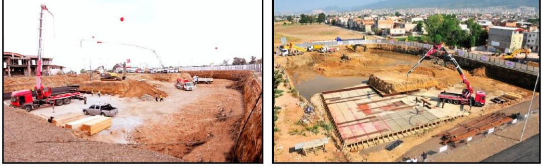
Şekil 5.24. Bursa Yıldırım kentsel dönüşüm uygulaması çalışmaları (Kıyım, 2015).
