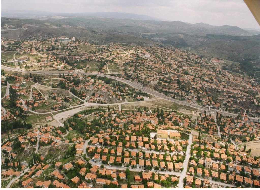
Şekil 5.10. Kuzey Ankara girişi kentsel dönüşüm proje alanı yıkım öncesi görünümü (Zeydanlı, 2007).
