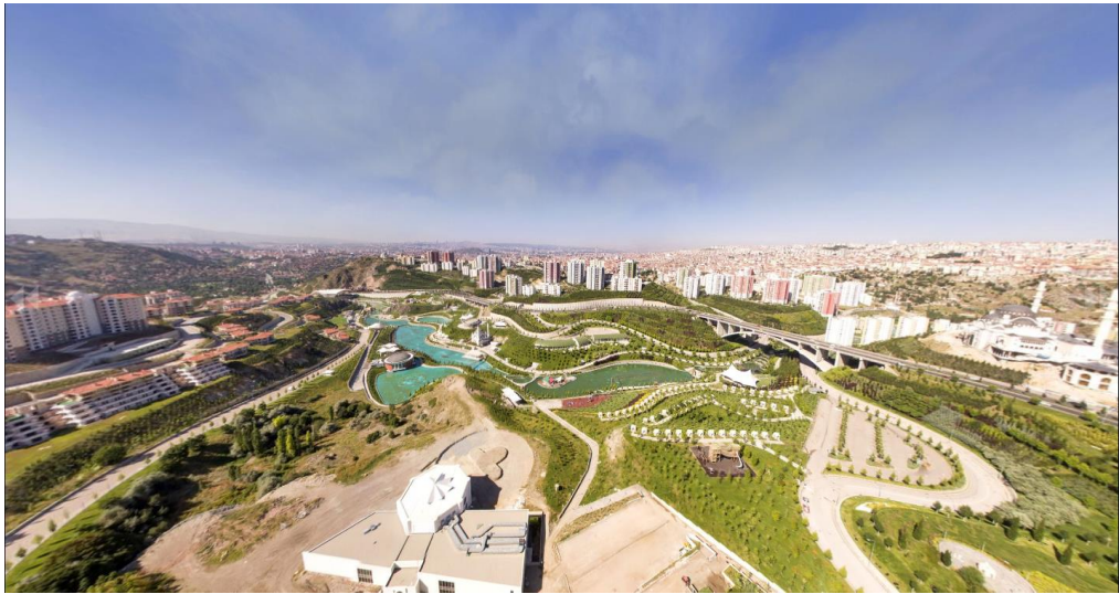
Şekil 5.11. Kuzey Ankara kentsel dönüşüm projesi inşaat sonrası görünümü. (URL-13).
