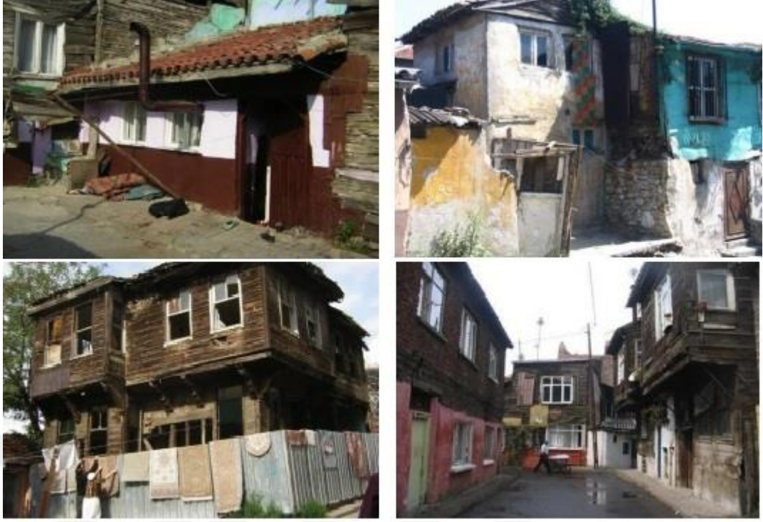
Şekil 5.15. Kentsel dönüşüm öncesi Sulukule’de yapılaşma (Safdari, 2014).
