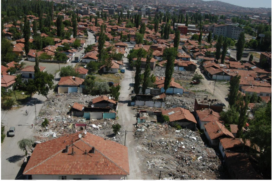
Şekil 7.5. Yatıkmusluk kentsel dönüşüm projesi 2. etap yıkım öncesi görünüm.
