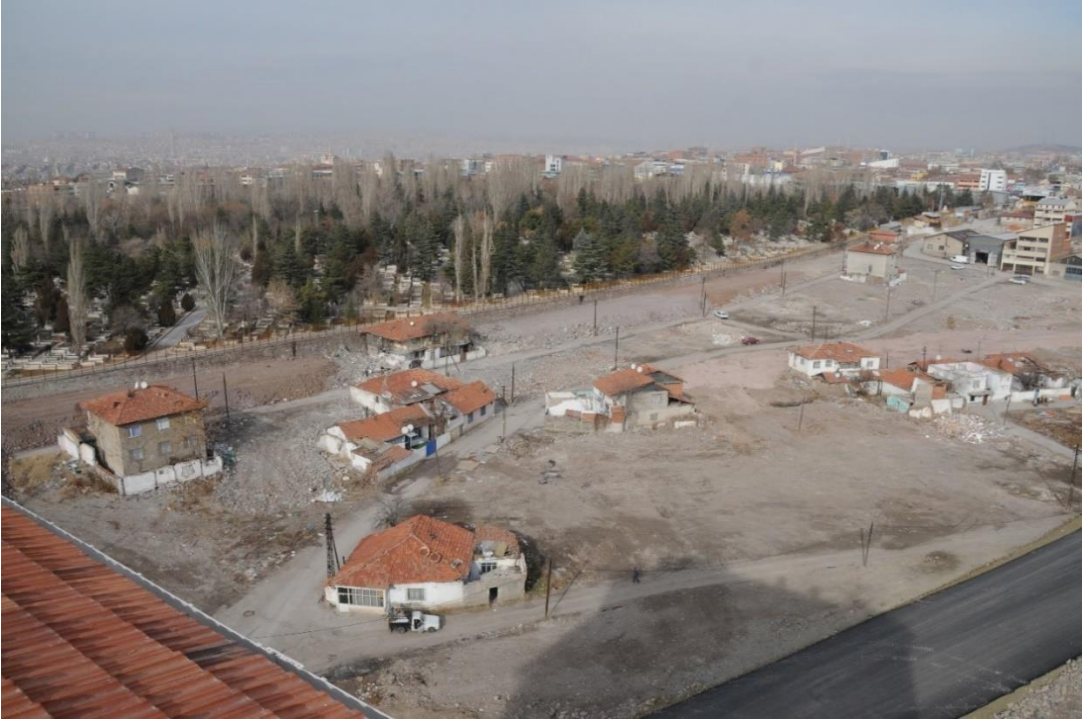
Şekil 7.13. Yatıkmsuluk kentsel dönüşüm projesi 3. etap yıkım sonrası görünüm (TOKİ).
