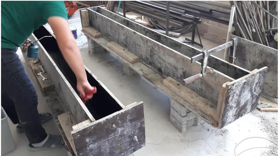
Şekil 3.8. Kalıpların yağlanması.
