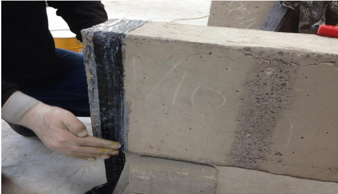
Şekil 3.13. CFRP şeritlerin yapıştırılması.
