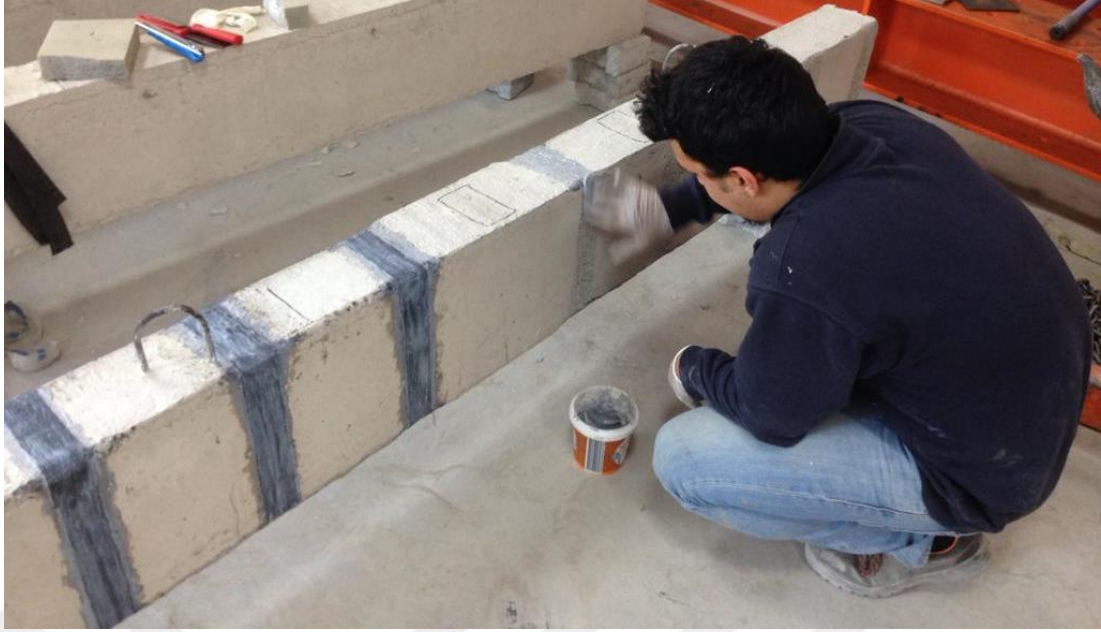
Şekil 3.12. Hazırlanan yüzeylere epoksi sürülmesi.
