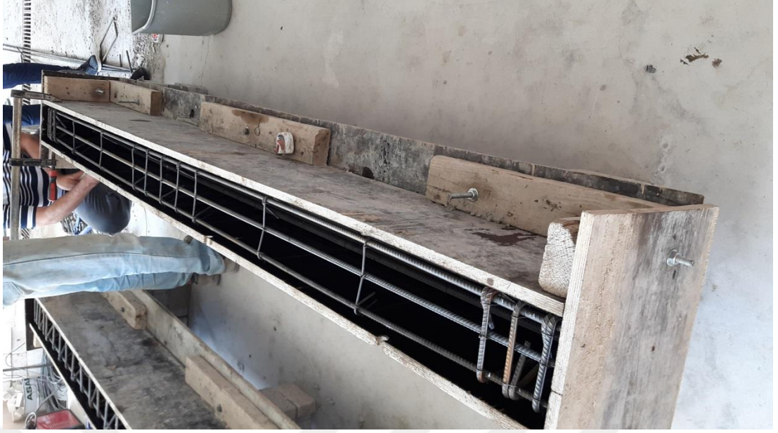
Şekil 3.9. Donatı kafeslerinin kalıplara yerleştirilmesi.
