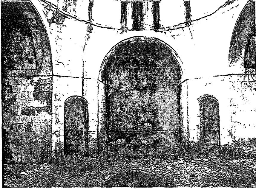
Resim-295 Akşehir Yukarı Hamam. Kadınlar kısmı sıcaklık mekanı.
