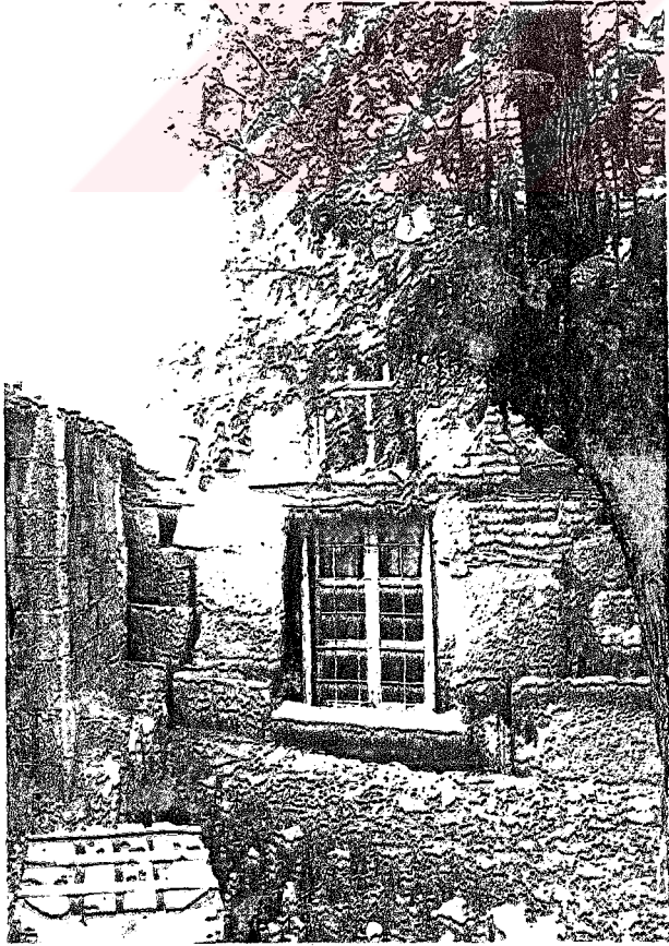
Resim-58 Akşehir Gdk Minare Mescidi. Batı duvarındaki pencere aıklığı.
