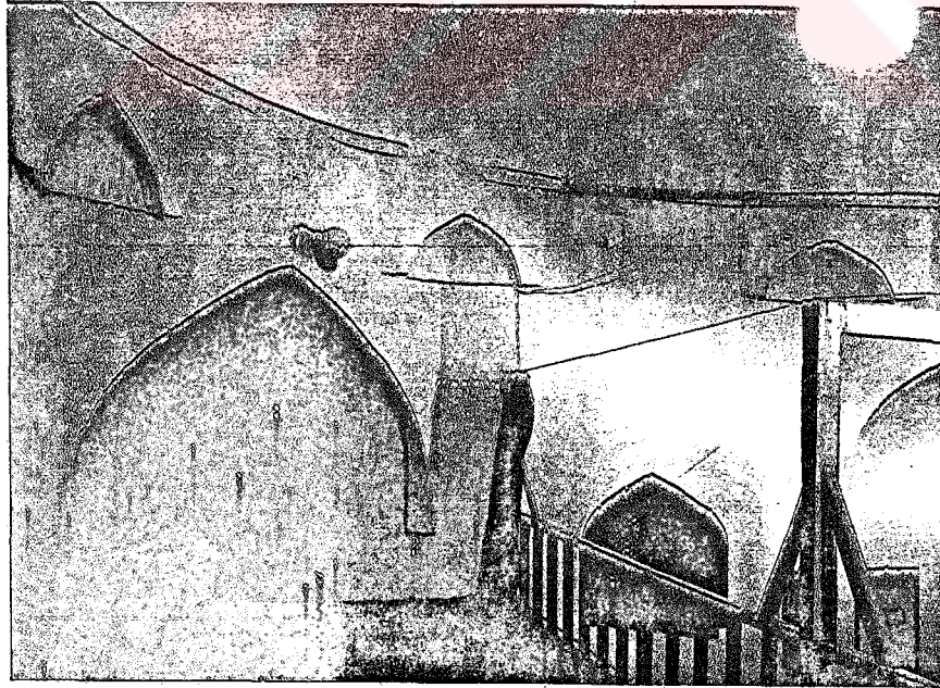
Resim-36 Akşehir Altınkalem Mescidi. Kubbe geçişleri.
