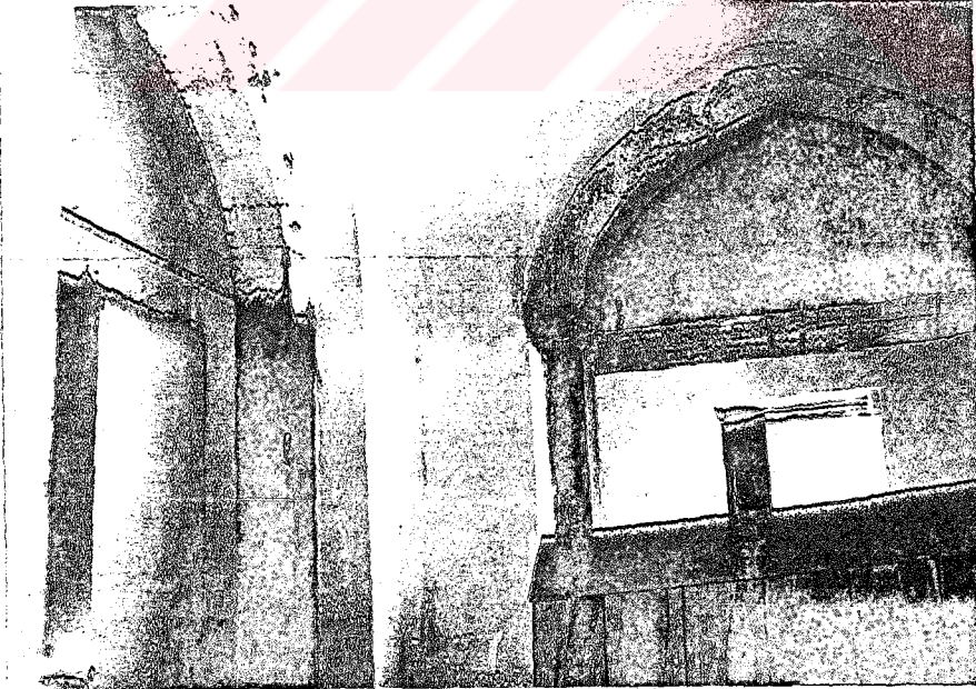
Resim-200 Akşehir Seyyid Mahmud Hayran Türbesi. İçten görünüş.
