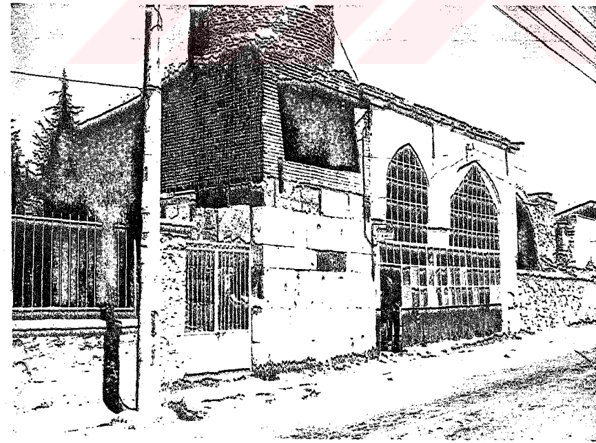
Resim-78 Akşehir Taş Medrese Mescidi. Kuzeybatıdan görünüş.
