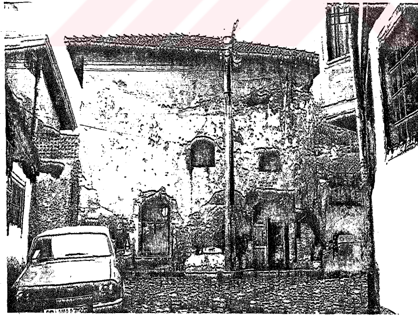
Resim-68 Akşehir Kk Ayasofya Mescidi. Dođu cephesi.
