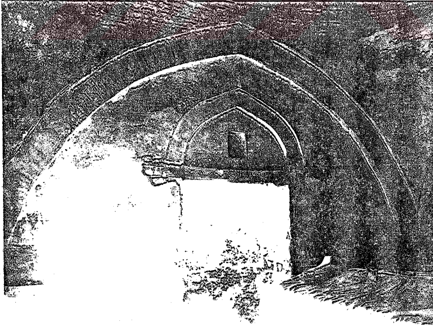
Resim-248 Akşehir Türâbî Türbesi. Doğu duvarındaki giriş açıklığının içten görünüşü.
