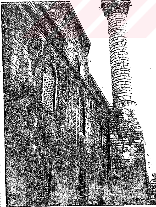
Resim-144 Akşehir Hasan Paşa (İmaret) Camii. Doğu cephe.
