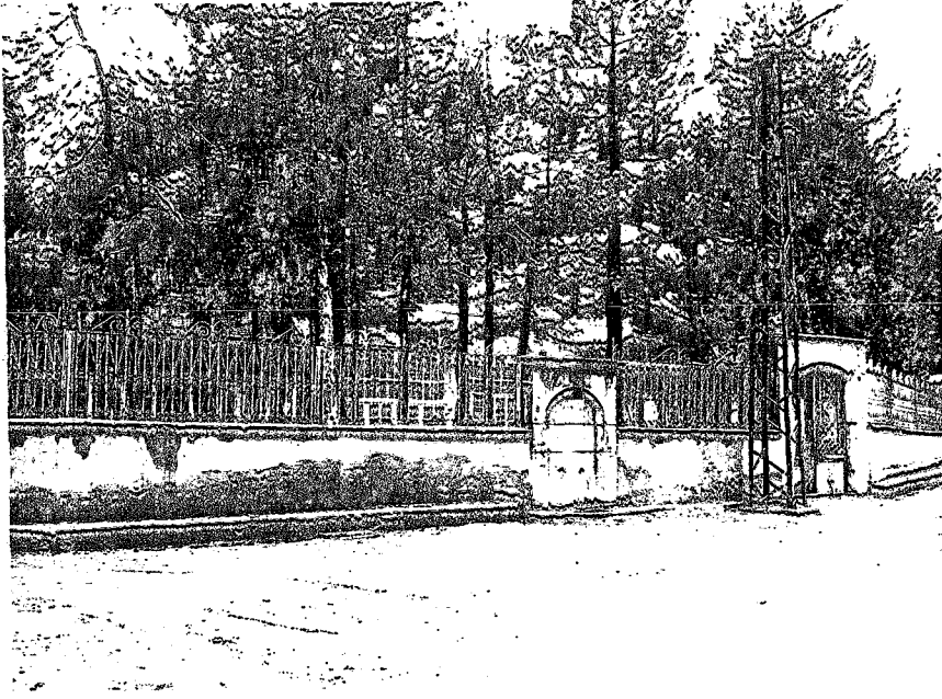
Resim-1 Akşehir Ulu Camii.Avlunun kuzeydoğudan görünüşü.
