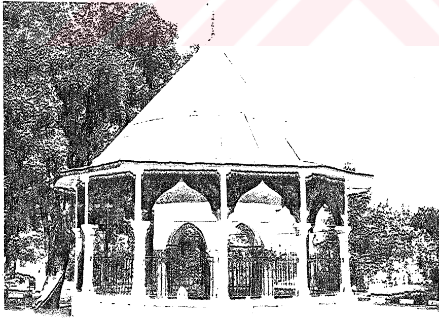
Resim-234 Akşehir Nasreddin Hoca Türbesi. Genel görünüş.
