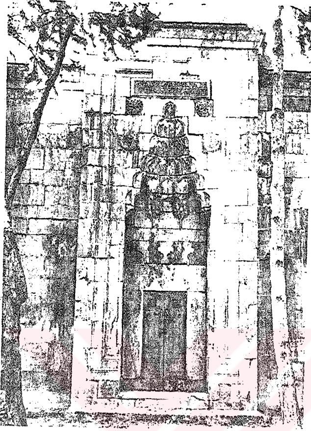
Resim-227 Akşehir-Mâruf (Alanyurt) Kö- yü Şeyh Hasan Türbesi. Taçkapı.
