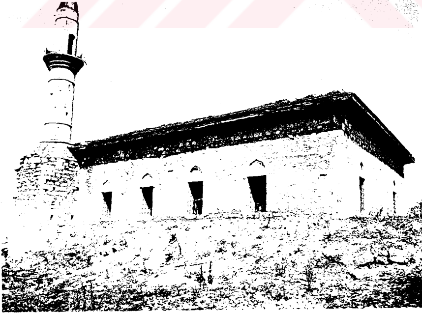
Resim 172- Kale, Cafer Paşa Camii. Batı cephesi.
