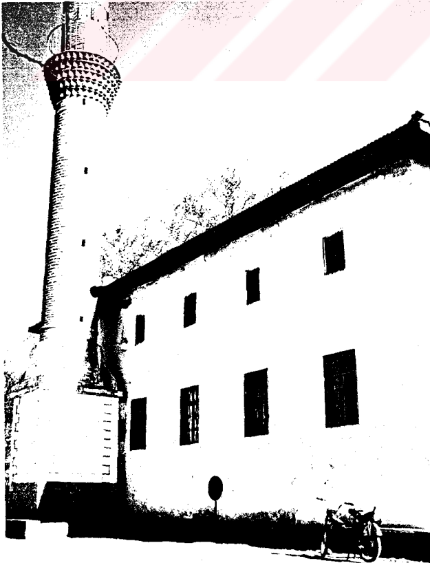
Resim 128- Acıpayam-Yazır Kasabası Çarşı Camii. Batı cephesi.
