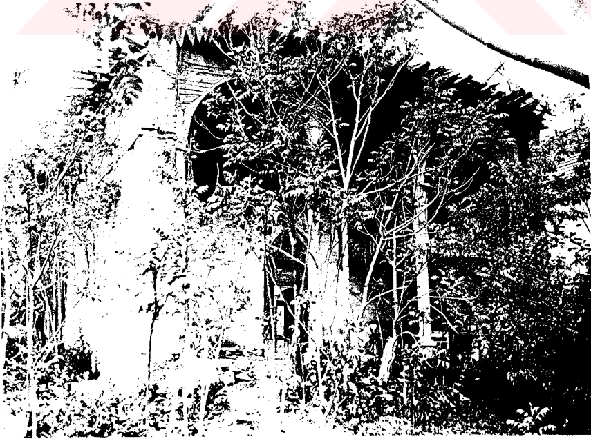
Resim 82- Çivril-Savran Köyü Camii.Kuzey cephesi.
