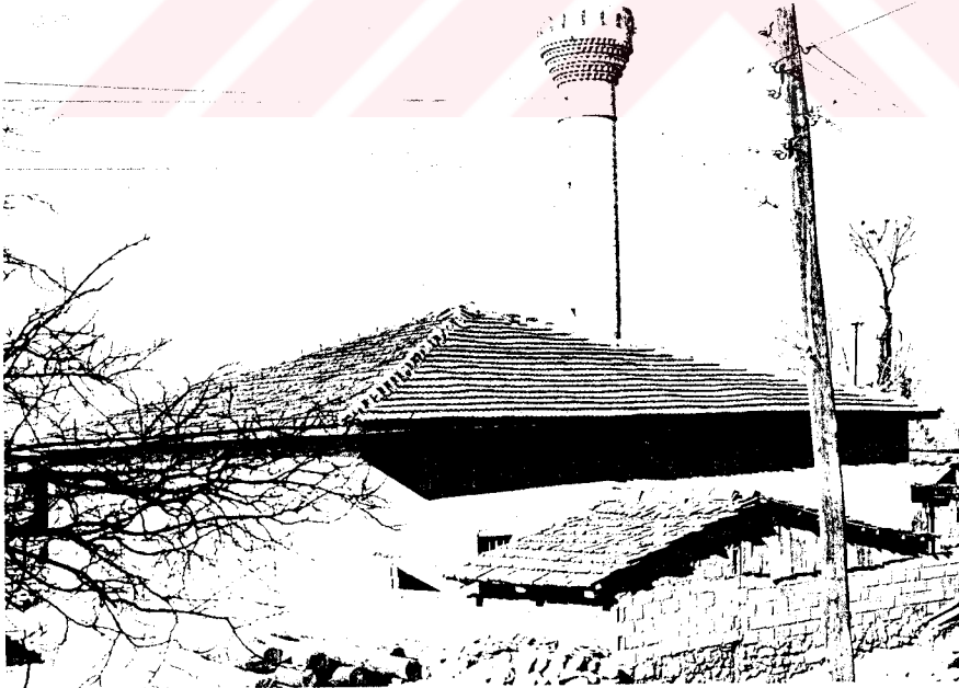
Resim 200- Güney-Belenardıç Köyü Camii.Doğu cephesi.
