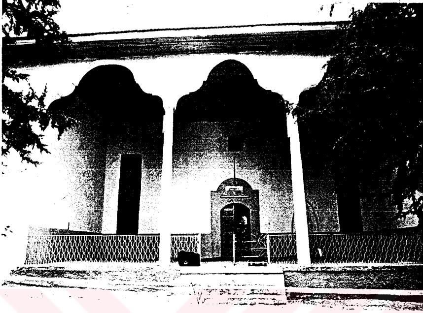
Resim 161- Bozkurt-Baklankuyucak Köyü Camii.Kuzey cephesi.
