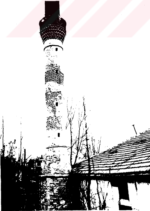
Resim 246- Baklan-Çataloba Köyü Camii.Minare.
