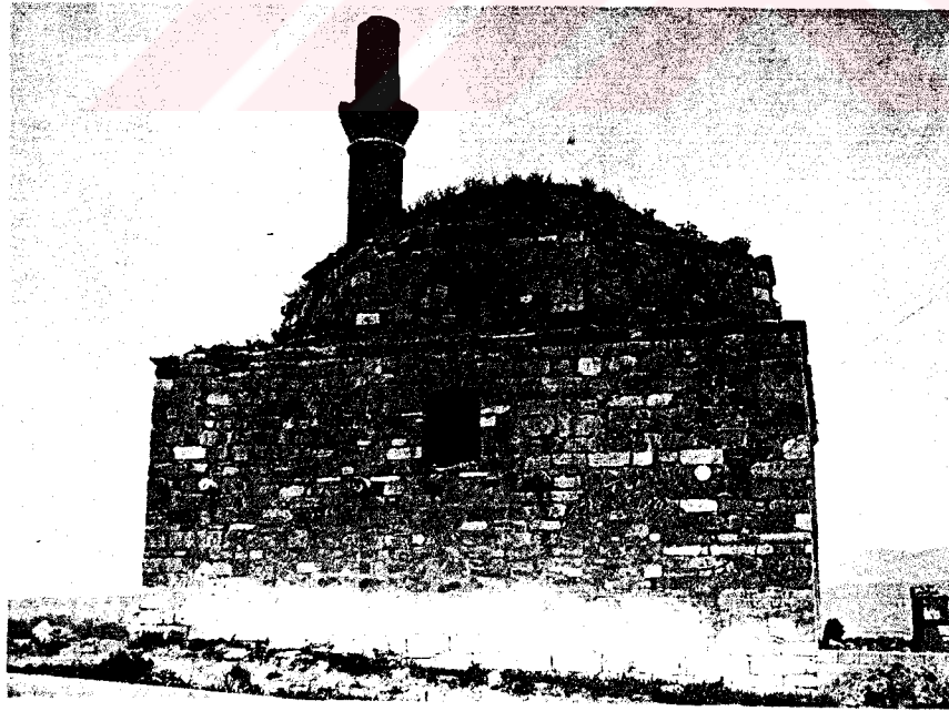
Resim 4- Çivril-Emirhisar, Dedeköy Camii. Güney cephesi.
