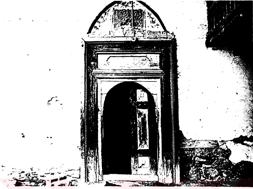
Resim 85- Çivril-Savran Köyü Camii.Harim girişi.
