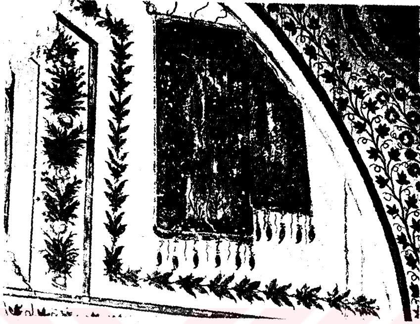
Resim 95- Çivril-Savran Köyü Camii.Kalemîşi süslemelerden ayrıntı.
