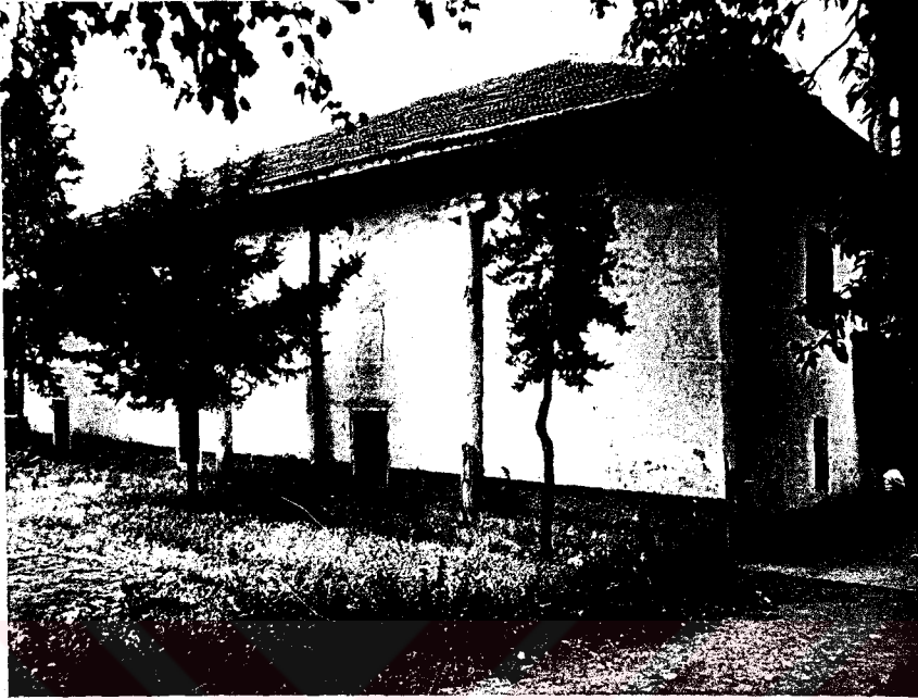
Resim 51- Baklan-Boğaziçi Kasabası Eski Camii.Doğu cephesi.
