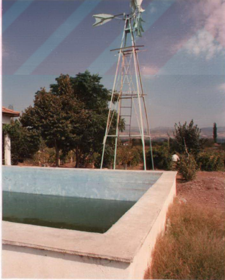
Foto 2: Akhisar ovasında rüzgar enerjisiyle çalışan su pompalarından biri.
