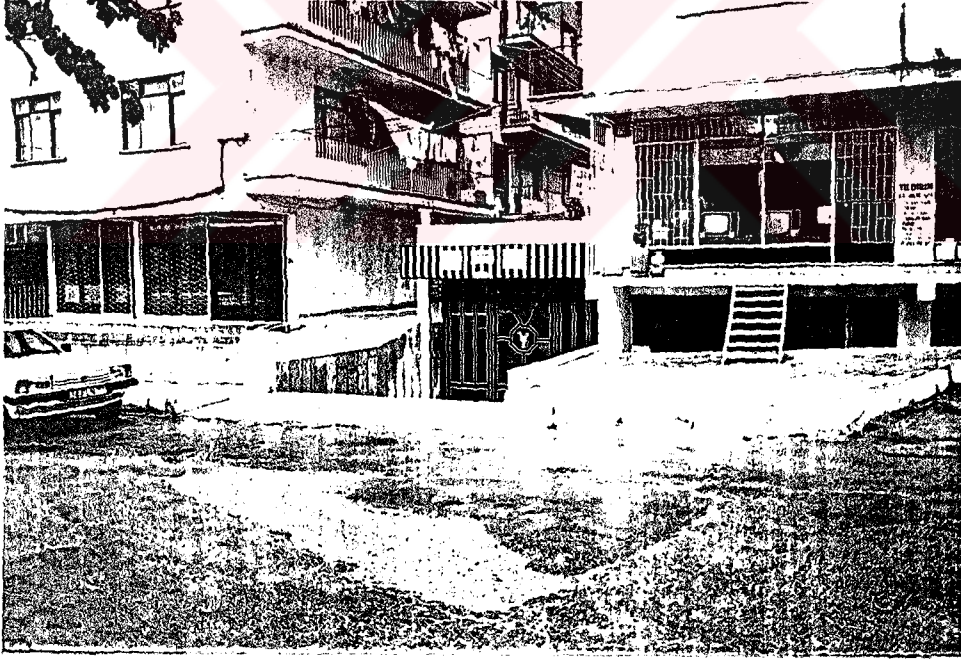
FOTOĞRAF 2- Konfeksiyon atölyelerinin apartmanların bodrum katında bulunması hemen hemen her tesise özgü bir olgudur. Fotoğraf, bunun ikinci bir örneği durumundadır.
