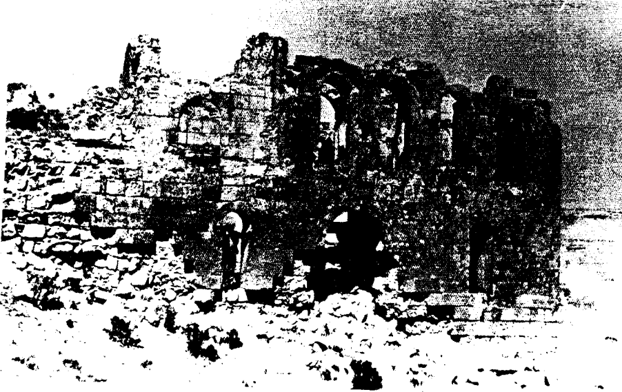
Resim 30: Akhisar, Çanlı Kilise, batı cephe (Restle 1979)
