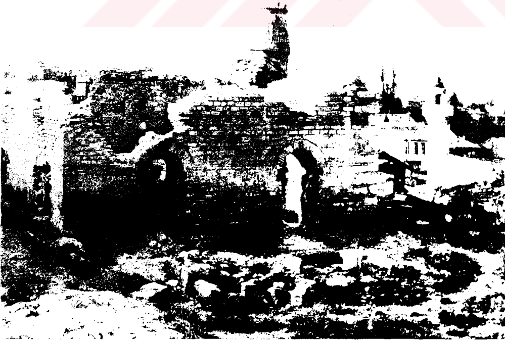
Resim 19: Kasım Ağa Mescidi, Kuzey yan cephe (Mathews 1976)
