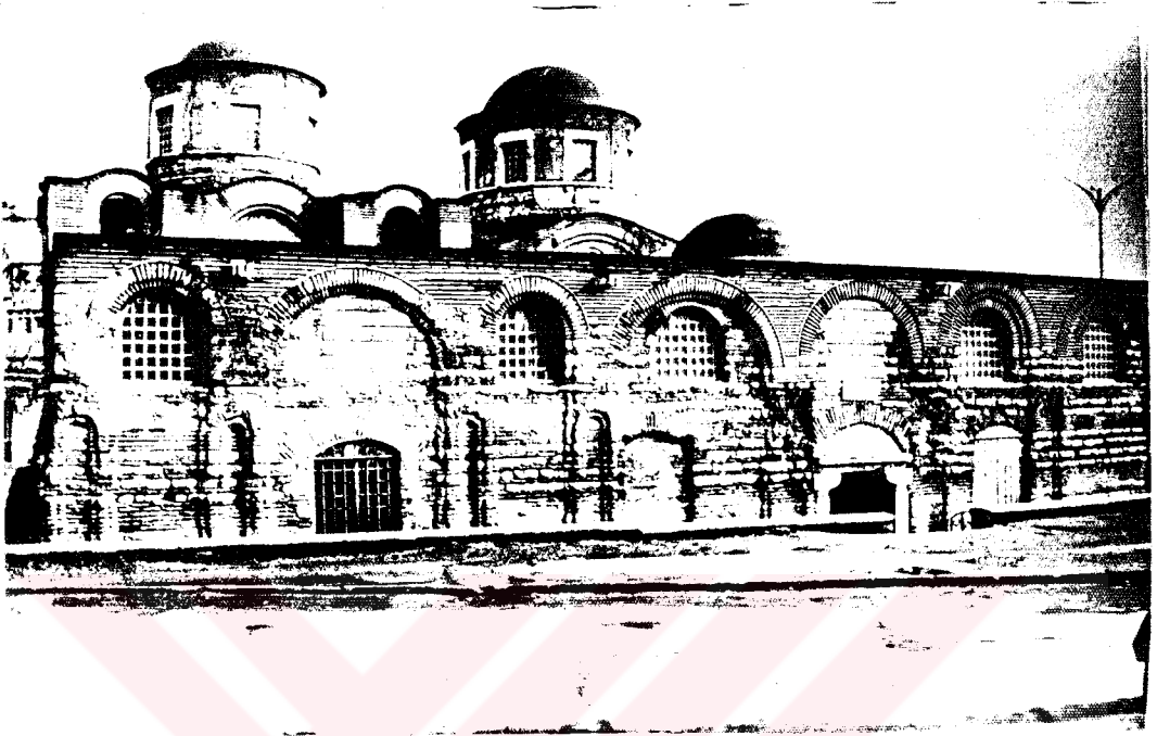
Resim 3: Fenari Isa Camii, batı cephe (Mathews 1976)
