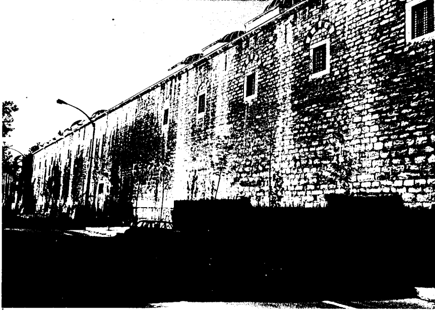
Resim 73- İstanbul Fatih Medreseleri. Akdeniz - Çifte Kurşunlular'ın batı cephesi.
