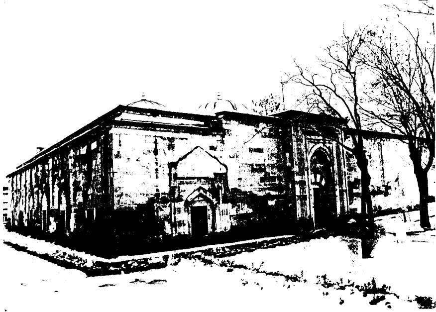
Resim 79- Afyon Gedik Ahmed Paşa Medresesi. Kuzeydoğudan genel görünüş.
