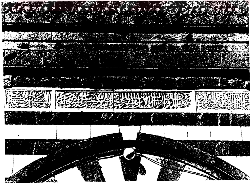
Resim 34- Merzifon Çelebi Sultan Mehmed Medresesi. İnşa kitabesi.
