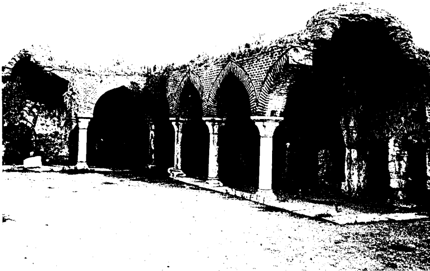
Resim 156- Hereke Köyü Medresesi. Güneybatıdan görünüş.
