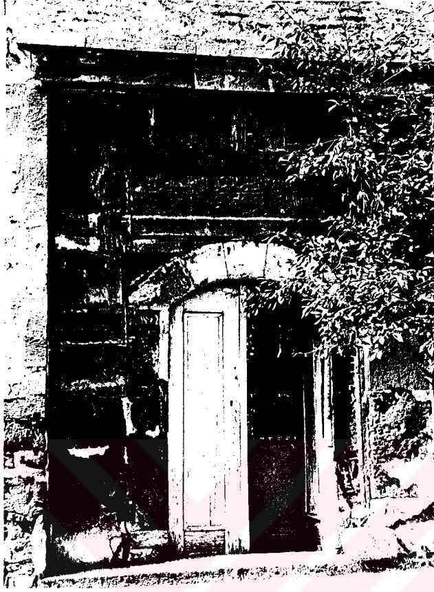
Resim 29- Gümüş Hacı Halil Paşa Medresesi. Medrese girişi.
