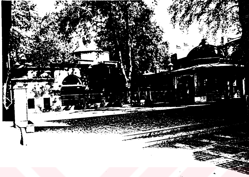
Resim 97- İnegöl İshak Paşa Medresesi. Güneybatıdan genel görünüşü.
