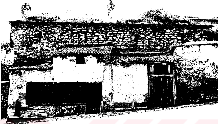
Resim 133- Bayındır Hacı Sinan Medresesi. Batı cephesinin onarımdan önceki durumu. (Mart 1994)
