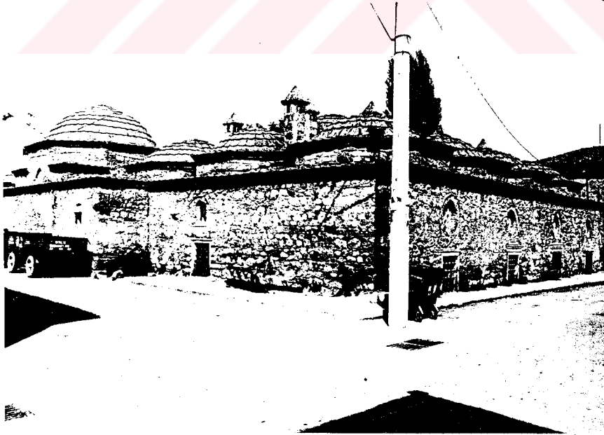
Resim 2- Iznik Süleyman Paşa Medresesi. Güneybatıdan genel görünüş.
