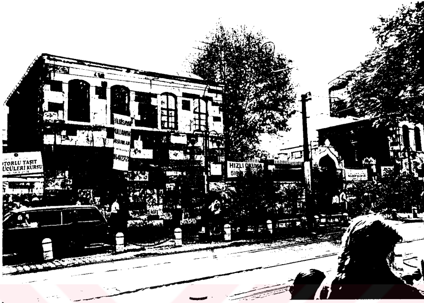
Resim 141- İstanbul Atik Ali Paşa Medresesi. Kuzeydoğudan genel görünüş.
