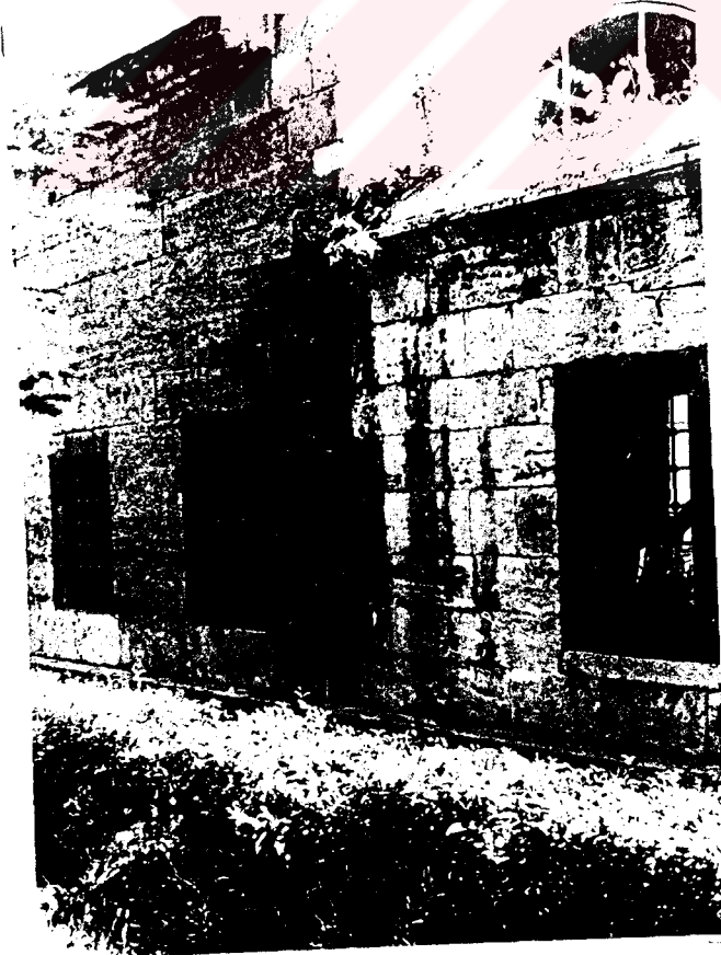
Resim 108- Amasya II. Bayezid Medresesi. Avlunun kuzey kenarını kapatan muhdes duvar.
