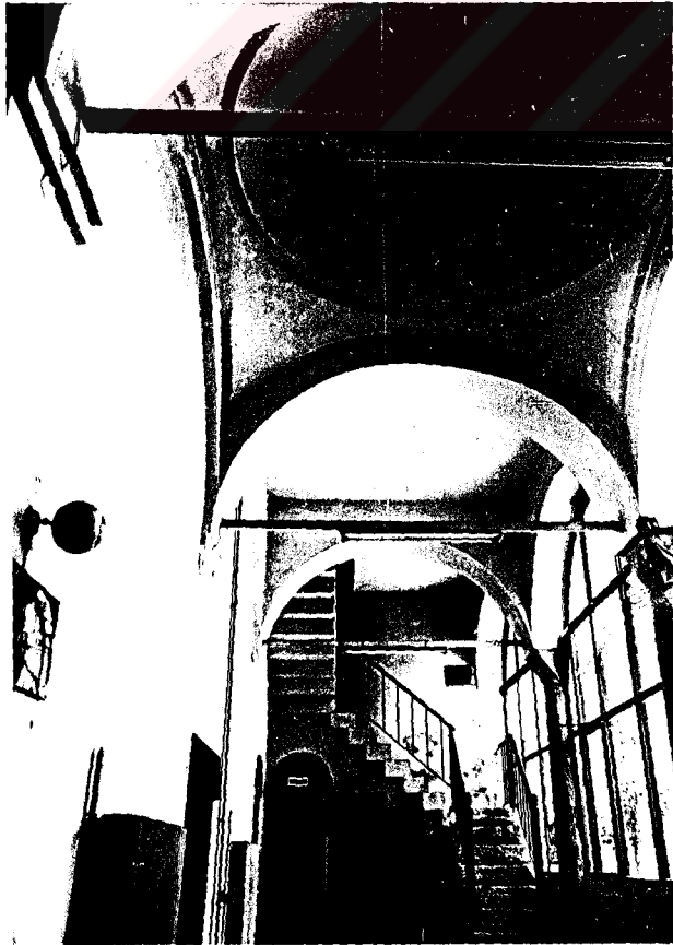
Resim 144- İstanbul Atik Ali Paşa Medresesi. Batı revakının içten görünüşü ve muhdes üst kata çıkış merdivenleri.
