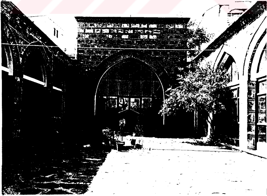
Resim 84- Bursa Ahmed Paşa Medresesi. Avlu ve dershane eyvanı.
