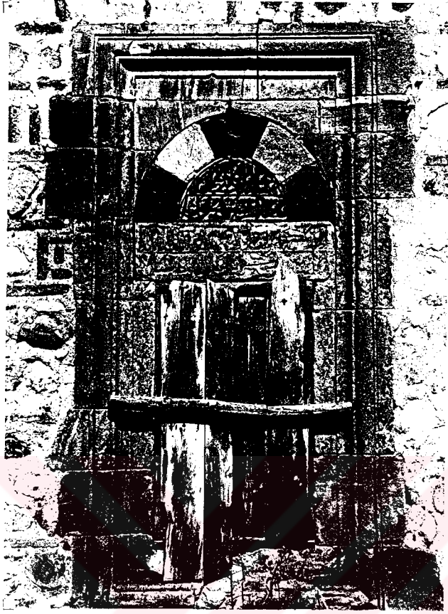
Resim 27- Gümüş Hacı Halil Paşa Medresesi. Güney kanadında yer alan derslane eyvanının penceresi.
