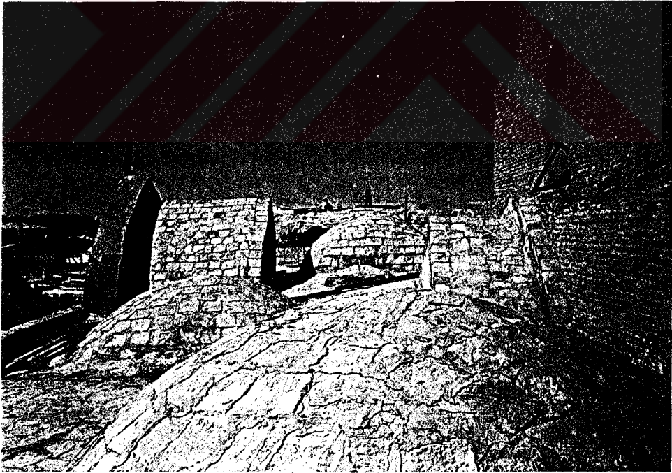
Fot. 10- Hoca Zaynutdin Camii. Harimin batısındaki mekanların üst örtüsü.
