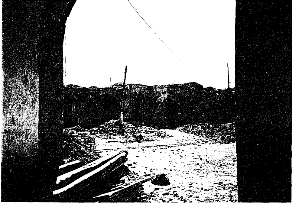
Fot. 205- Hoca Kalon Camii. Avlunun güneybatıcephesi.
