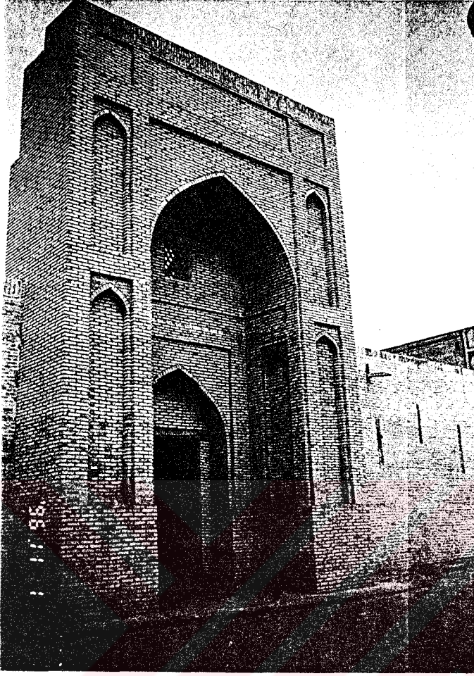
Fot. 165- Kalyan Minare Camii.
