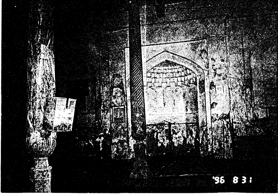
Fot. 143- Şoyahsi Camii. Mihrap.
