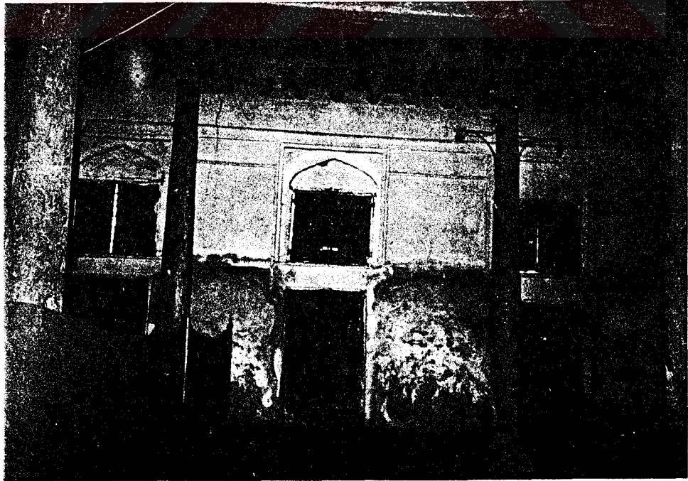
Fot. 138- Şoyahsi Camii. Harim güney duvarı.
