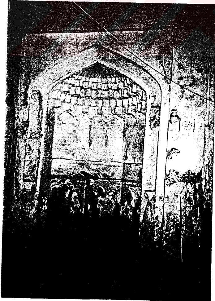
Fot. 142- Şoyahsi Camii. Mihrap.
