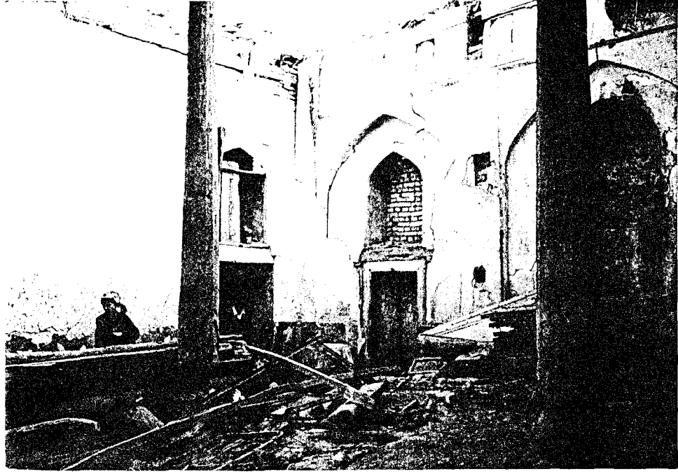
Fot. 155- Şohi Zondcil Camii. Harimin güneyduvarının doğu tarafı.
