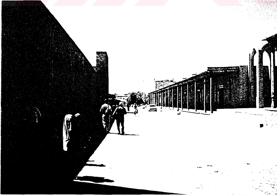
Fot. 166- Kalyan Minare Camii.Kuzey Cephesi.
