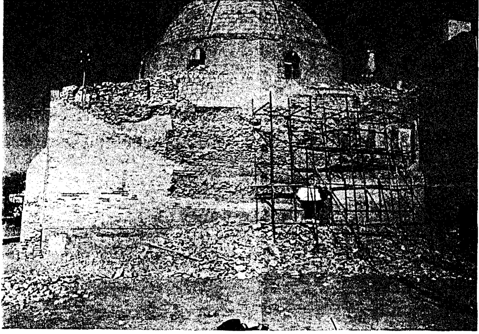
Fot. 61- Bolo Hauz Camii. Güney cephesi.
