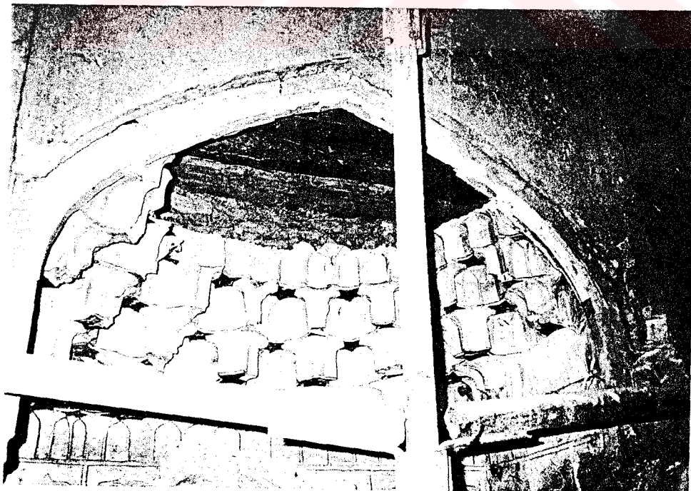
Fot. 222- Valida Hudaydod Camii.
