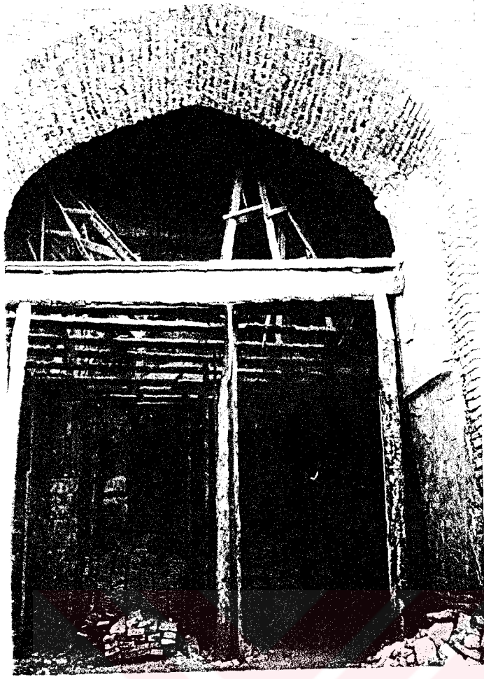
Fot. 219- Valida Hudaydod Camii.
