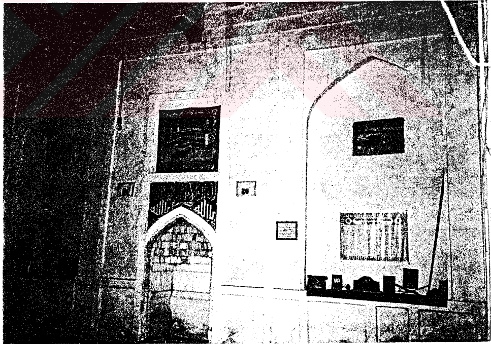
Fot. 121- İmam Gazali Camii. Batı duvarı.
