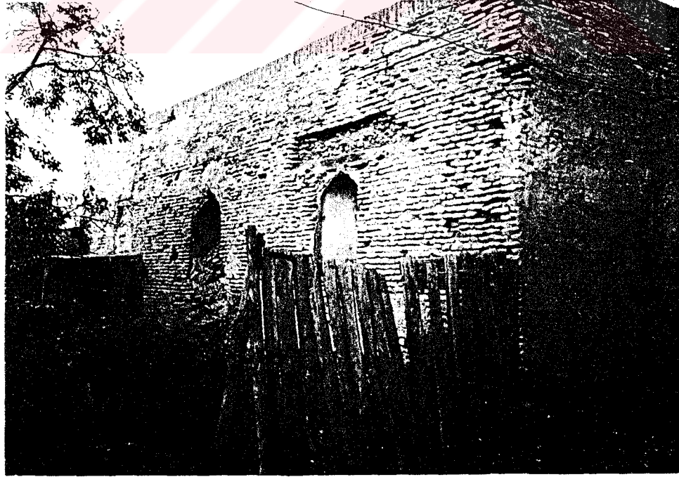
Fot. 148- Şohi Zandcil Camii. Batı Cephesi
