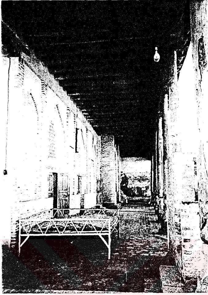
Fot. 211- Valida Hudaydod Camii.
