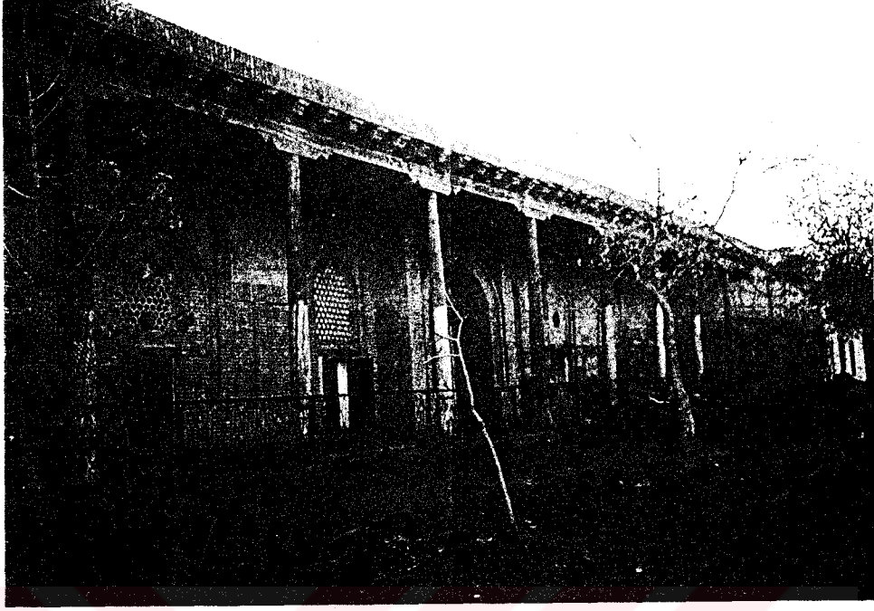
Fot. 207- Valida Hudaydod Camii.Kuzeyden genel görünüşü.
