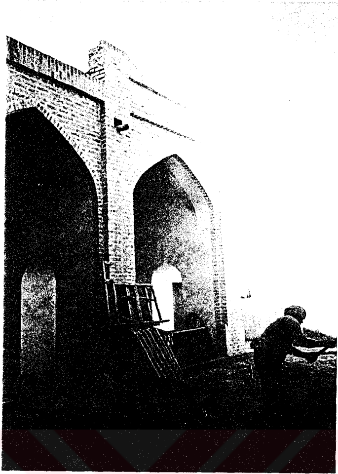
Fot. 213- Valida Hudaydod Camii.
