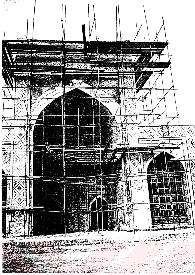
Fot. 179- Kalyan Minare Camii.
