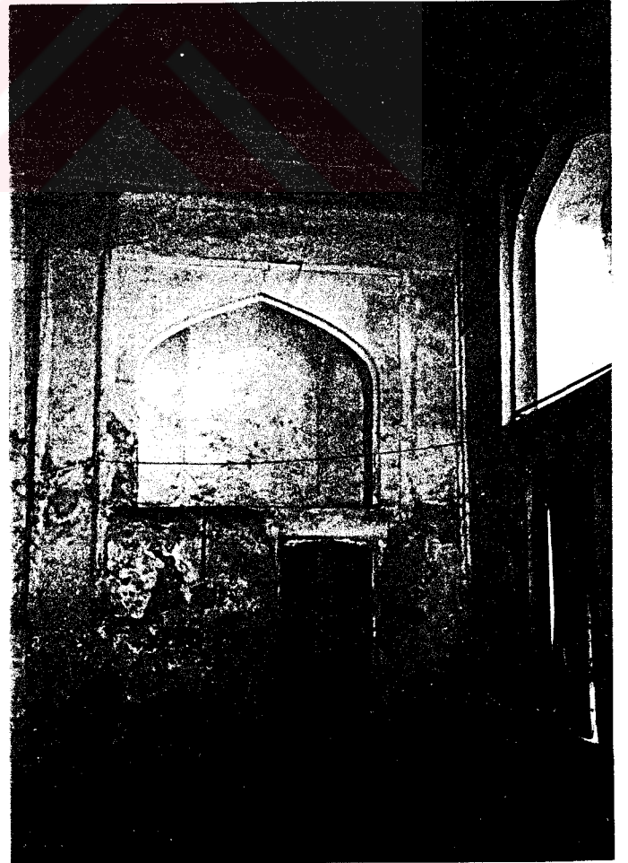
Fot. 146- Şoyahsi Camii. Harim, batı duvarındaki çilehane girişi.
