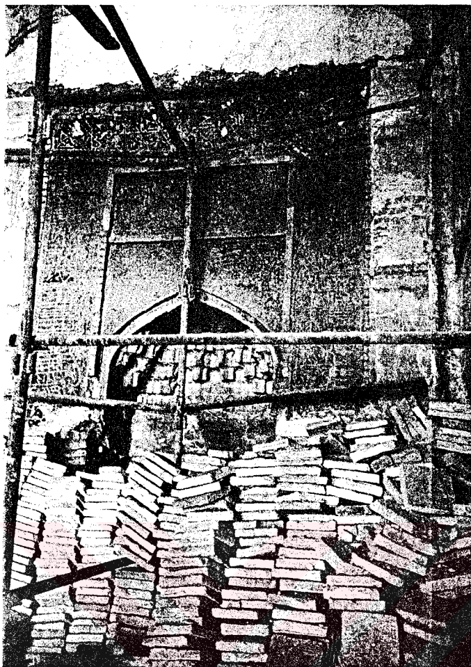
Fot. 221- Valida Hudaydod Camii.
