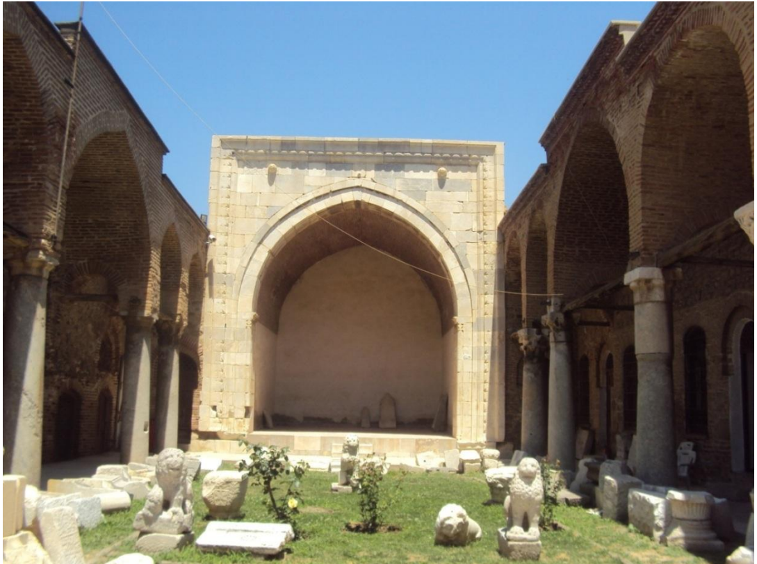
Resim 71 Akşehir Taş Medrese Eyvan
