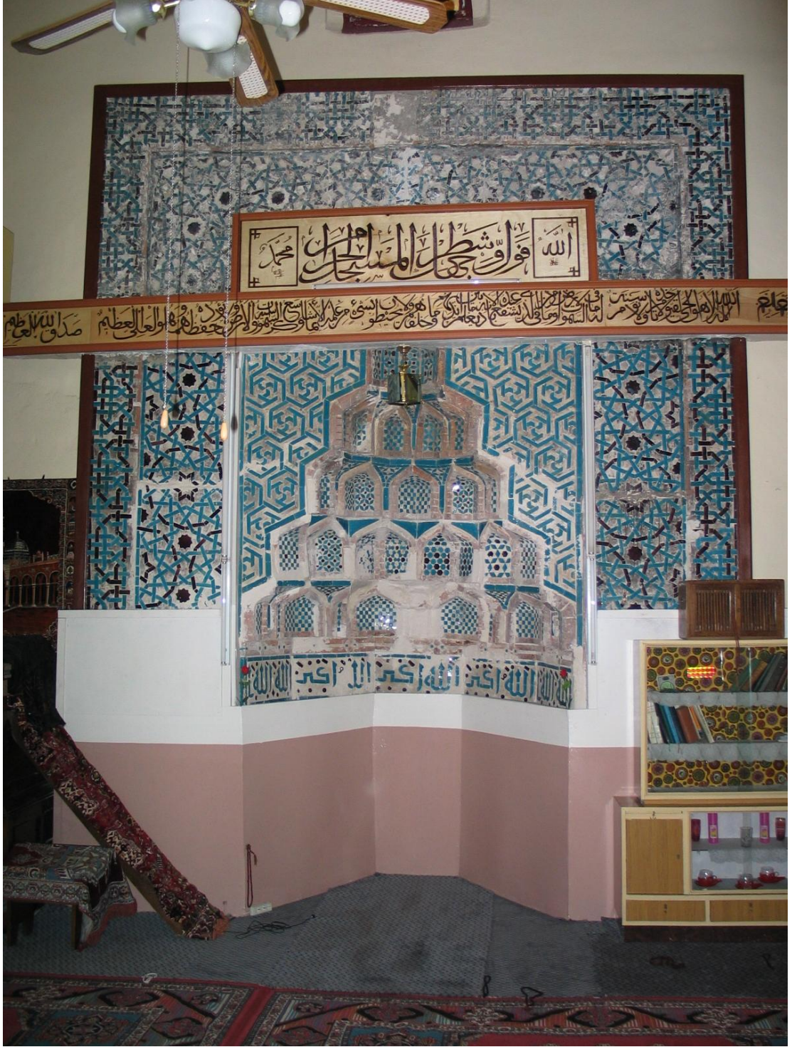
Resim 77 Akşehir Ulu Camii Restorasyon Öncesi Mihrabı
