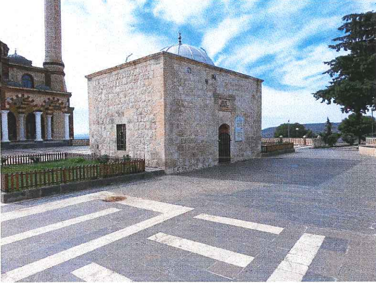
Foto 2. 88. Şeyh Muhammed Bedevi Türbesi Kaynak: (Bahar, 2014)
