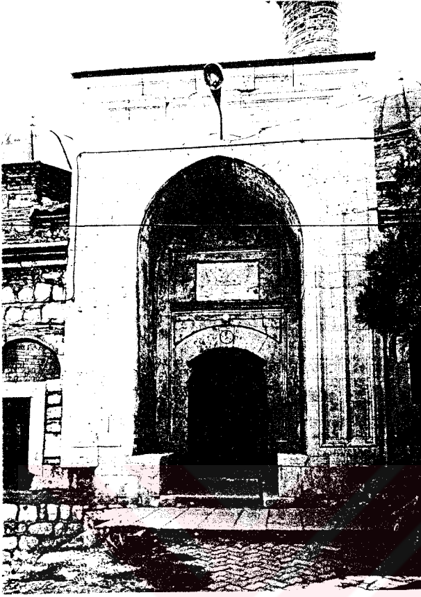
Resim 31- Amasya Yakub Paşa Zaviyesi batı taçkapısı. Genel görünüş.
