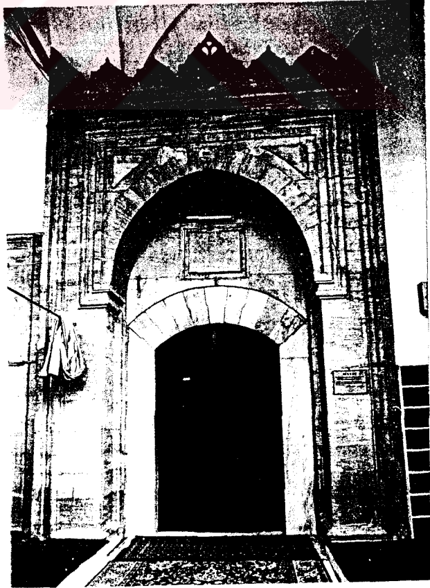
Resim 186- Malkara Gazi Ömer Bey Camii taçkapısı. Genel görünüşü.
