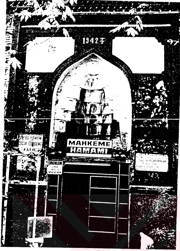
Resim 55- Bursa Mahkeme (İbrahim Paşa) Hamamı taçkapısı. Genel görünüş.
