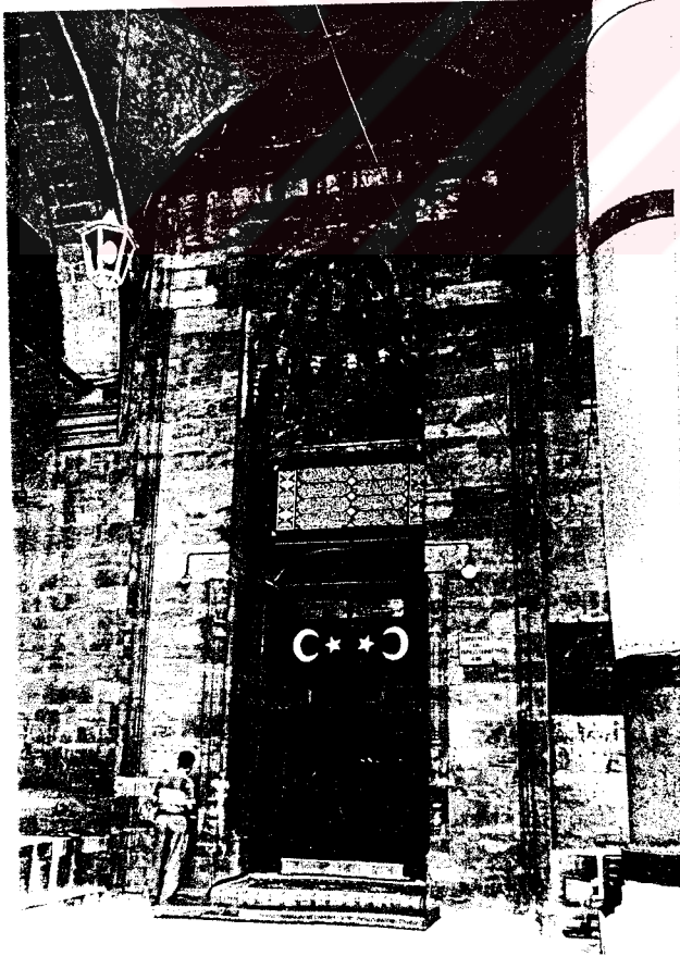
Resim 152- İstanbul Davud Paşa Camii taçkapısı. Genel görünüş.
