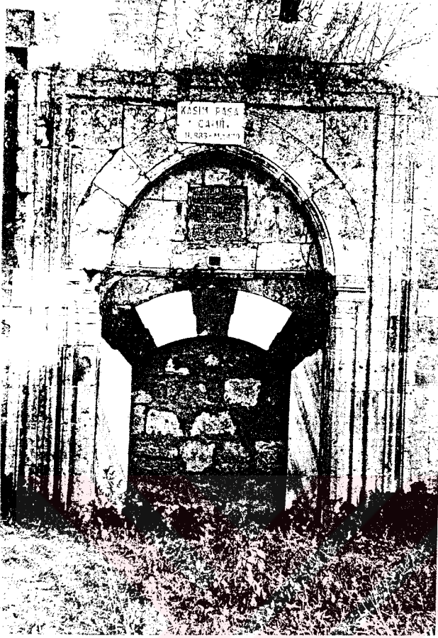
Resim 135- Edirne Kasım Paşa Camii taçkapısı. Genel görünüş.
