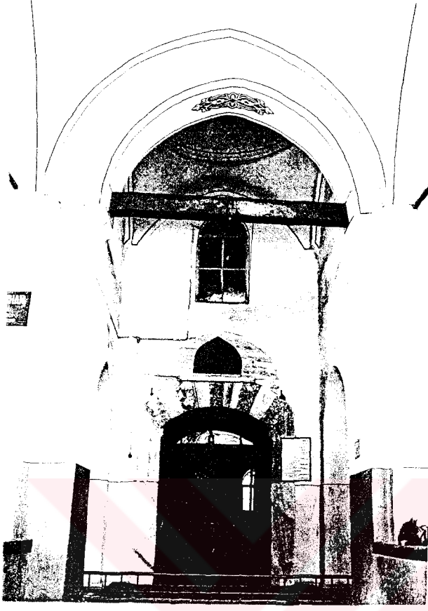
Resim 1- Bursa Orhan Camii taçkapısı. Genel görünüş.
