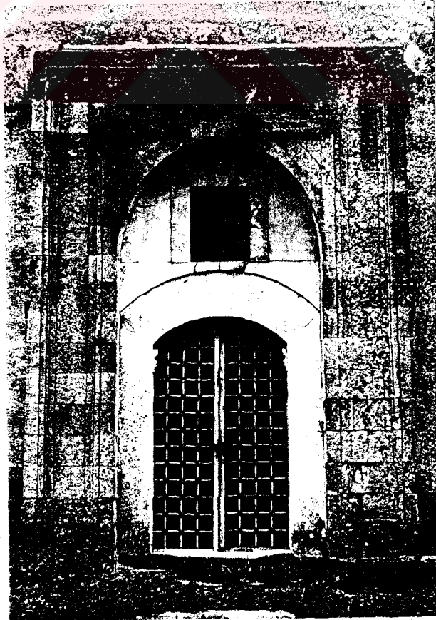
Resim 174- Edirne II. Bayezid Camii doğu tabhanesi doğu taçkapısı. Genel görünüş.
