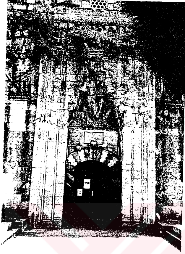
Resim 191- Edirne Süleyman Paşa Camii taçkapısı. Genel görünüş.
