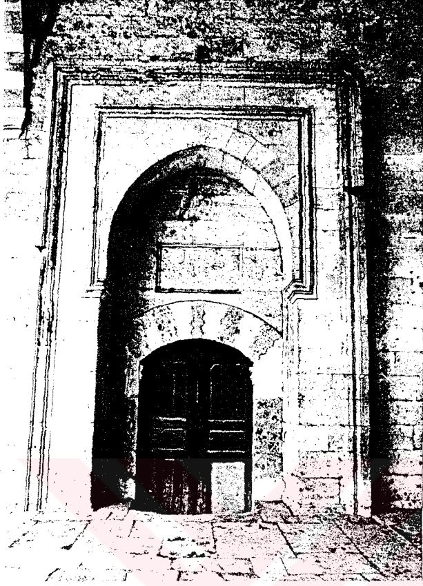
Resim 175- Edirne II. Bayezid Camii doğu tabhanesi kuzey taçkapısı. Genel görünüş.
