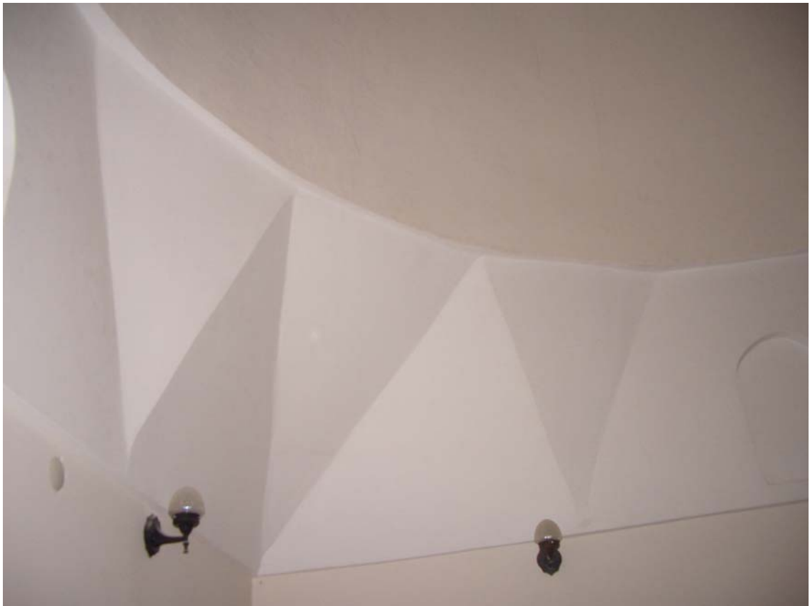
Fotoğraf 40: Çukur Hamam ılıklik mekanı kubbe geçişleri
