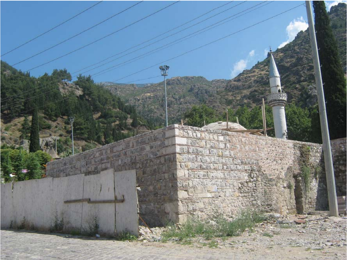
Fotoğraf 62: Gülgün Hatun Hamamı restorasyon öncesi kuzey cephe, küllhan
