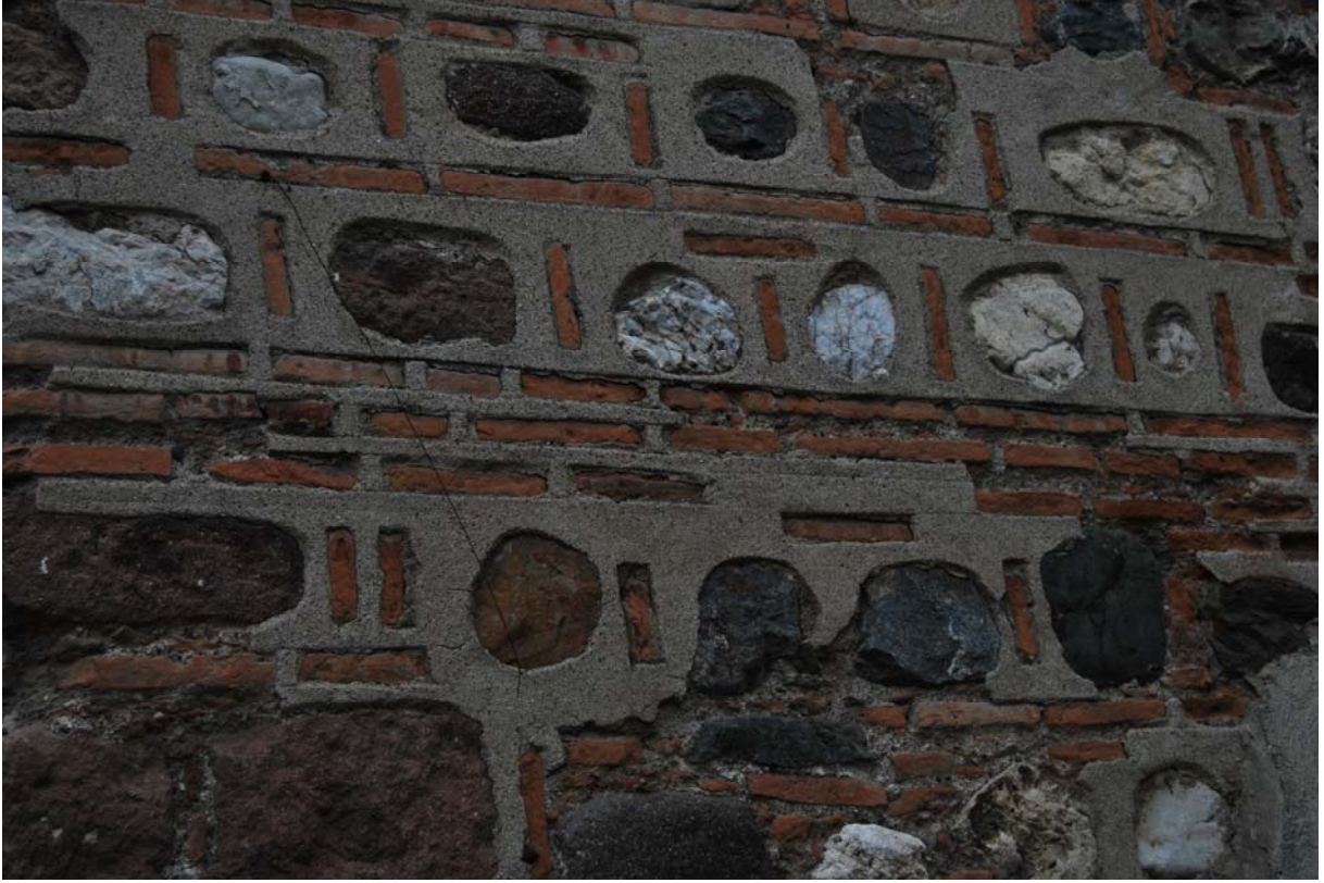
Fotoğraf 155: Karaköy Hamamı Batı Cephe Duvar Örgüsü
