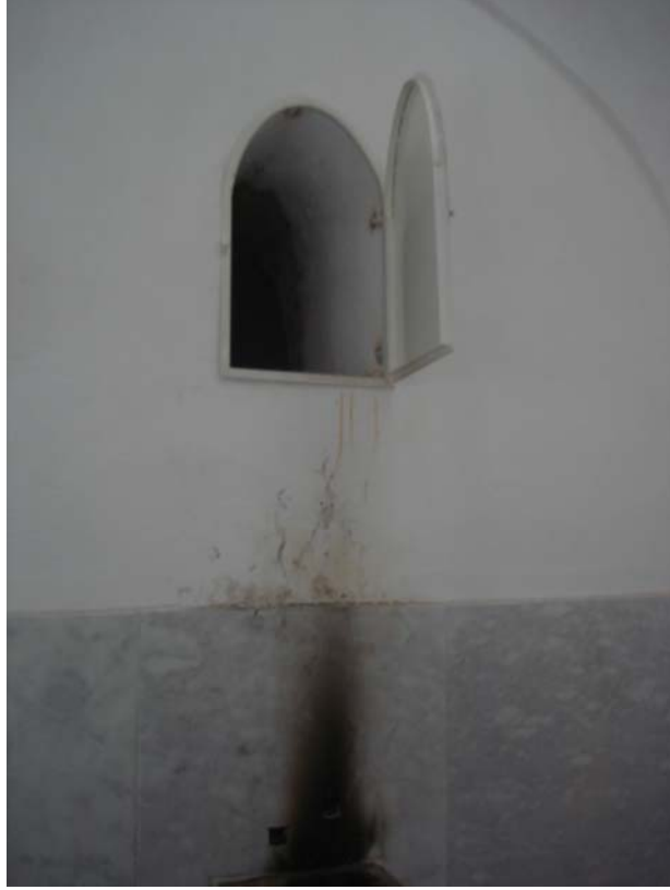
Fotoğraf 77: Dilşikar Hatun Hamamı erkekler kısmı güneybatı halvette bulunan kontrol penceresi
