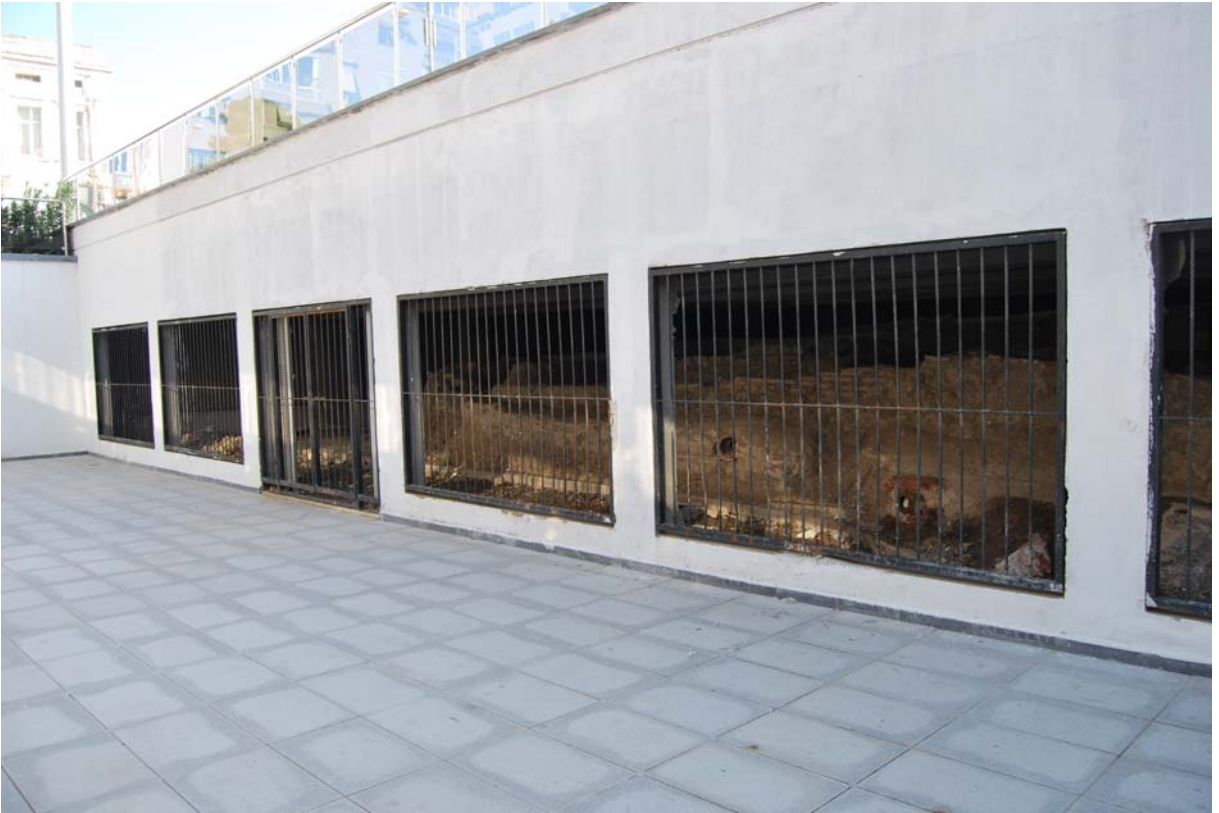
Fotoğraf 200: Manisa Saray (Otopark) Hamamı Güney Cephe Genel Görünüm
