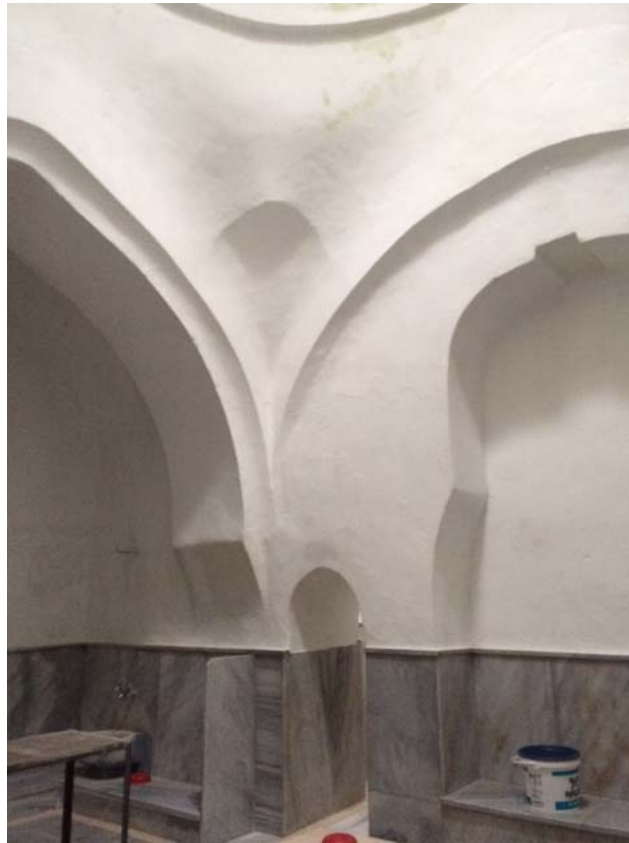
Fotoğraf 101: Alaca (Hamza Bey) Hamamı Sıcaklık Kubbe Geçişleri ve Kemerler
