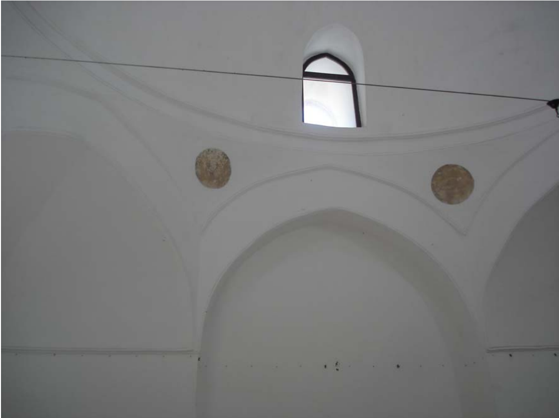
Fotoğraf 83: Dilşikar Hatun Hamamı soyunmalık kubbe geçişleri
