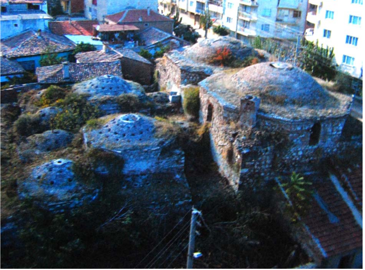
Fotoğraf 65: Gülgün Hatun Hamamı restorasyon öncesi genel görünüm (VGM Arşivi)
