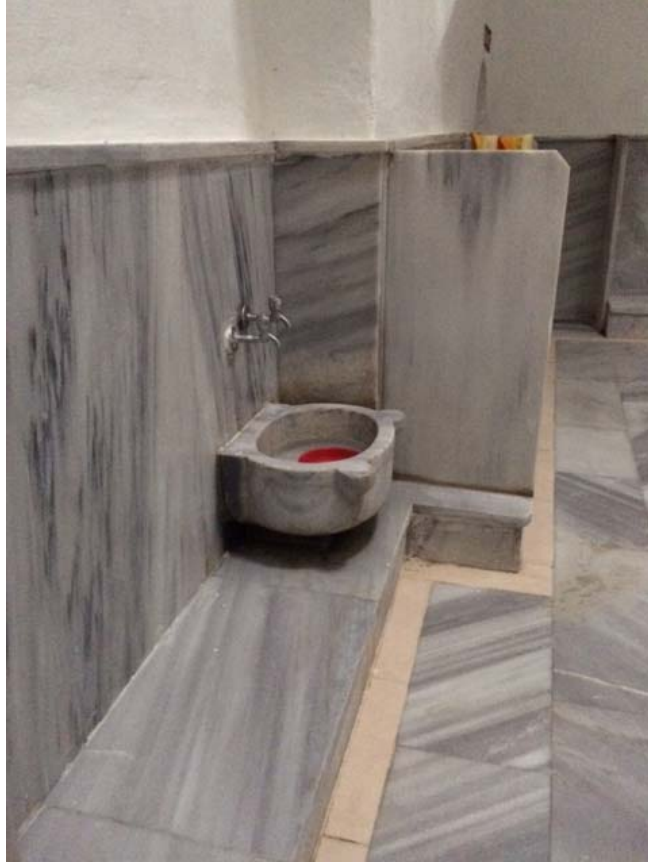
Fotoğraf 106: Alaca (Hamza Bey) Hamamı Sıcaklıkta Bulunan Seki ve Kurna
