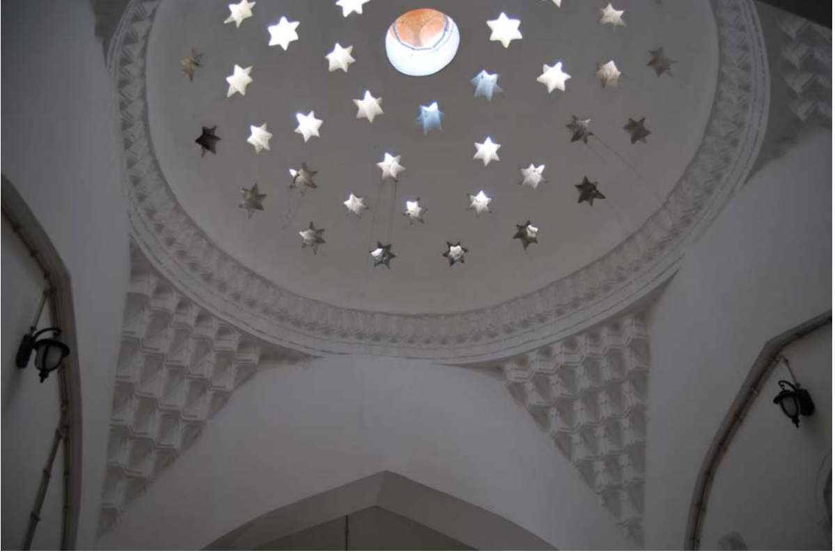
Fotoğraf 25: Hüsrev Ağa Hamamı sıcaklık orta mekan kubbesi ve geçişleri
