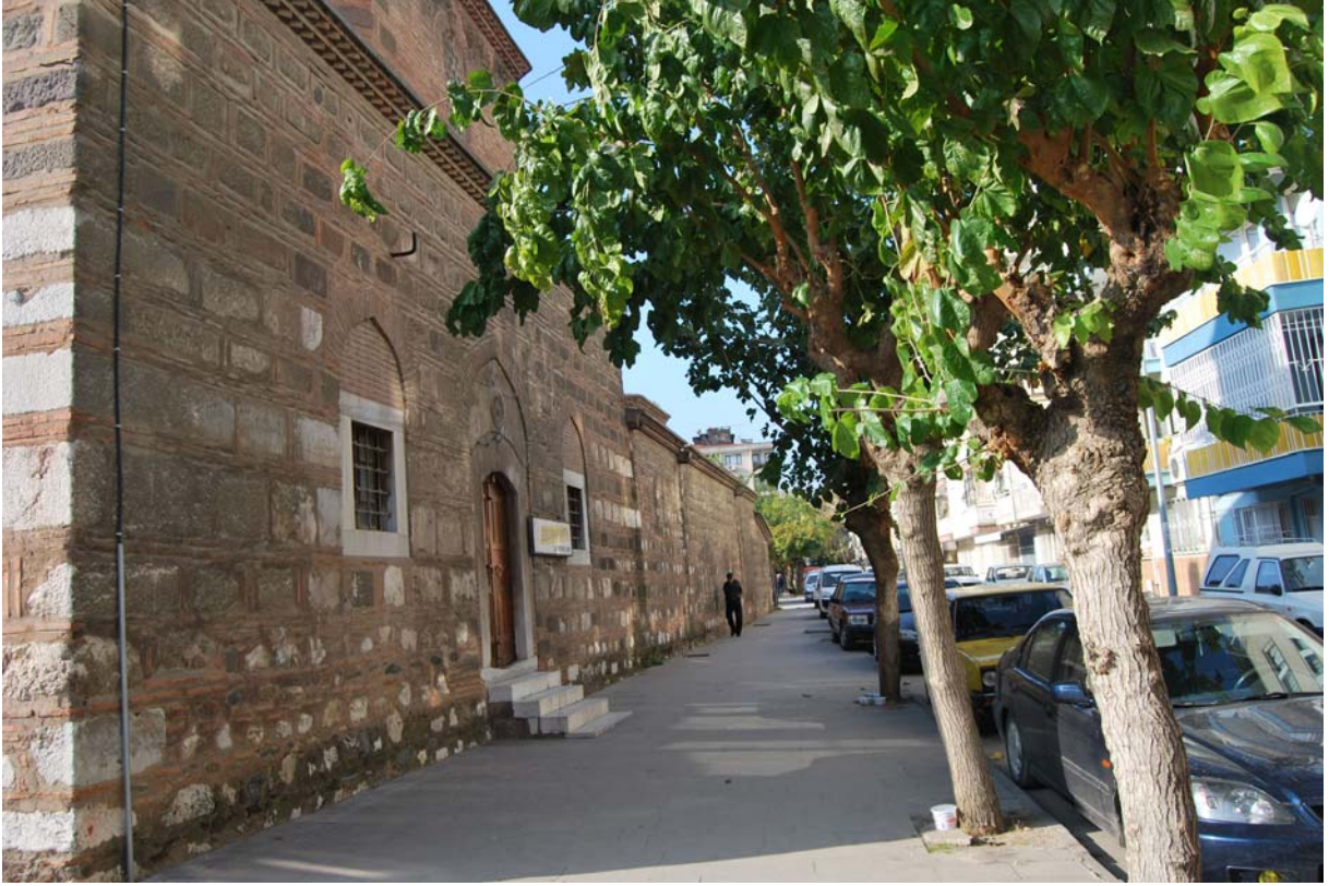
Fotoğraf 112: Hafsa Sultan Hamamı Güney Cephe
