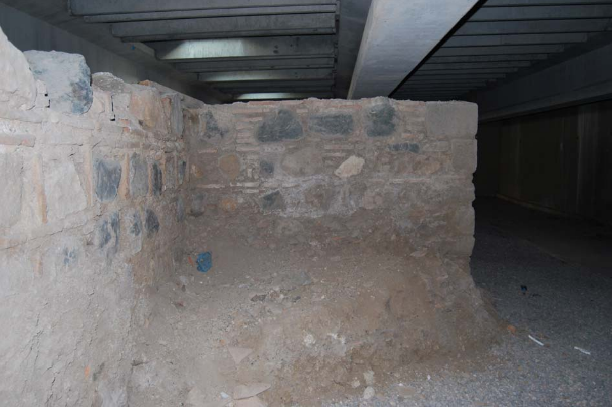
Fotoğraf 195: Manisa Saray (Otopark) Hamamı Kuzeybatı Cephe Duvar Örgüsü
