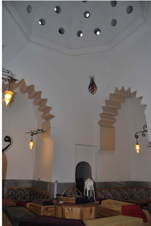
Fotoğraf 150: Karaköy Hamamı Sıcaklık Kubbe Geçişleri ve Dilimli Kemer Uygulaması
