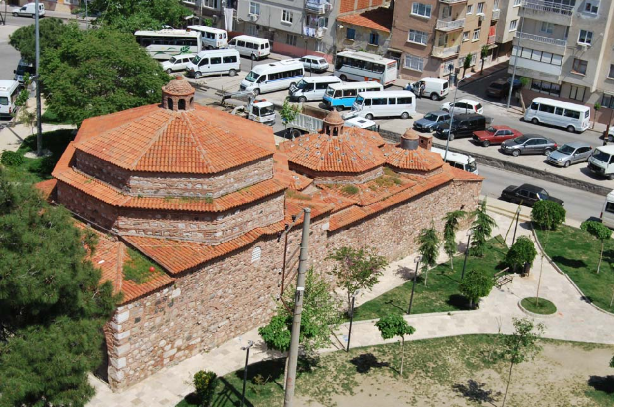
Fotoğraf 1: Hüsrev Ağa Hamamı Restorasyon sonrası genel görünüm
