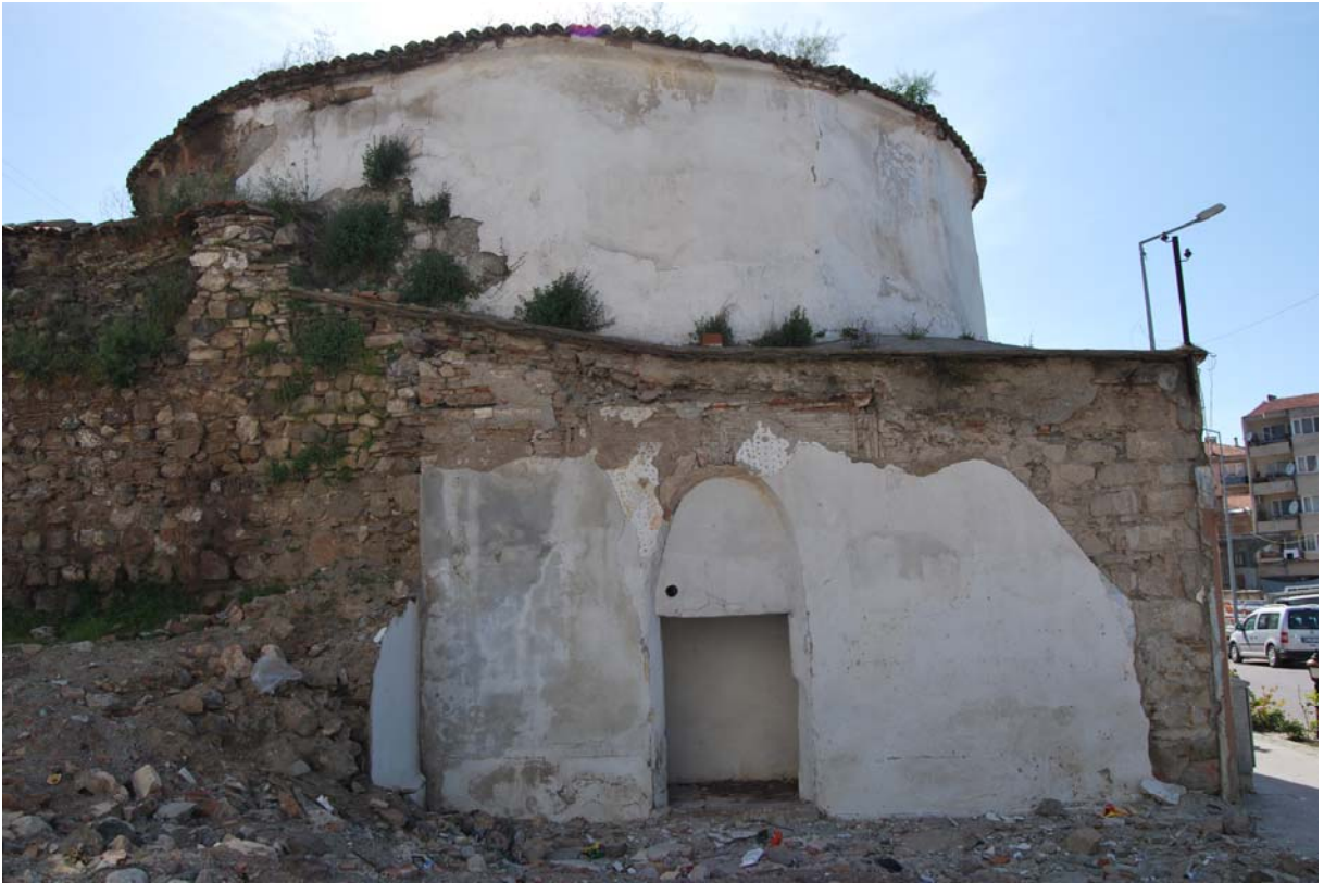
Fotoğraf 89: Alaca (Hamza Bey) Hamamı Tadilat Öncesi Kuzeydoğu Cephe
