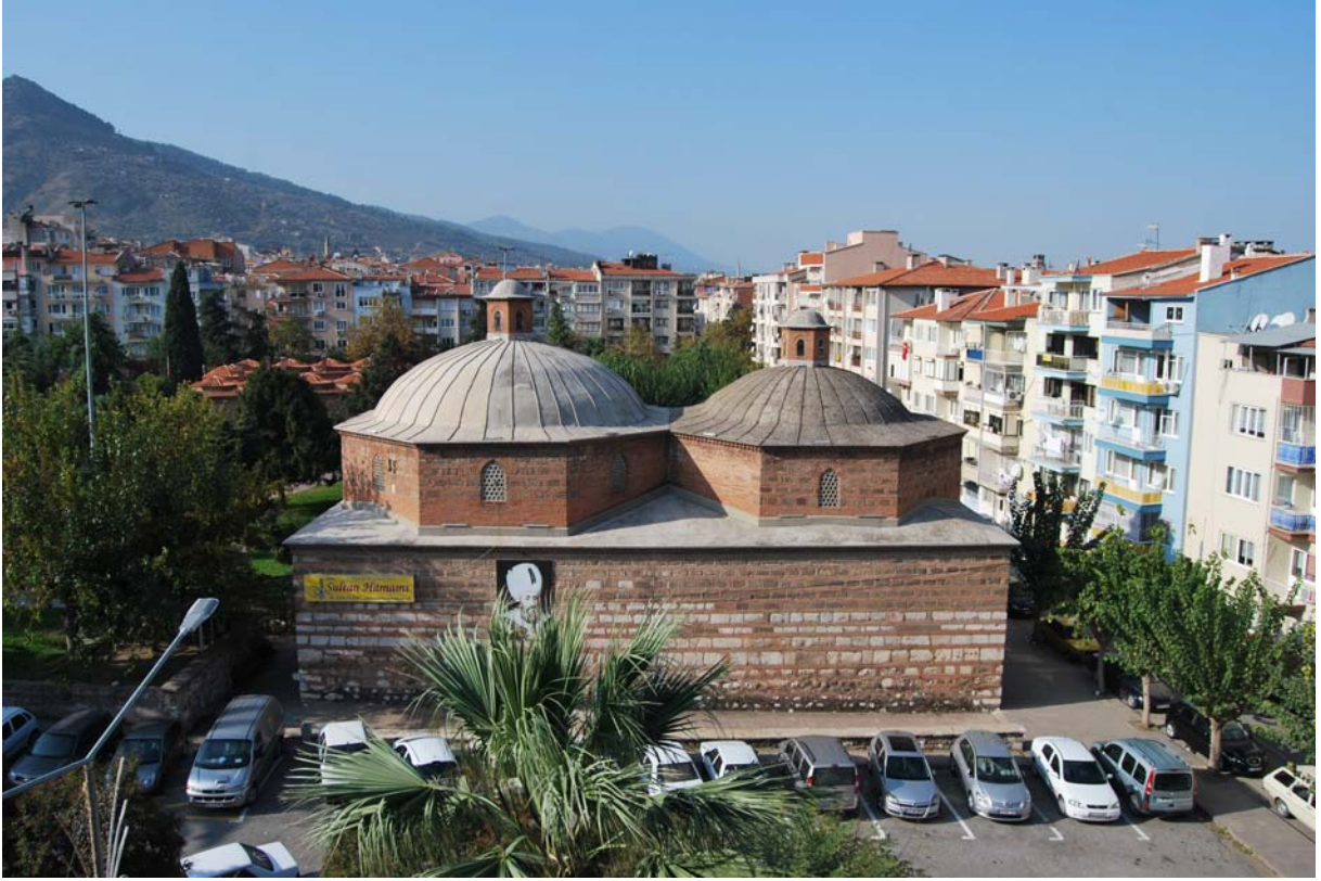
Fotoğraf 110: Hafsa Sultan Hamamı Doğu Cephe
