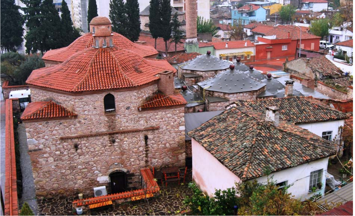
Fotoğraf 66: Gülgün Hatun Hamamı restorasyon sonrası genel görünüm
