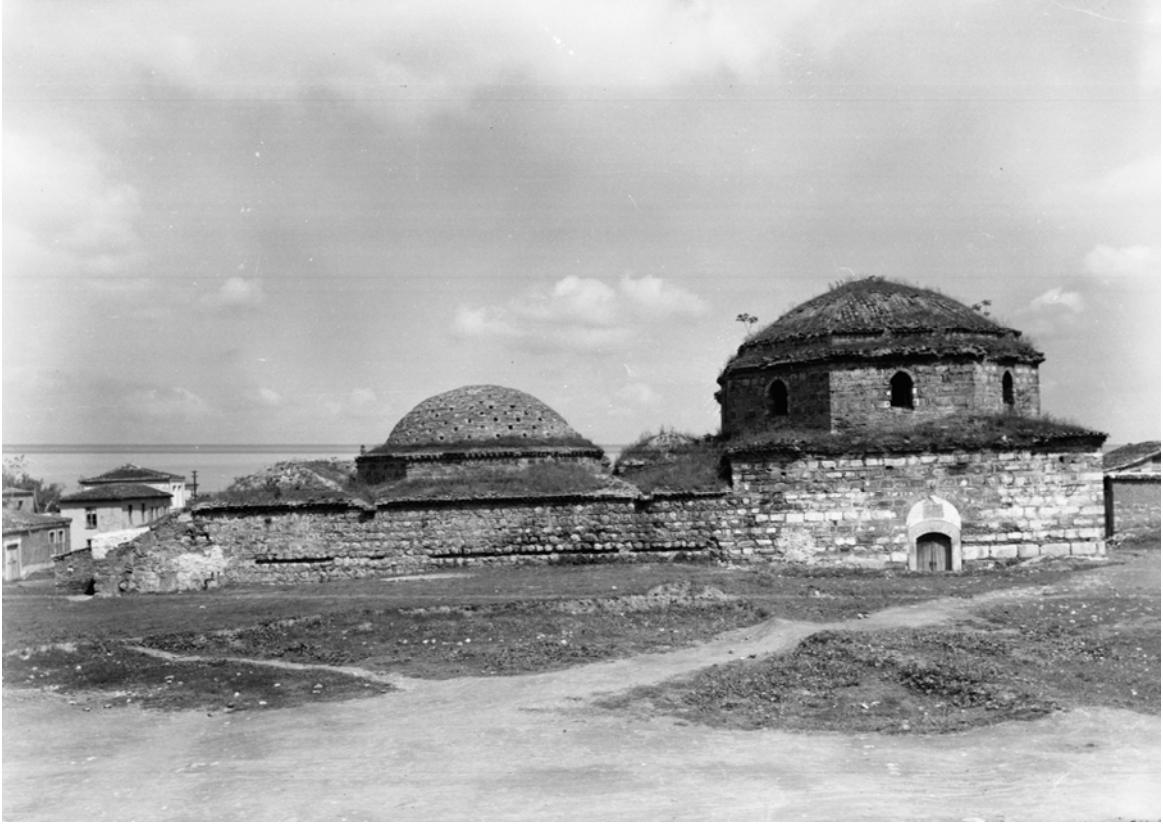
Fotoğraf 108: 1970'lerde Sultan Hamamı, Güney Cephe Genel Görünümü (VGM Arşivi)
