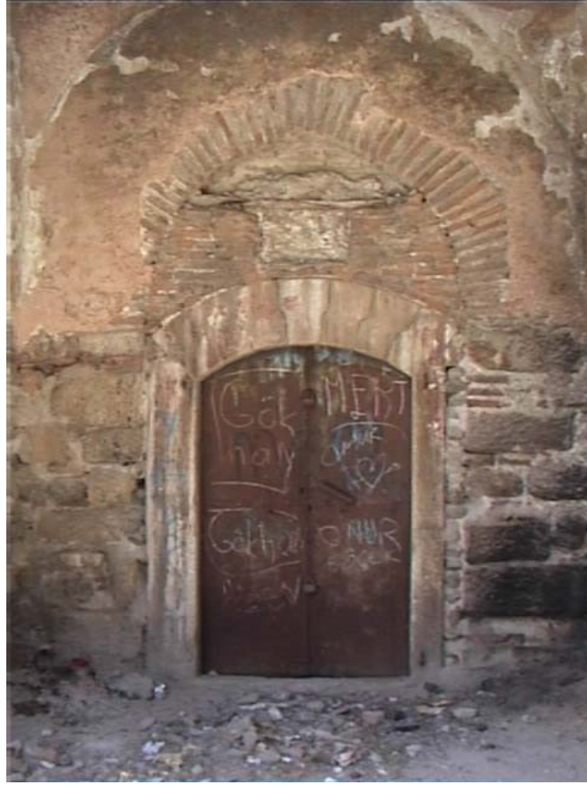
Fotoğraf 11: Hüsrev Ağa Hamamı Soyunmalık üzerindeki sivri hafifletme kemeri (İzmir Vakıflar Bölge Müdürlüğü Arşivinden)
