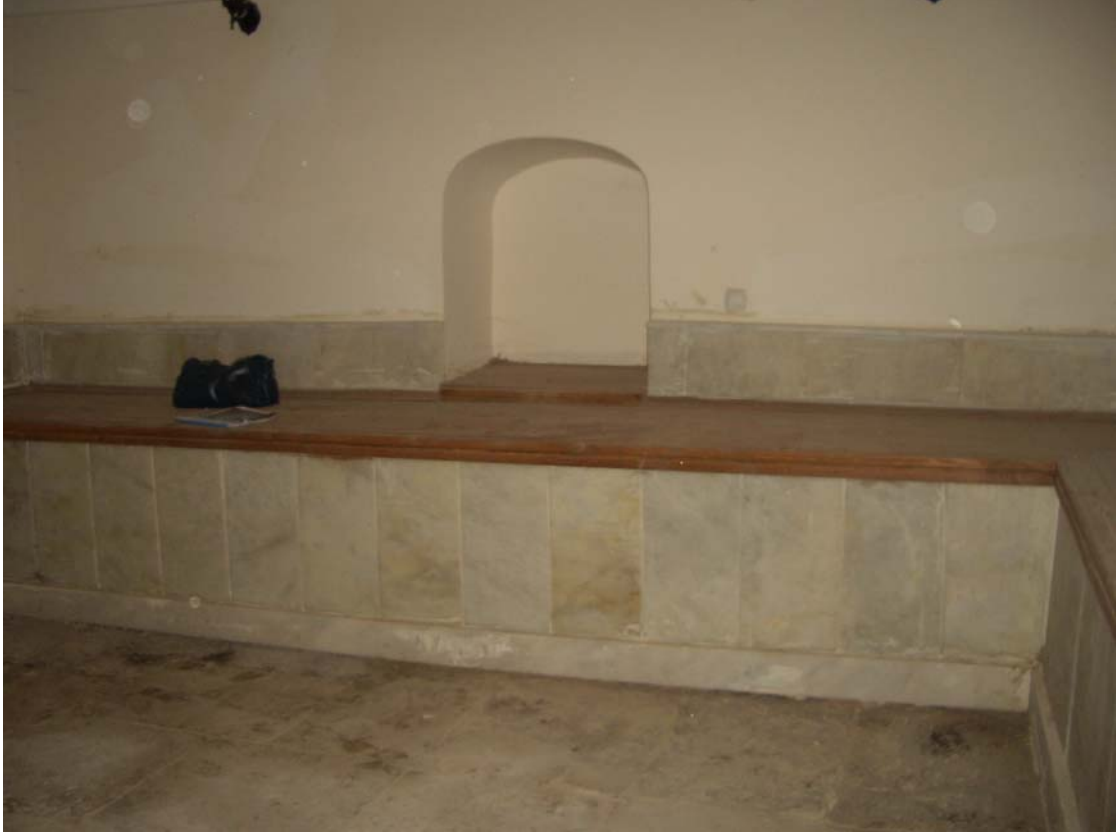
Fotoğraf 41: ukur Hamam ılıklik mekanında yer alan seki ve niş uygulaması
