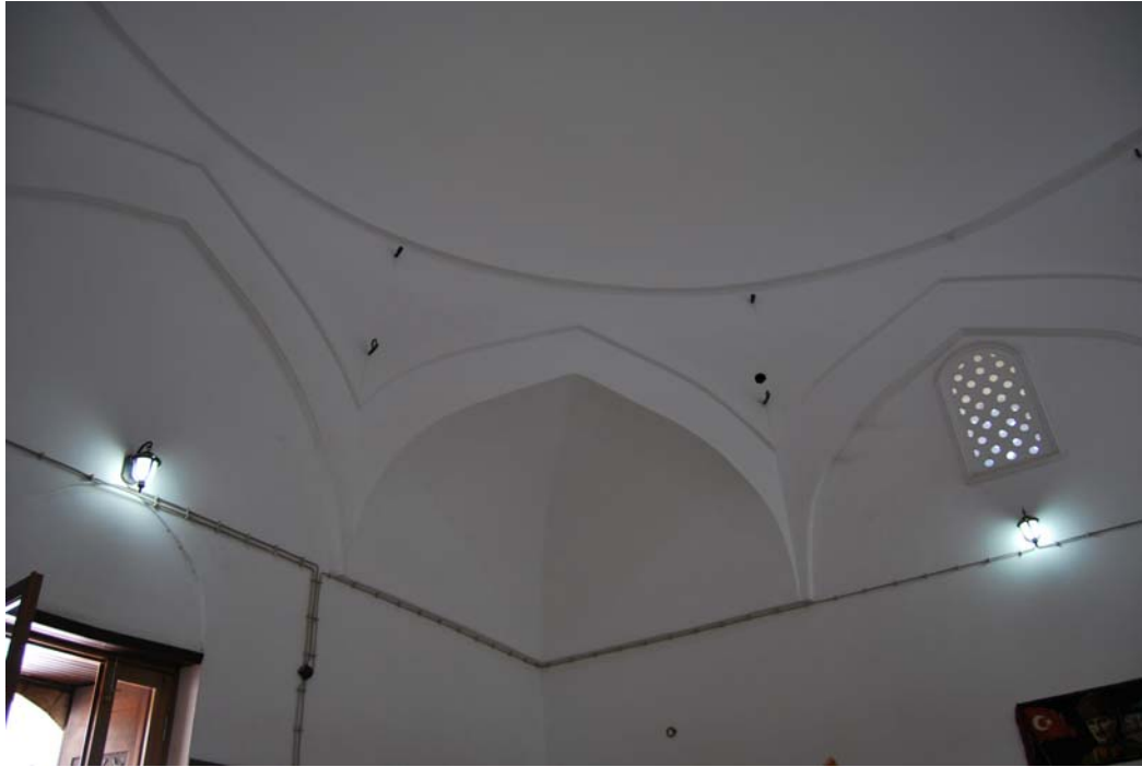
Fotoğraf 12: Hüsrev Ağa Hamamı Soyunmalık kubbe geçişleri ve sivri hafifletme kemerleri
