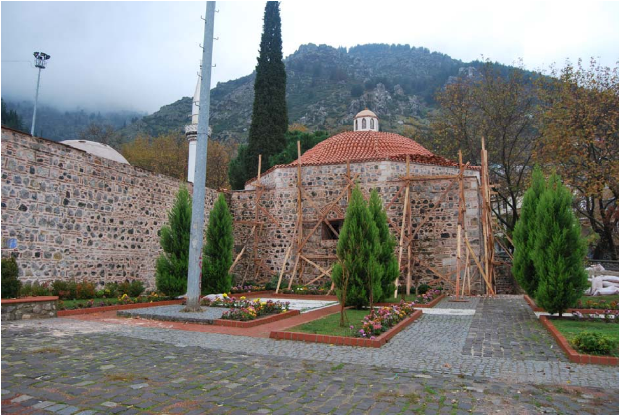
Fotoğraf 64: Glgn Hatun Hamamı restorasyon sonrası kuzeybatı cephe
