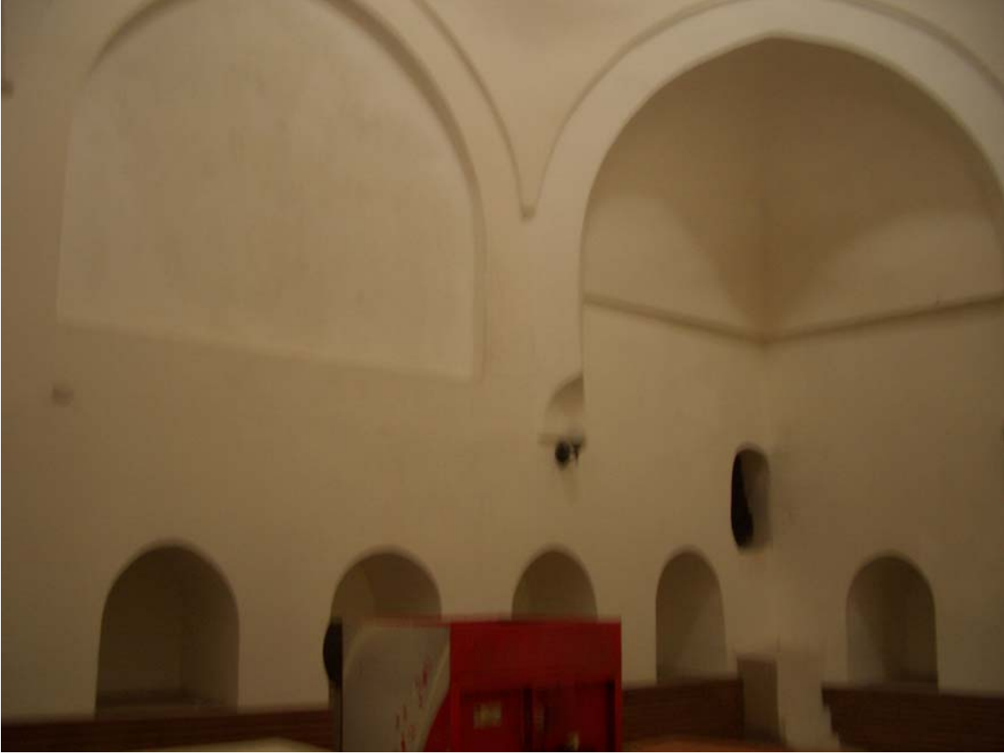
Fotoğraf 39: Çukur Hamam soyunmalık mekanı kubbe geçişleri
