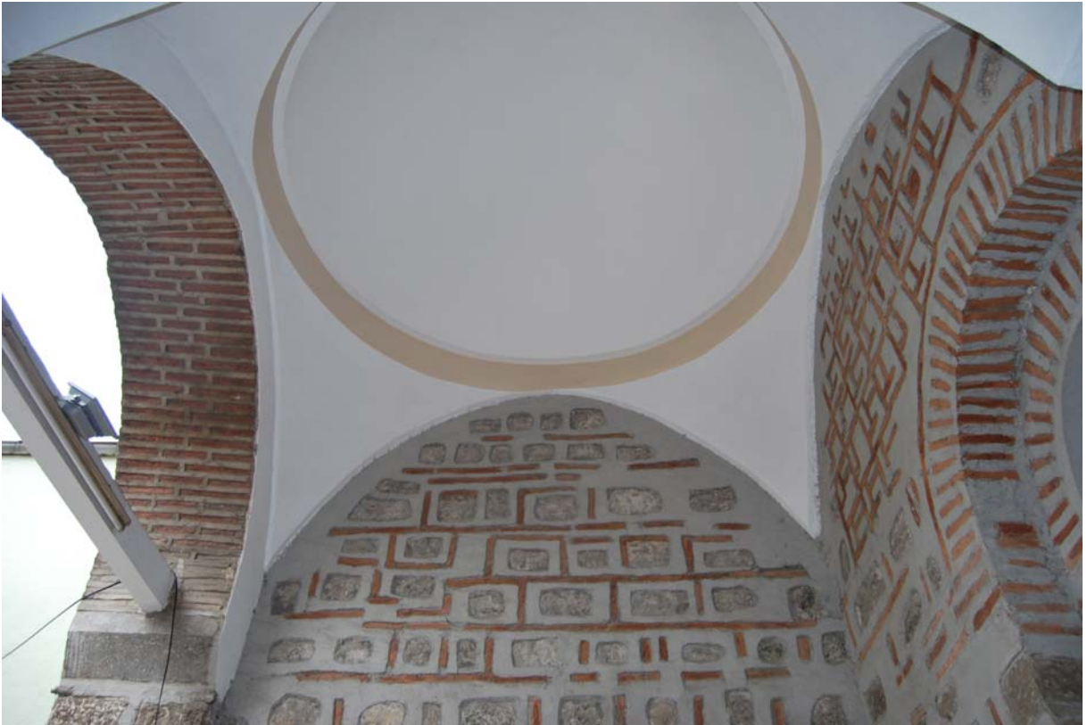
Fotoğraf 132: Karaköy Hamamı Revak Kubbeleri
