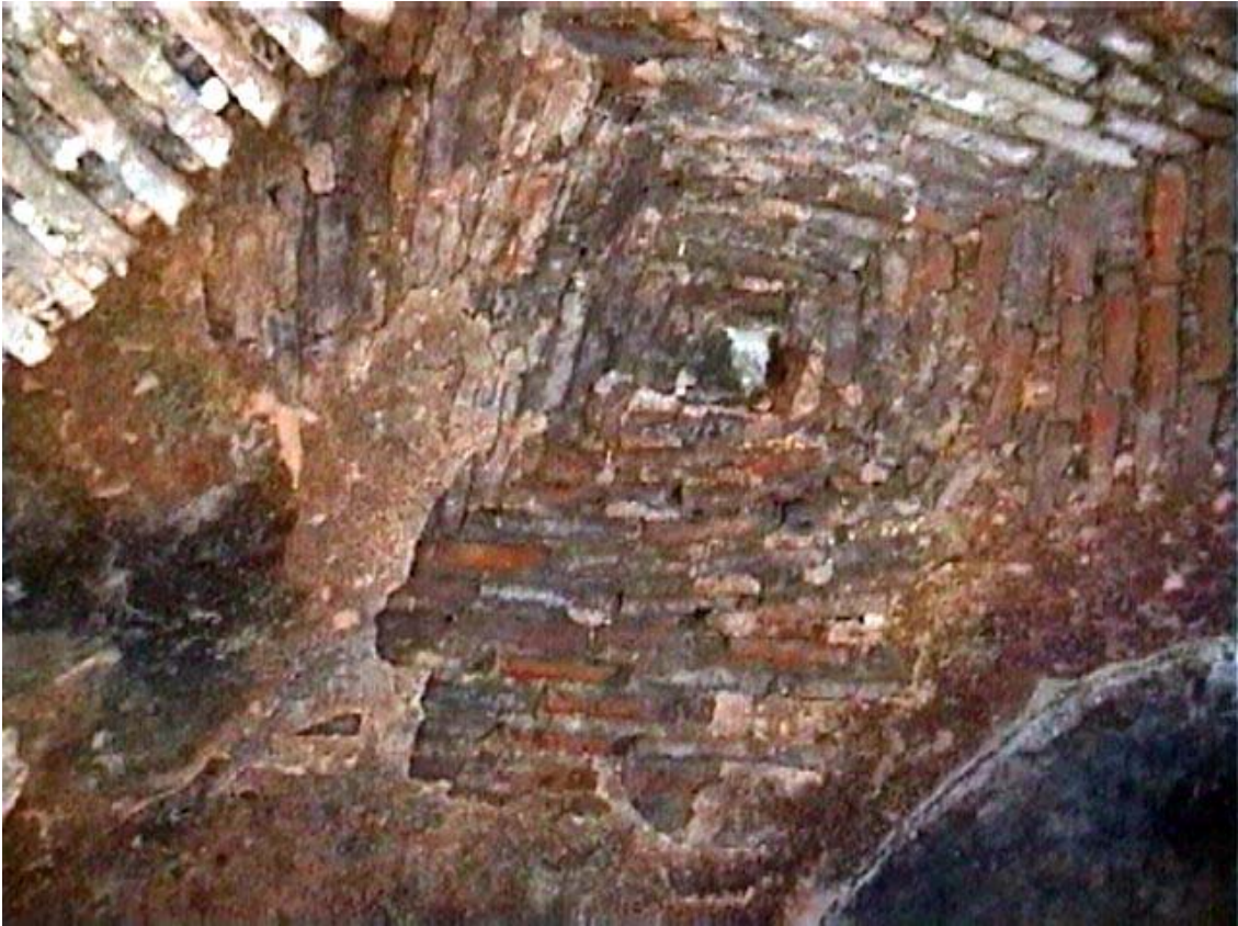
Fotoğraf 8: Hüsrev Ağa Hamamı Giriş eyvanı haç tonoz örtüsü (İzmir Vakıflar Bölge Müdürlüğü Arşivinden)
