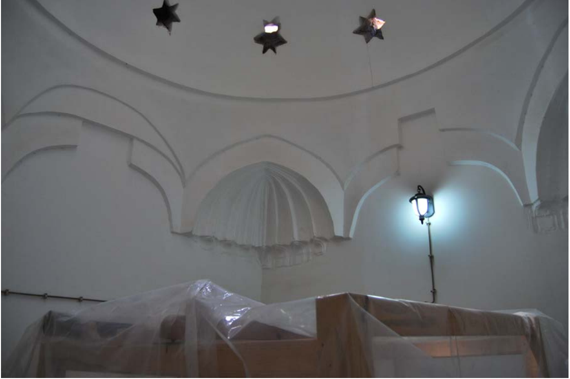
Fotoğraf 31: Hüsrev Ağa Hamamı Güney halvet kubbe geçişleri
