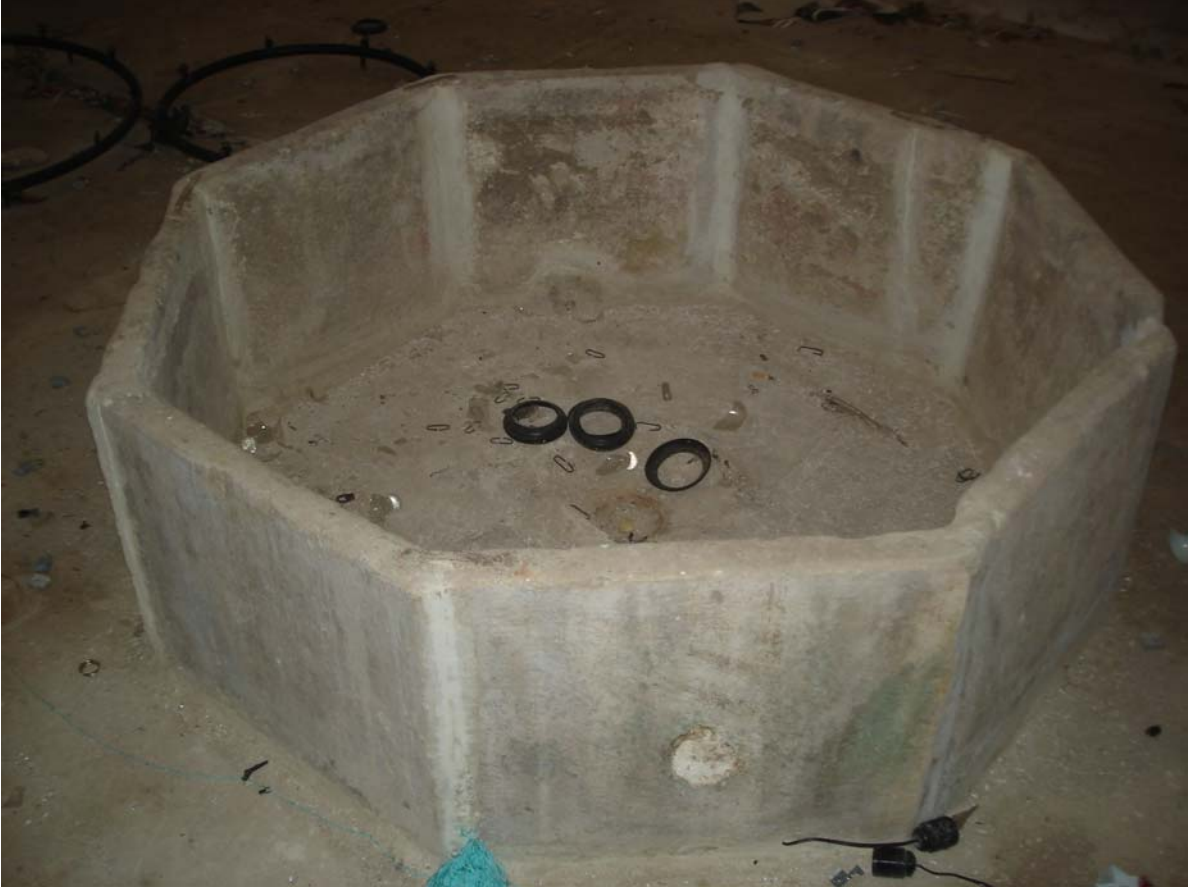
Fotoğraf 69: Dilşikar Hatun Hamamı erkekler kısmı soyunmalığında bulunan süs havuzu
