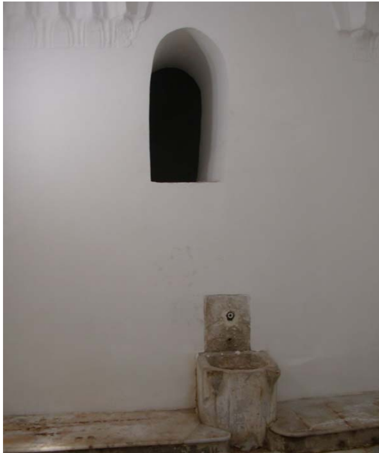
Fotoğraf 32: Hüsrev Ağa Hamamı su deposuna ait kontrol penceresi
