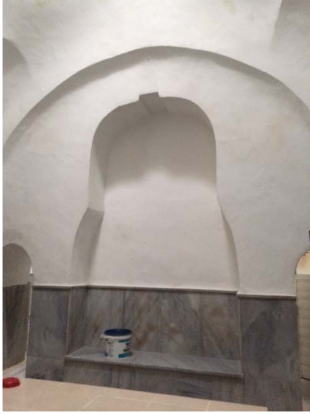
Fotoğraf 104: Alaca (Hamza Bey) Hamamı Sıcaklıkta Bulunan Bursa Tipi Kemer
