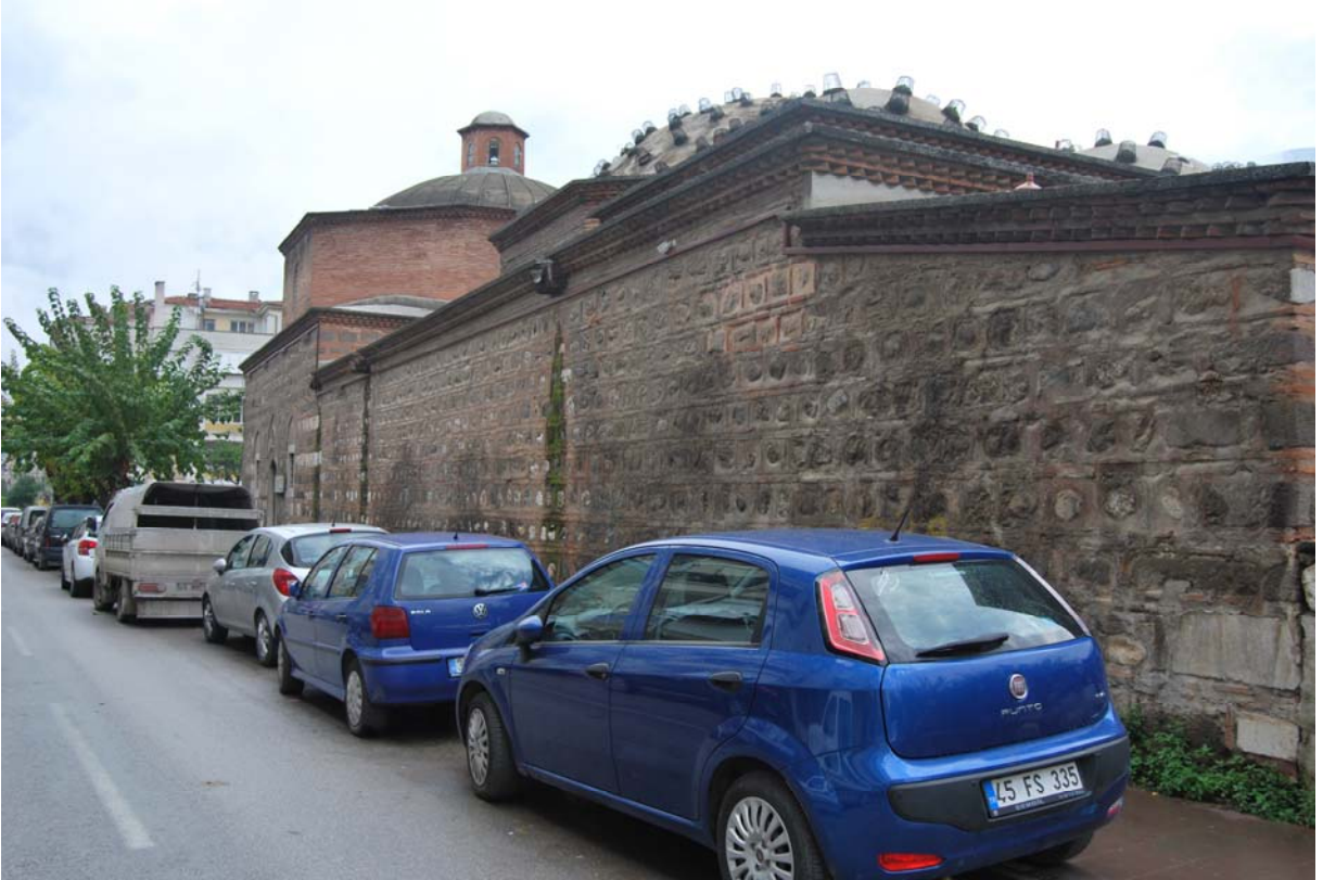
Fotoğraf 116: Hafsa Sultan Hamamı Güneybatı Cephe
