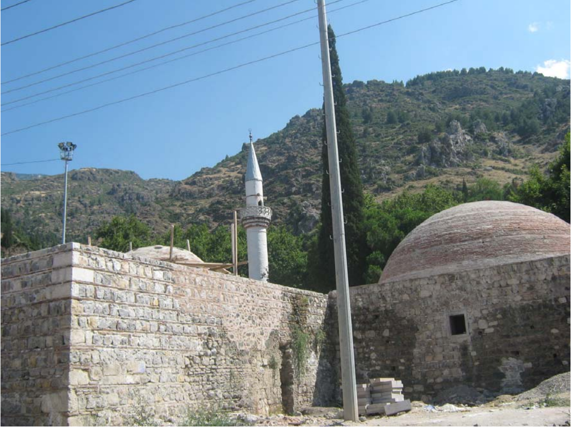
Fotoğraf 61: Gülgün Hatun Hamamı restorasyon öncesi kuzeybatı cephe (VGM Arşivi)
