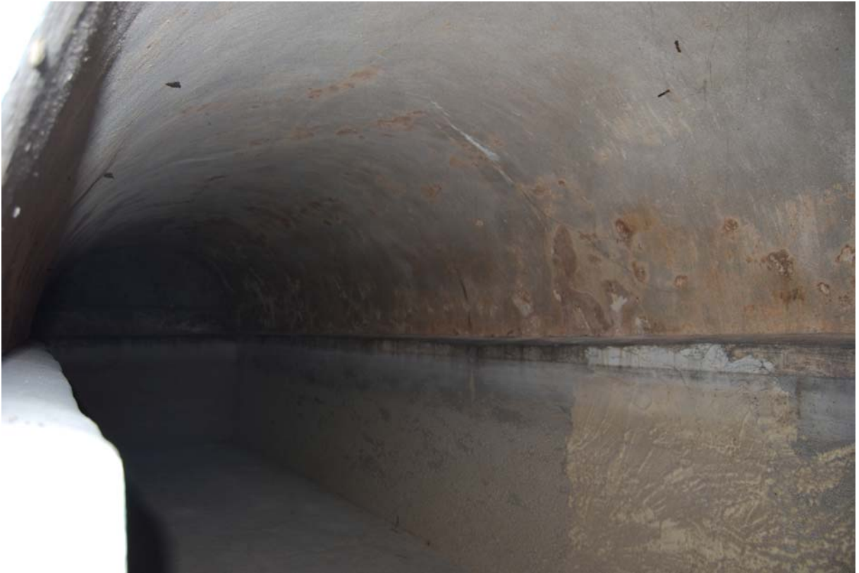
Fotoğraf 154: Karaköy Hamamı Su Deposu
