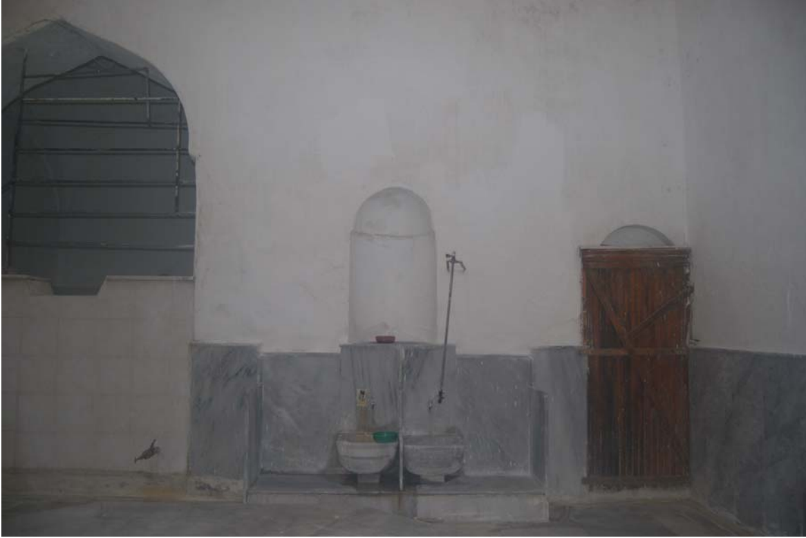
Fotoğraf 173: Cumhuriyet (Yakut Ağa) Hamamı Güneybatı Halvet Girişi ve Niş Uygulaması
