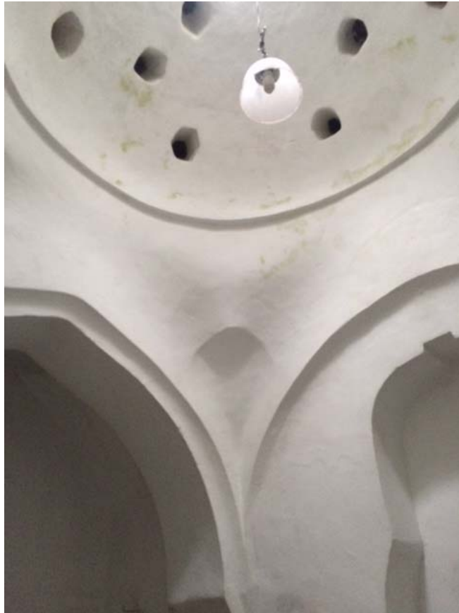
Fotoğraf 107: Alaca (Hamza Bey) Hamamı Sıcaklık Kubbe Geçişi
