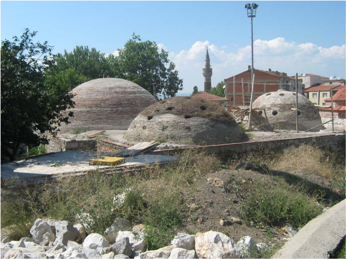
Fotoğraf 60: Gülgün Hatun Hamamı restorasyon öncesi genel görünüm (VGM Arşivi)
