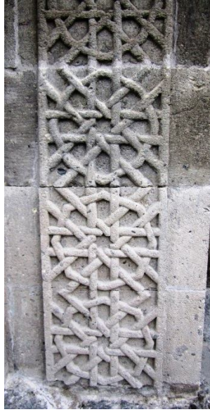
Fotoğraf 30: Gevher Nesibe Darüşşifası "portal-detay"
