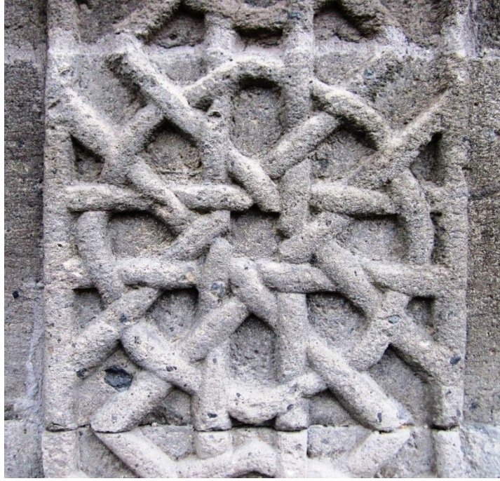
Fotoğraf 31: Gevher Nesibe Darüşşifası “portal-detay”.
