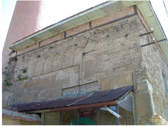
Fotoğraf 66: Akşehir Gdk Minare Mescidi “Restorasyon ncesi” ( http://kulturrestorasyon.com.tr/uygulama.asp?id=13 ) (05.06.2015)
