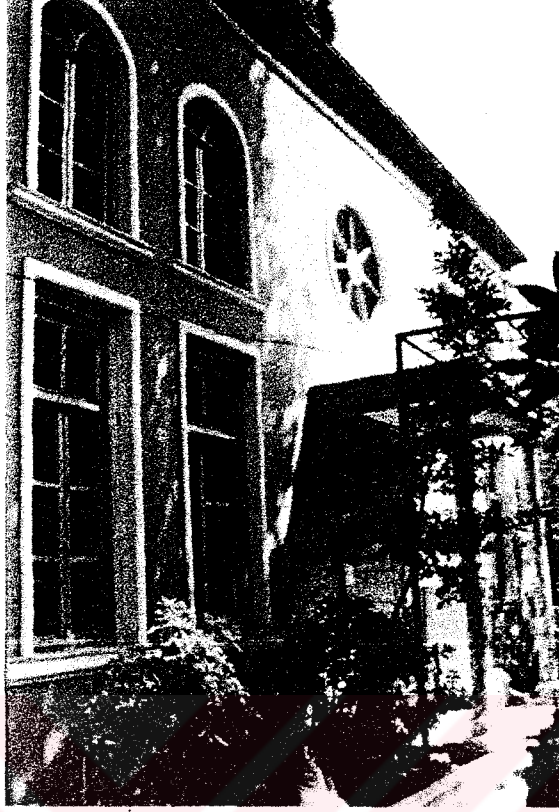
Resim 115 İstanbul Hasköy Maalem, batı cephe
