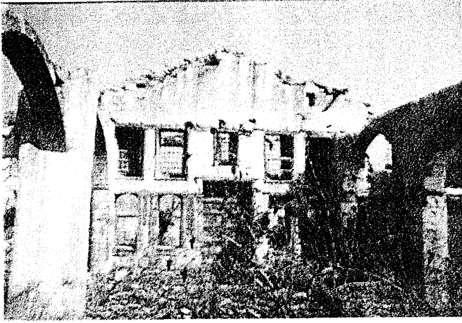
Resim 69 Gaziantep, ibadet mekanı, orta sahından kapiya doğru bakış
