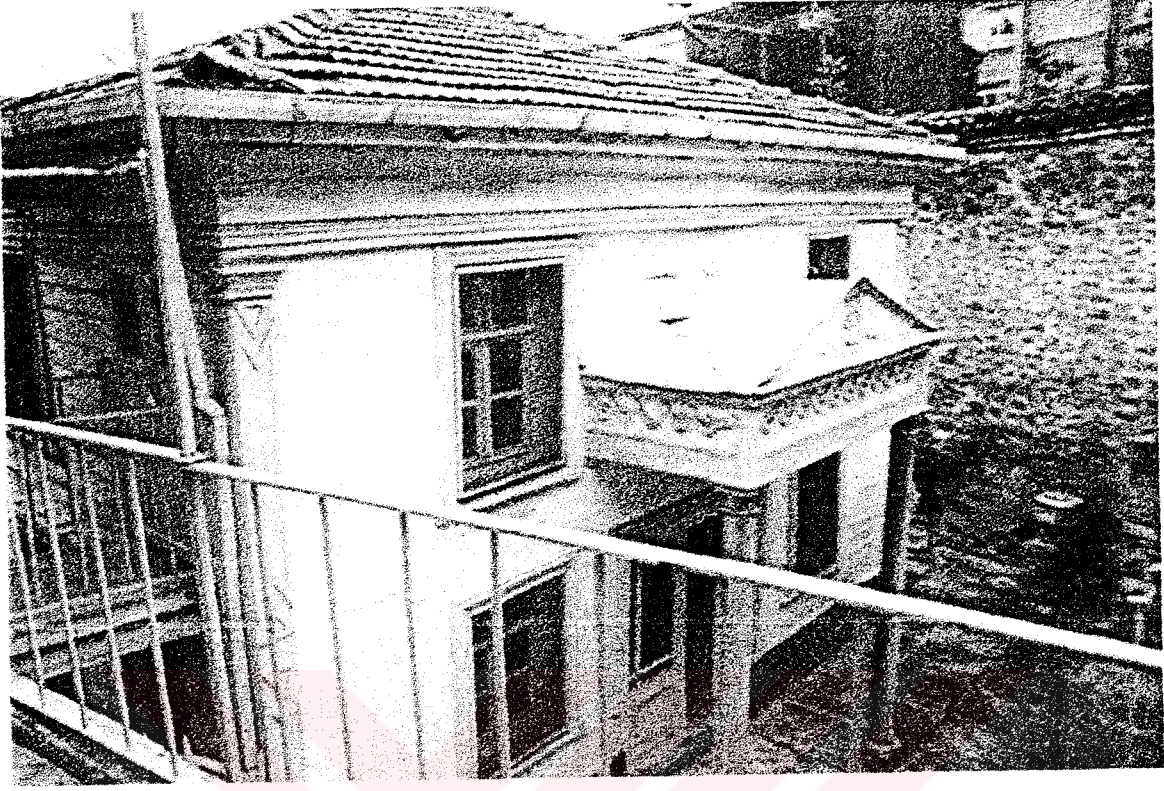
Resim 109 İstanbul Hasköy Karayim, kuzey cephe
