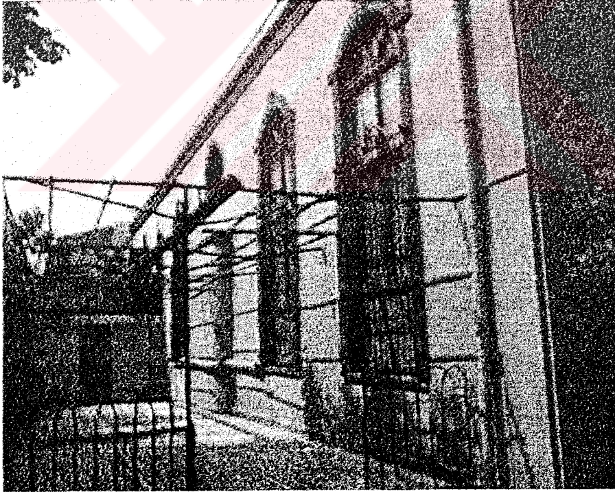
Resim 124 İstanbul Haydarpaşa, doğu cephe
