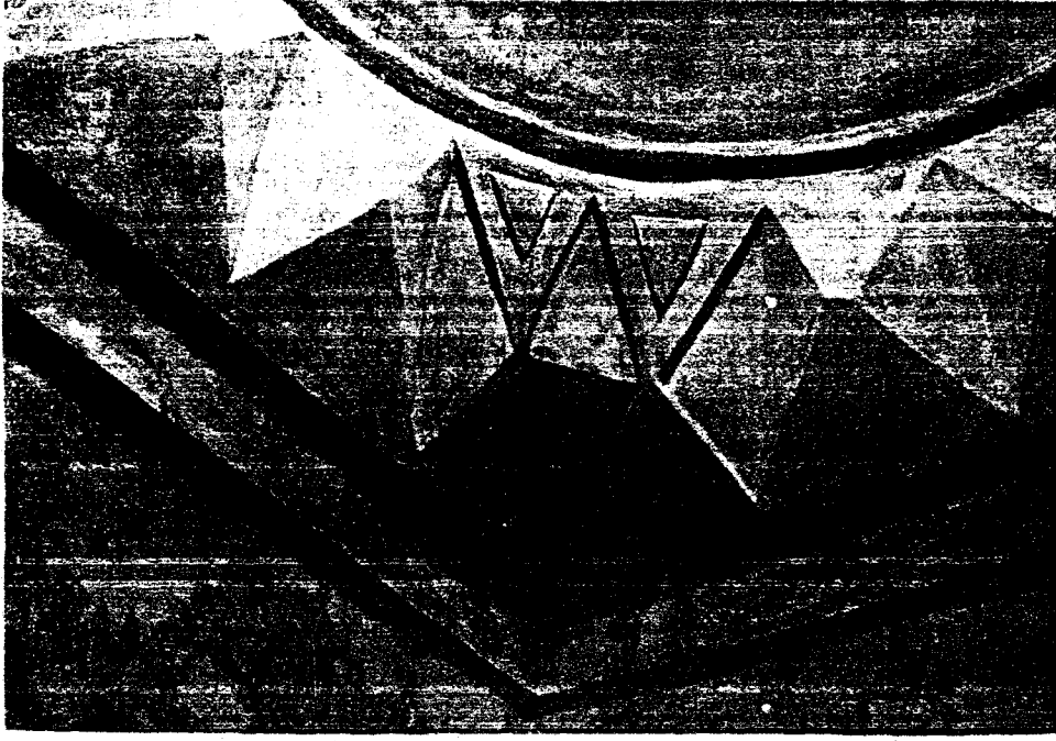
Resim 137- Bursa Yıldırım Bâyezid Hamamı. Ilıklık mekanını örten kubbenin geçişlerinde kullanılan üçgen kuşaklar.
