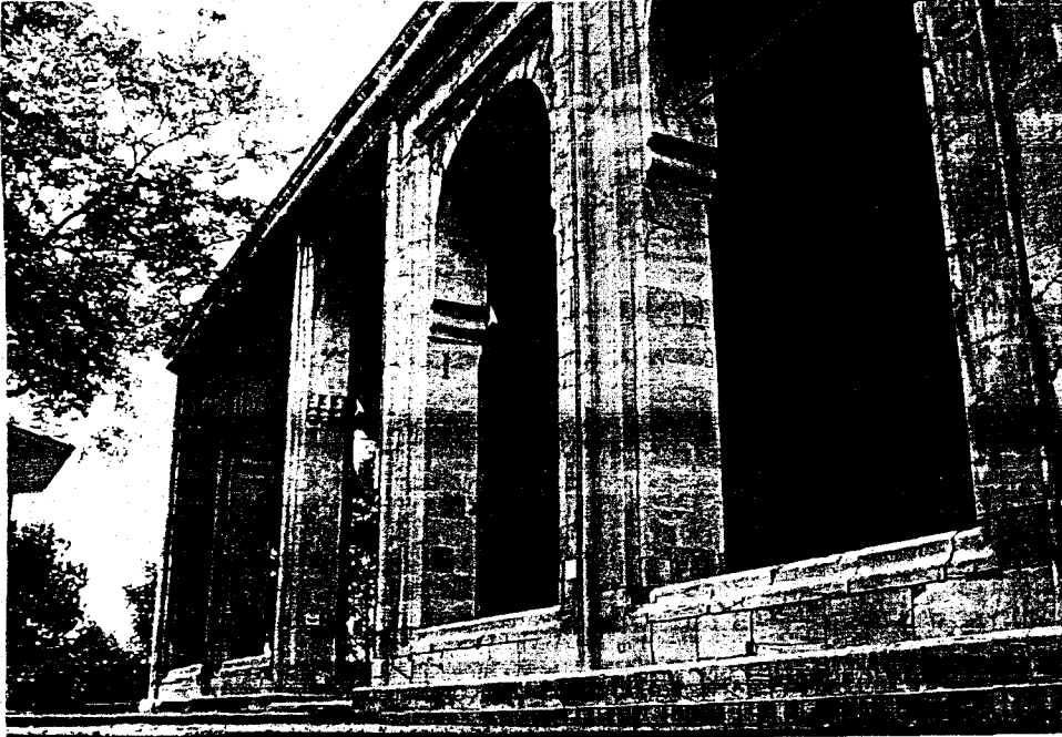
Resim 18- Bursa Yıldırım Bâyezid Camii. Son cemaat yeri revakının kuzeyden görüntüsü.
