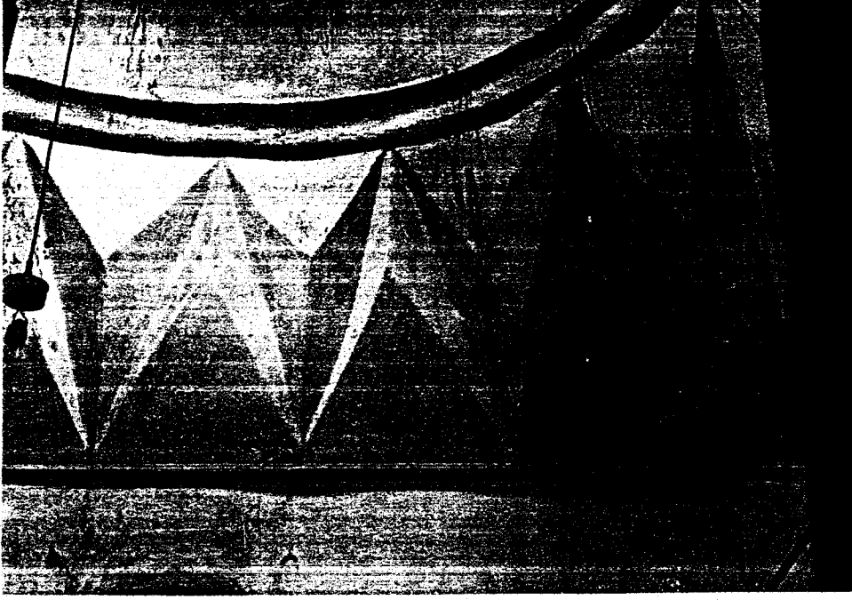
Resim 143- Bursa Yıldırım Bâyezid Hamamı. Kuzey doğudaki sıcaklık mekanını örten kubbenin geçişleri.
