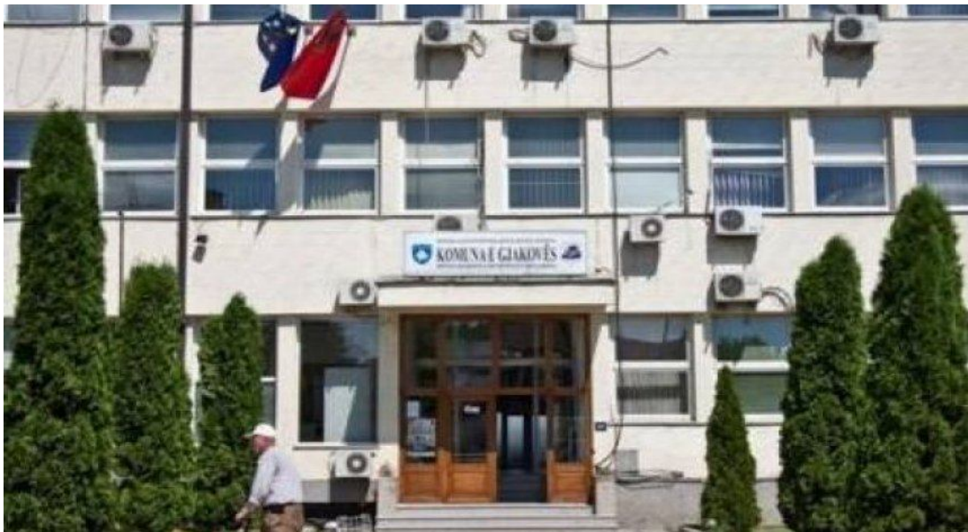
Resim 1.5: Cakova Belediyesinin Binası
