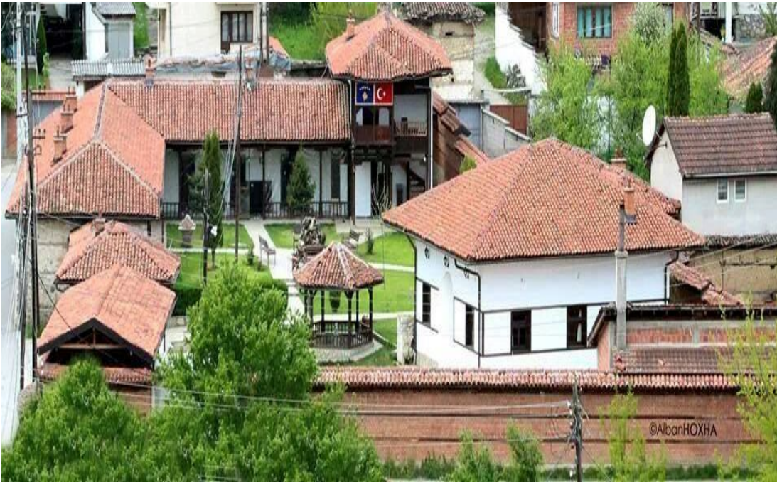
Ek-16: Cakova'da Büyük Medresesinin Mevcut Durumu
