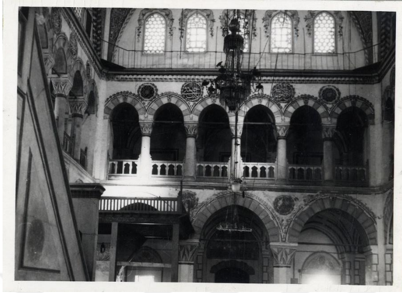
Resim 163: Şerafettin Camii Perde Duvar ve Revak Bölümü Kalem İşi Süsleme Programı(VGMA.)
