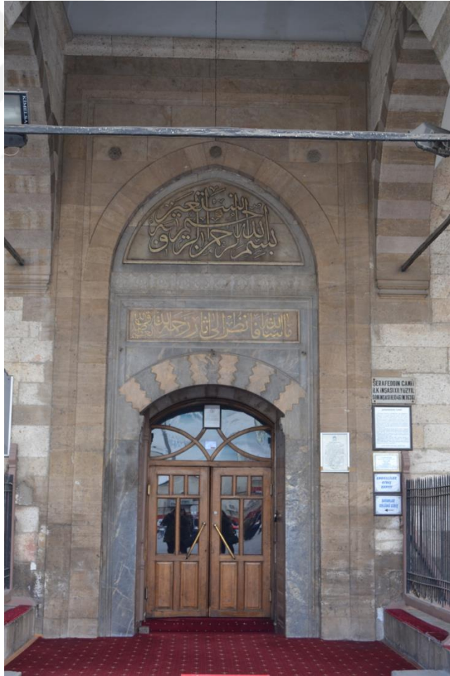
Resim 31: Şerafeddin Camii Kuzey Cephe Giriş Taç Kapı.
