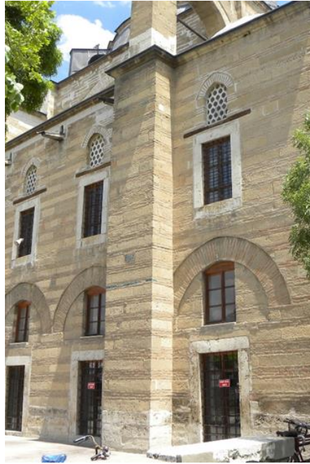
Resim 18a: Batı Cephe Pencere Sistemi.
