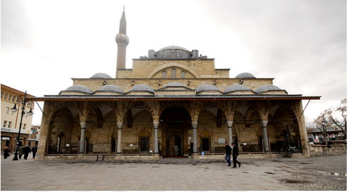
Resim 26: Şerafeddin Cami Kuzey Cephe Son Cemaat Mahalli ve Örtü Sistemi.
