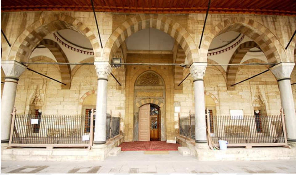
Resim 30: Şerafeddin Camii Kuzey Cephe Giriş Taç Kapı.
