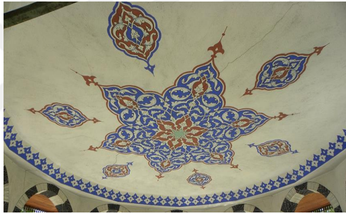
Resim 160a: Şerafeddin Camii Şadırvan Üst Örtü Sistemi Kalem İşi Süsleme Kompozisyonu.
