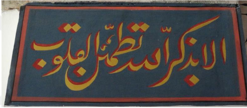
Resim 118: Harim Bölümü Güneydoğu Duvarı Kemer Ayağı Yazı.
