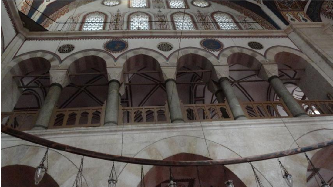
Resim 39: Şerafeddin Camii Mahfil Katı Revak Sistemi.
