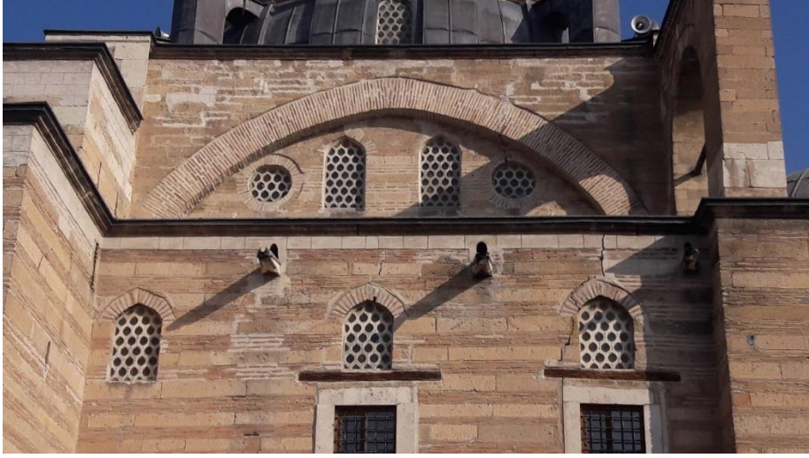
Resim 18b: Batı Cephe Pencere Sistemi.
