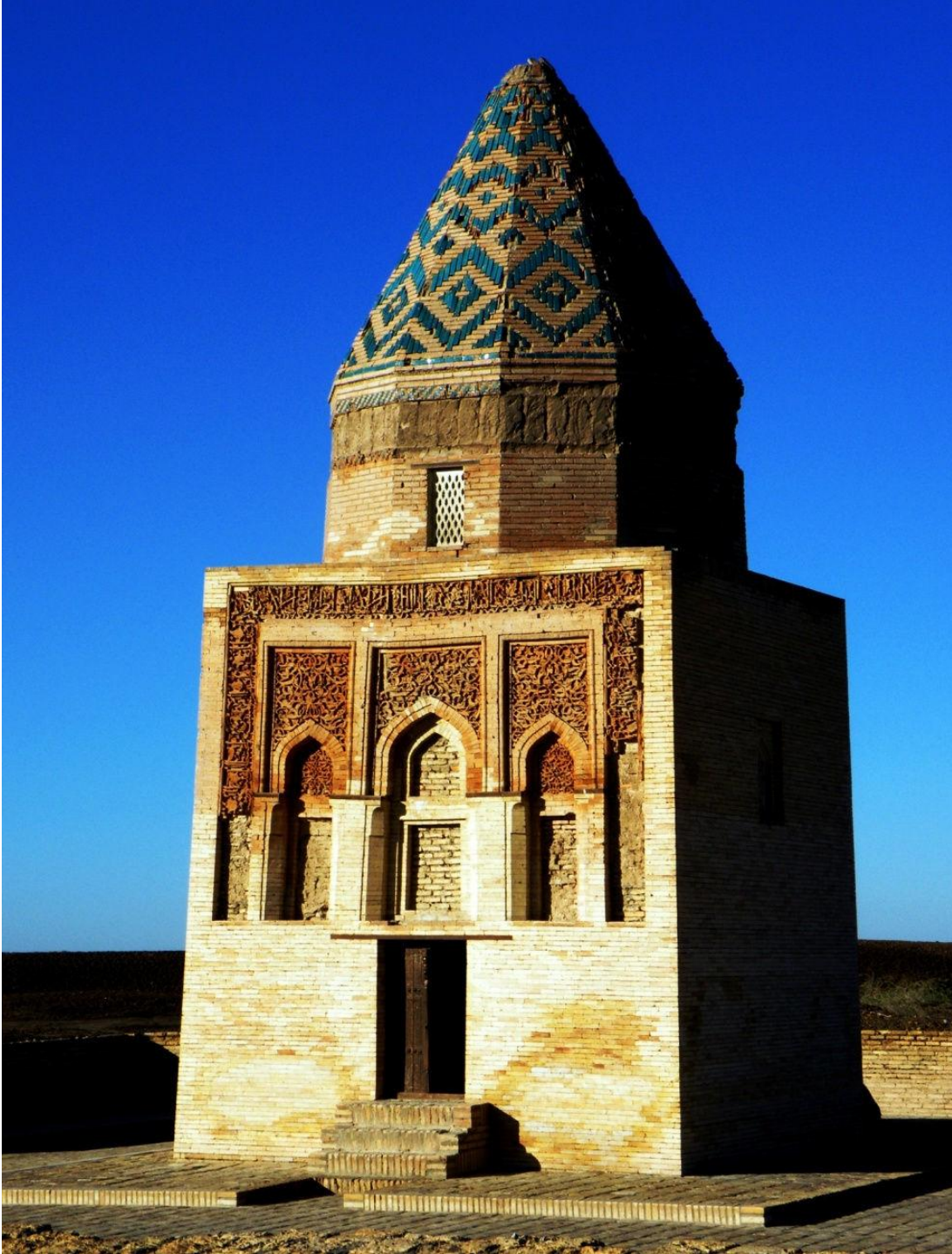
Fahreddîn er-Râzî veya İl Arslan Türbesi
