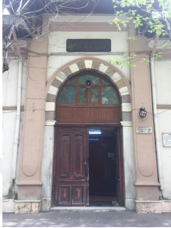
Resim 3.58. Fatih Hüsambey Tezgâhçılar Camii giriş kapı kitâbesi.
