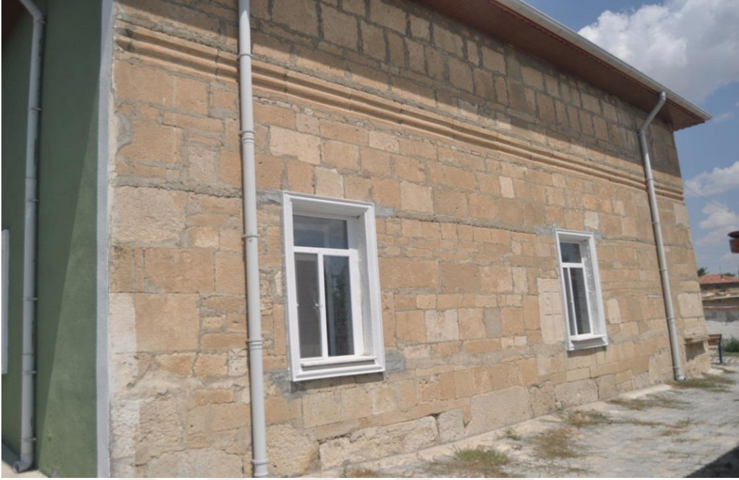
Fotoğraf 18: Soğulca Cami güney cephesi
