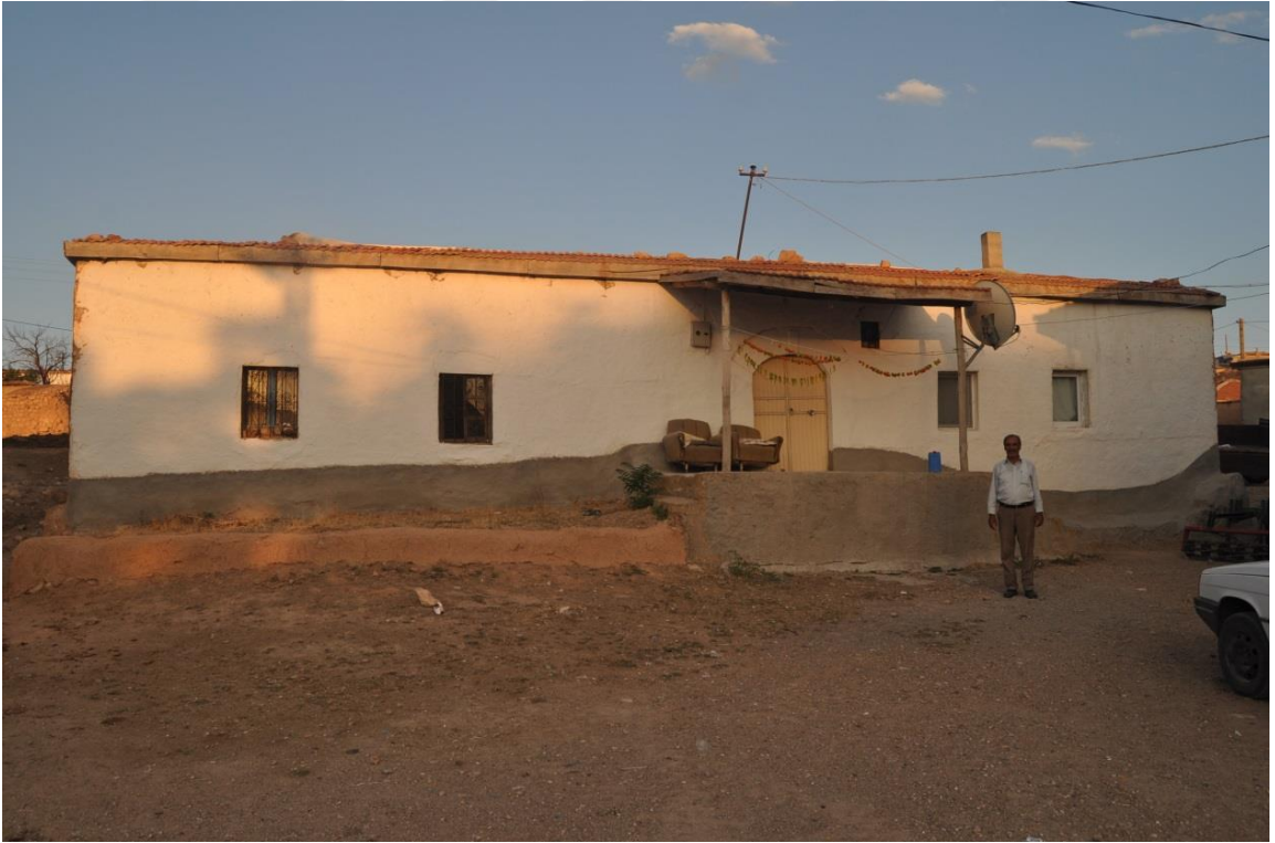
Fotoğraf 85: Alahacılı Mahallesi Ömer Demir Evi güney cephesi
