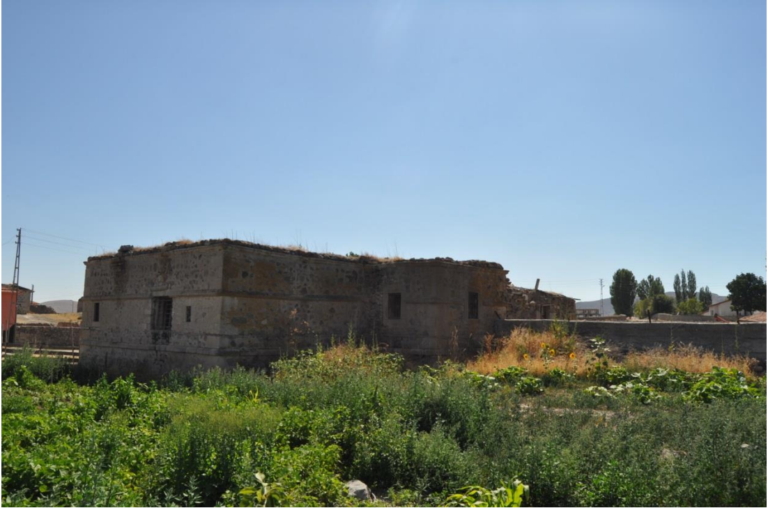
Fotoğraf 111: Mehmet Ağa Evi kuzeydoğu cephesi
