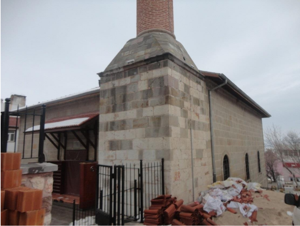
Fotoğraf 40: Haymana Merkez Cami kuzeybatı cephe
