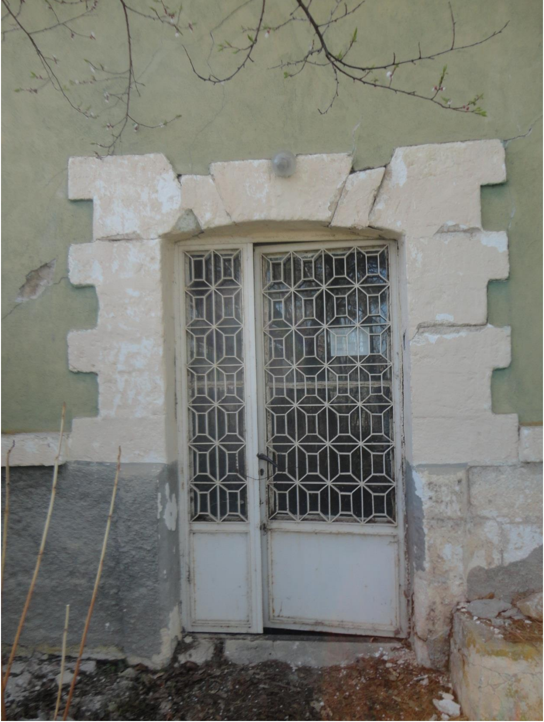
Fotoğraf 53: Ahırlıkuyu Cami giriş kapısı
