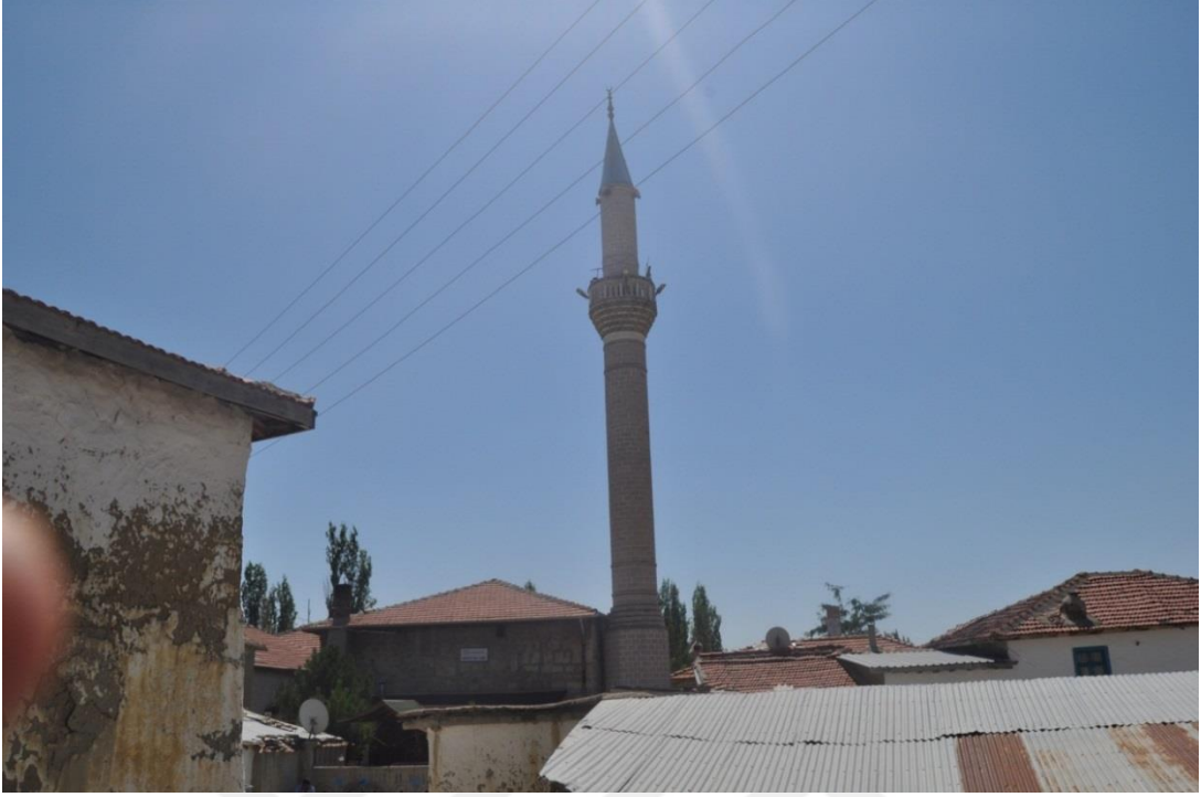
Fotoğraf 32: Kadıköy Cami kuzey cephesi
