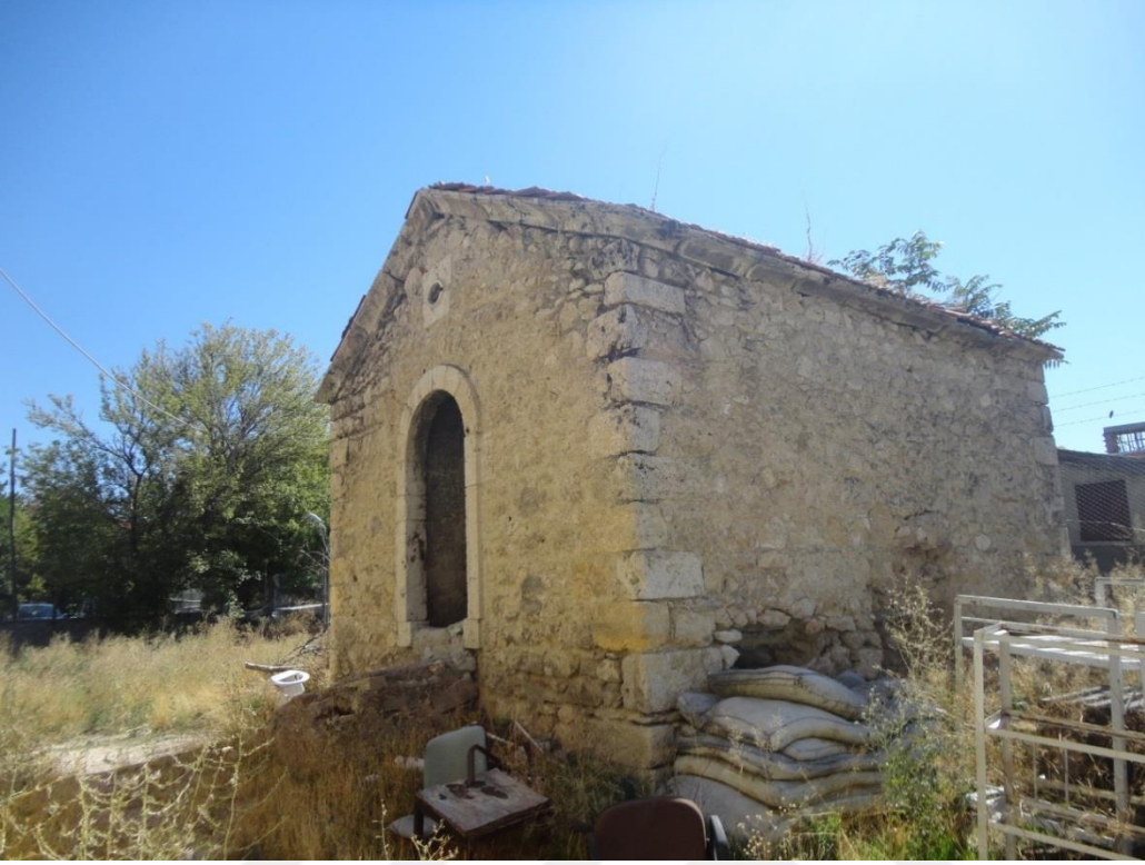
Fotoğraf 156: Haymana Redif Taburu Cephanelik Binası kuzeybatı cephesi
