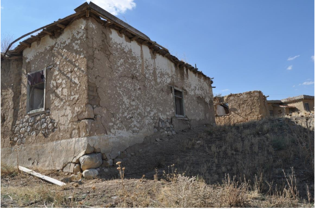
Fotoğraf 74: Küçükkonak Cami güneydoğu cephesi
