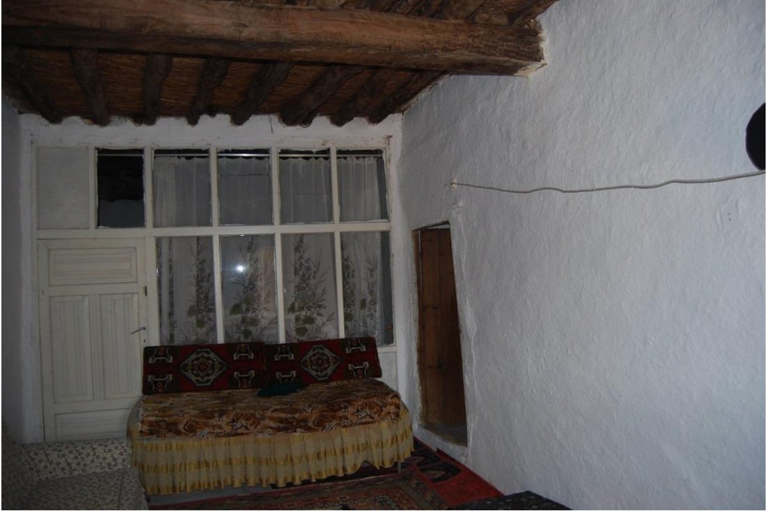
Fotoğraf 87: Alahacılı Mahallesi Ömer Demir Evi sofa kuzey cephesi
