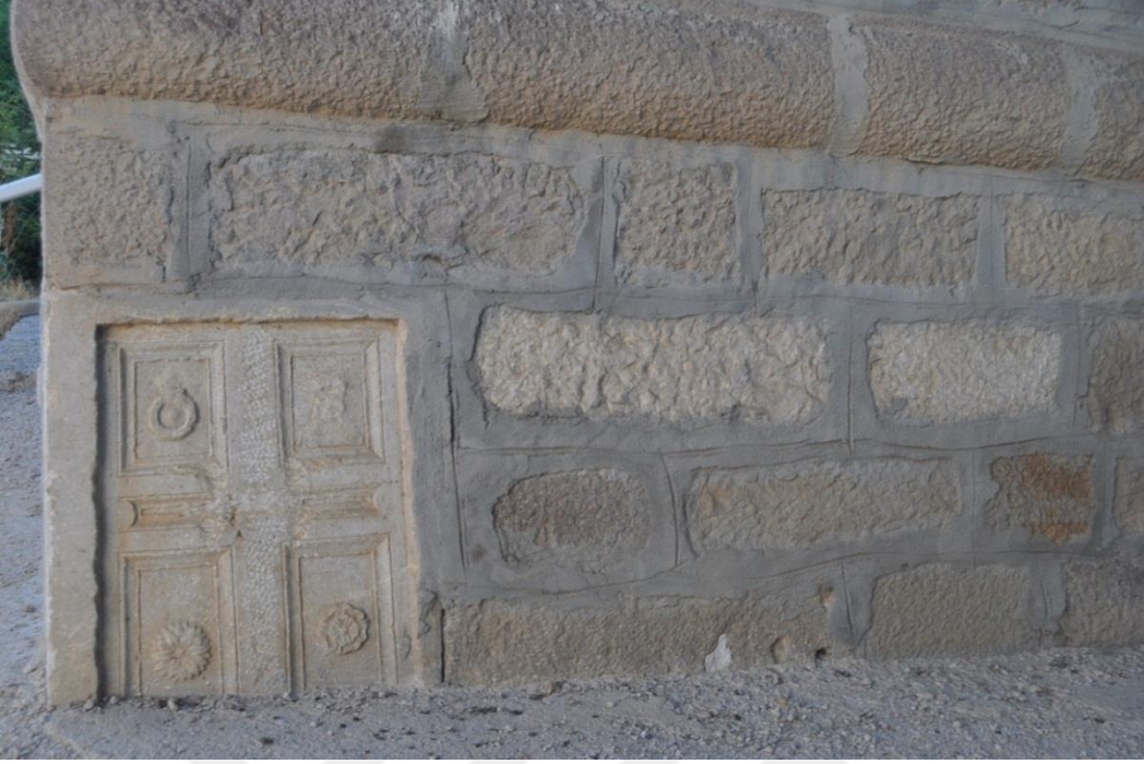
Fotoğraf 12: Culuk Cami Güney Cephesi temel seviyesindeki devşirme taş
