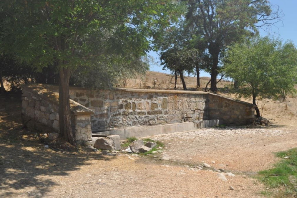
Fotoğraf 183: Ahırlıkuyu Mahallesi Çeşmesi güneybatı cephesi
