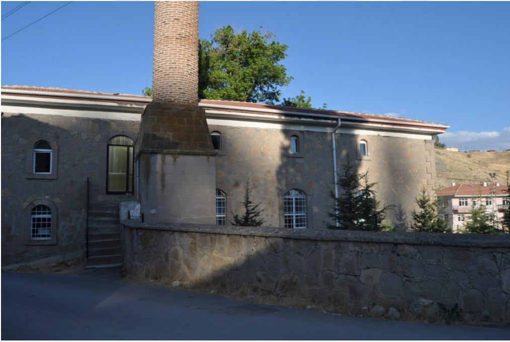
Fotoğraf 11: Culuk Cami batı cephesi
