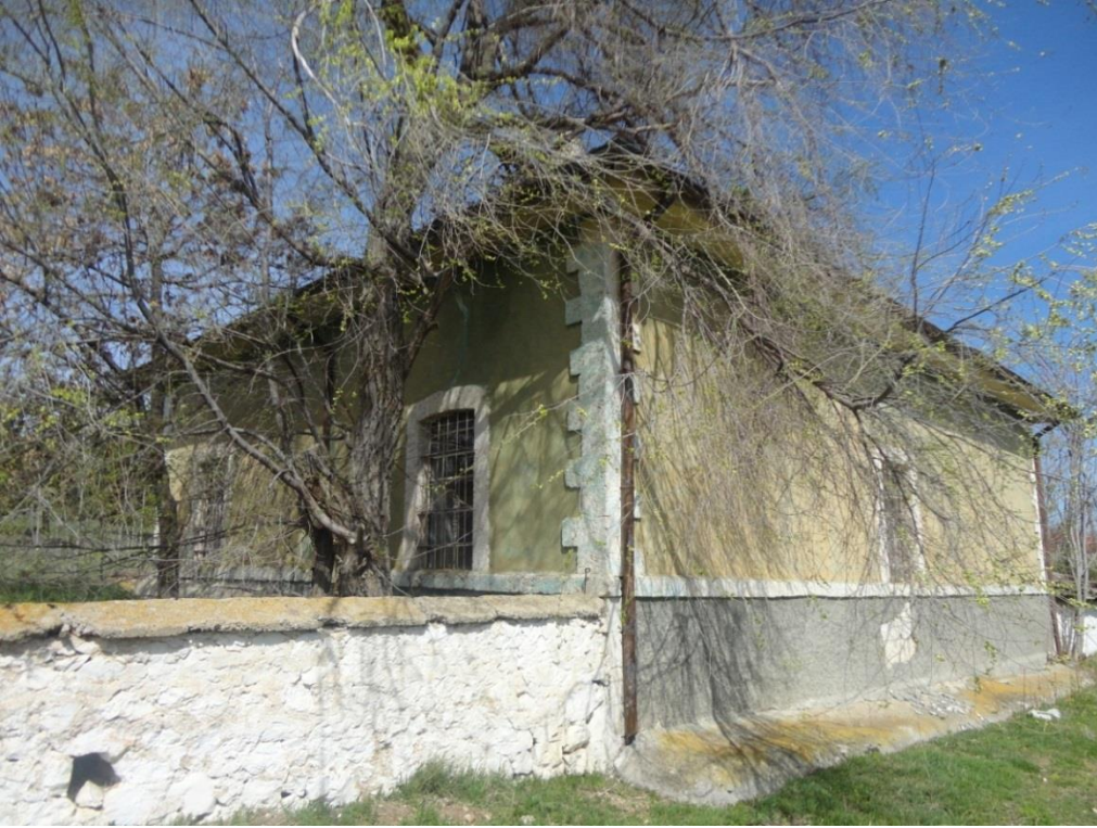
Fotoğraf 51: Ahırlıkuyu Cami güneydoğu cephesi
