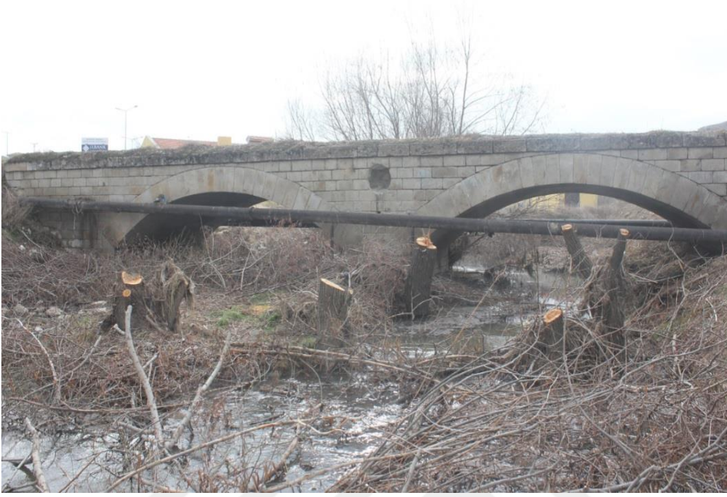
Fotoğraf 166: Çatal Köprü güney cephesi
