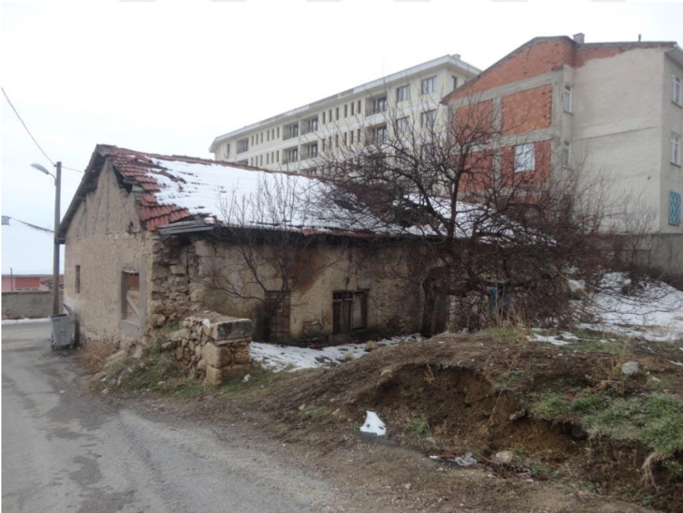
Fotoğraf 105: Papazın Evi kuzeydoğu cephesi
