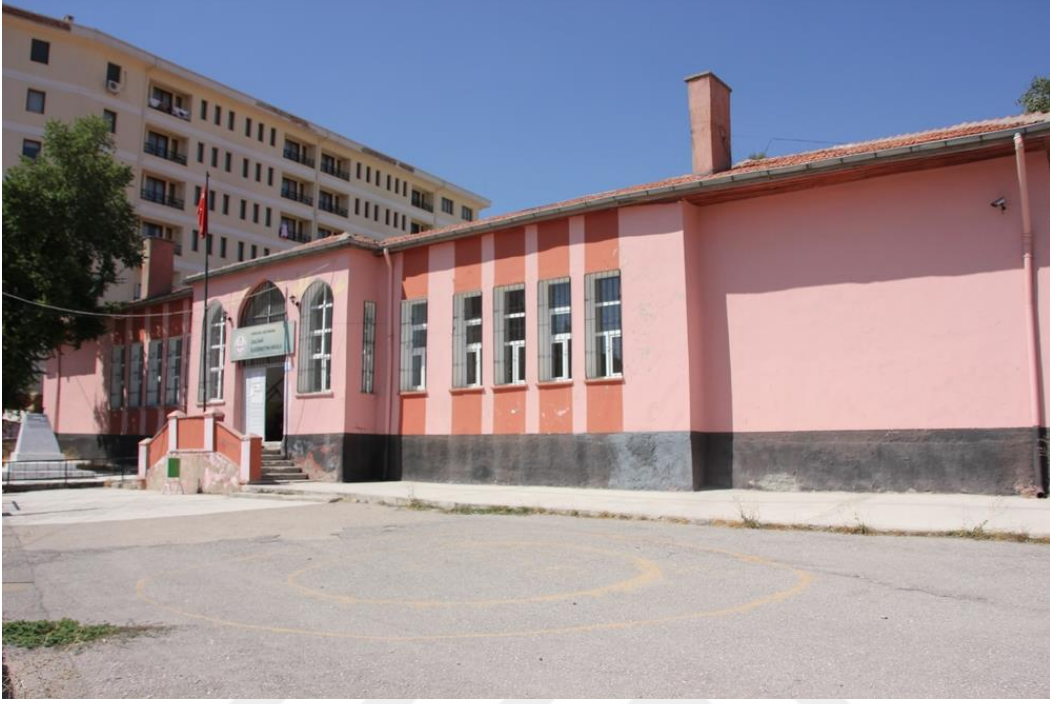
Fotoğraf 160: Çaldağ İlk Öğretim Okulu güneybatı cephesi
