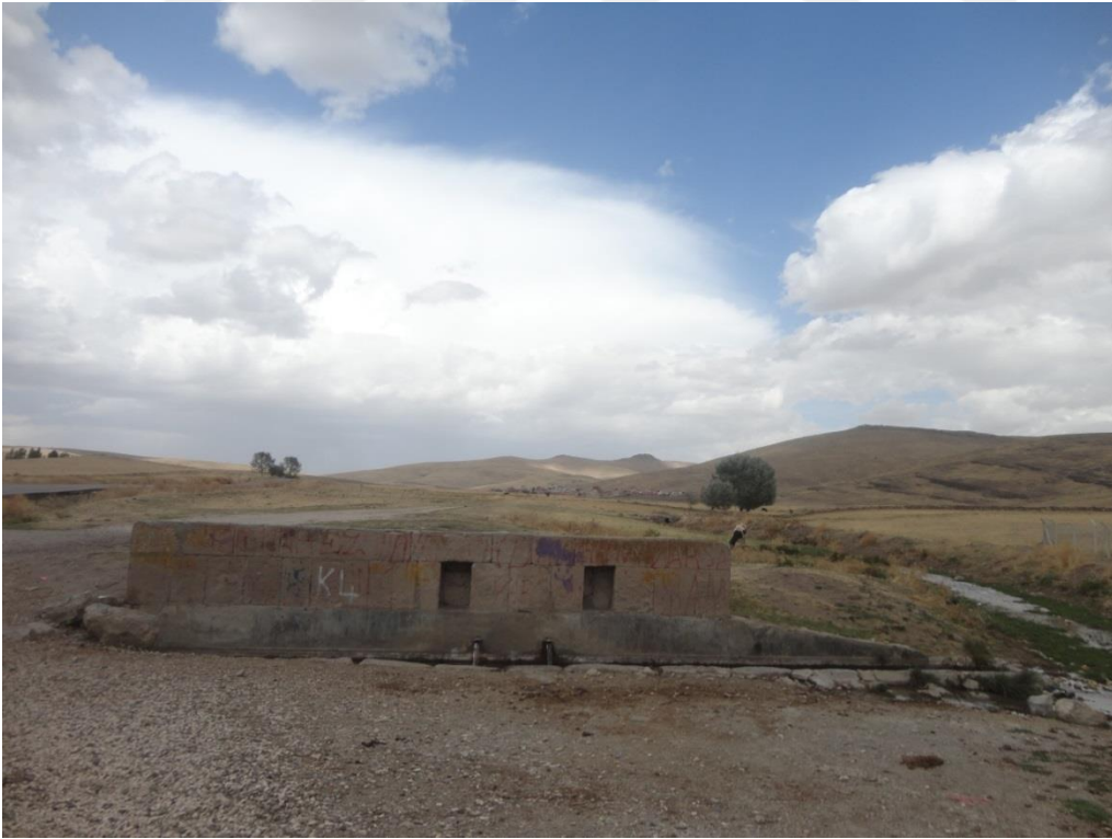
Fotoğraf 172: Tavor Çeşmesi güney cephesi
