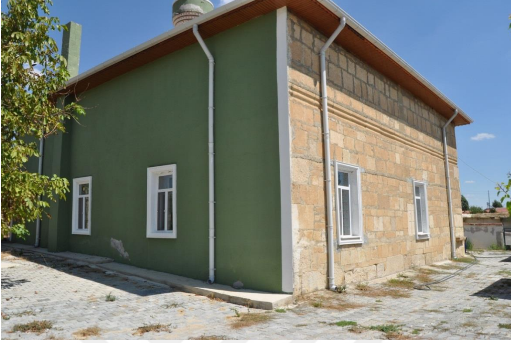
Fotoğraf 16: Soğulca Cami güneydoğu cephesi
