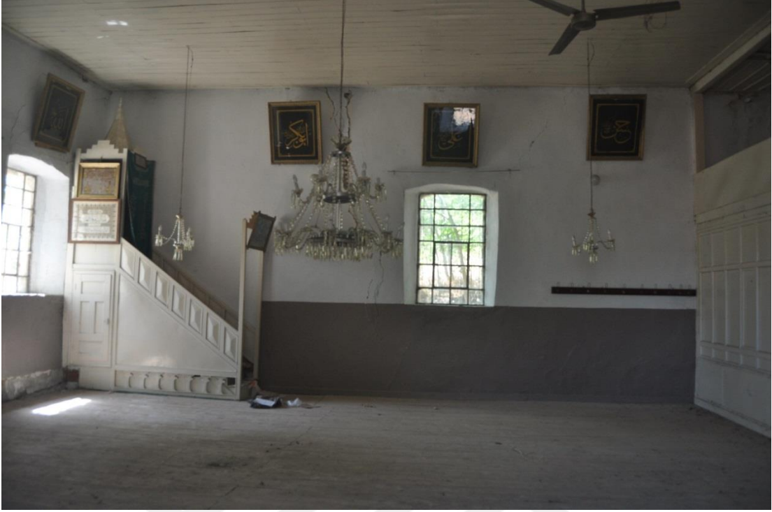
Fotoğraf 57: Ahırlıkuyu Cami harim dođu cephesi
