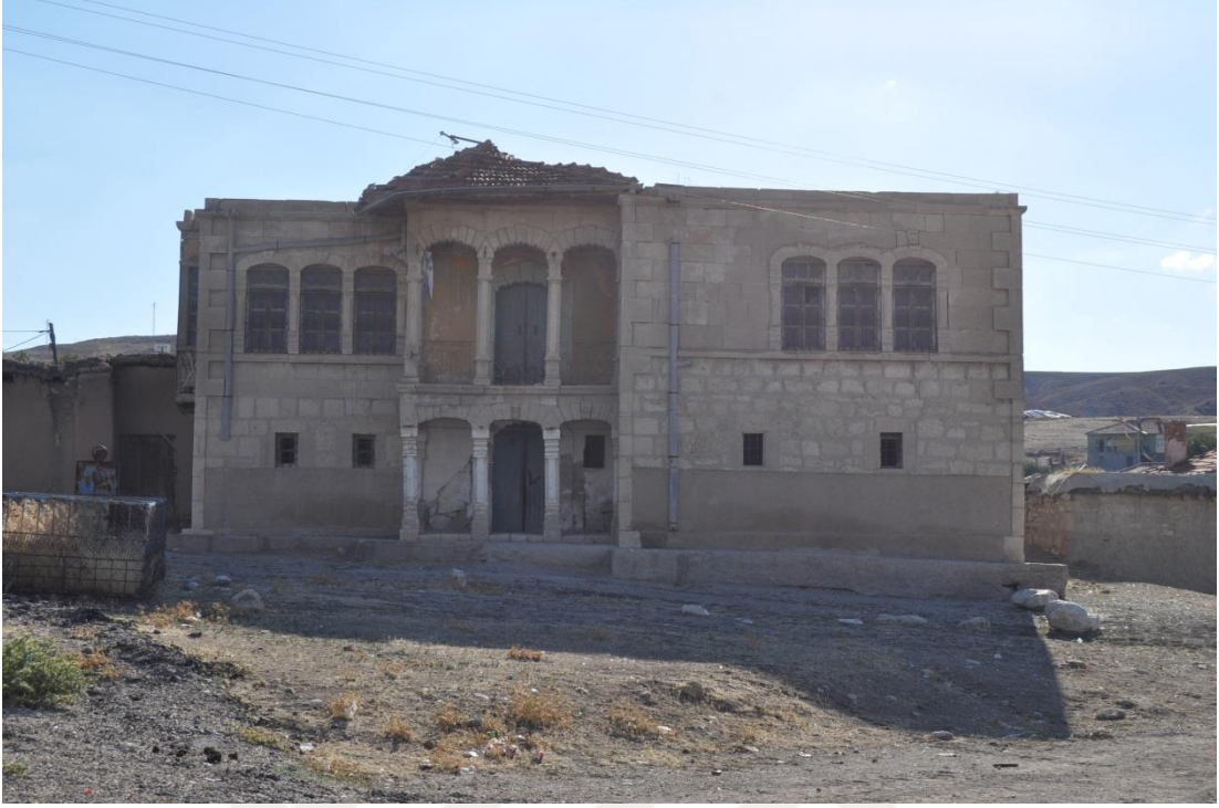
Fotoğraf 118: Emirler Hakbilenler Evi giriş cephesi
