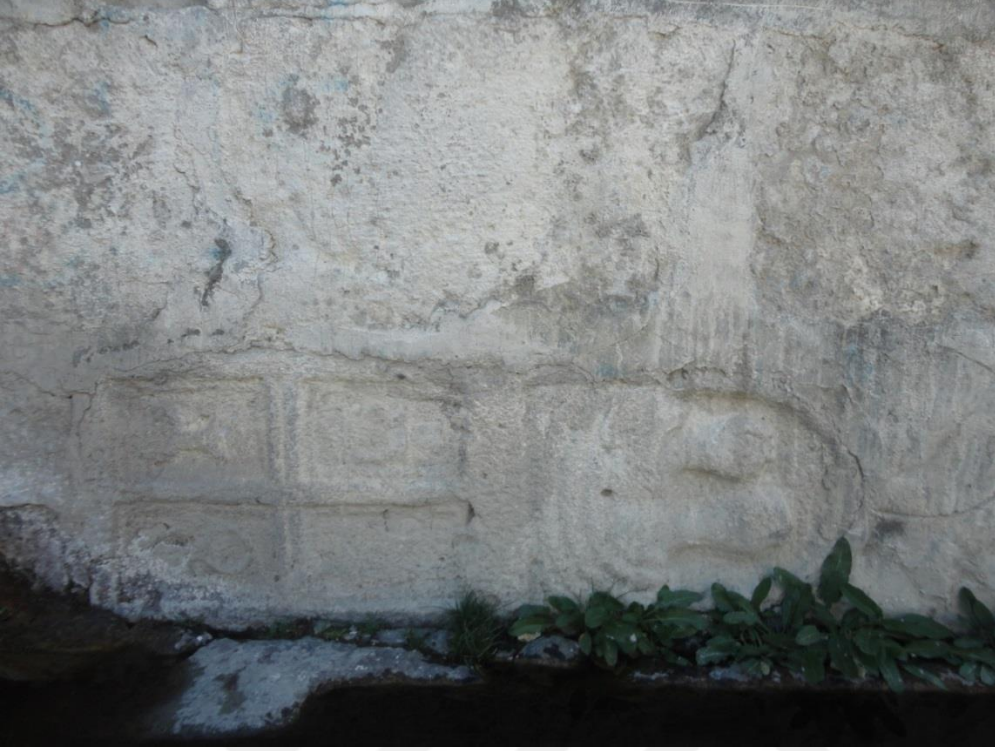
Fotoğraf 182: Durupınar Mahallesi Çeşmesinde kullanılan devşirme taş malzeme
