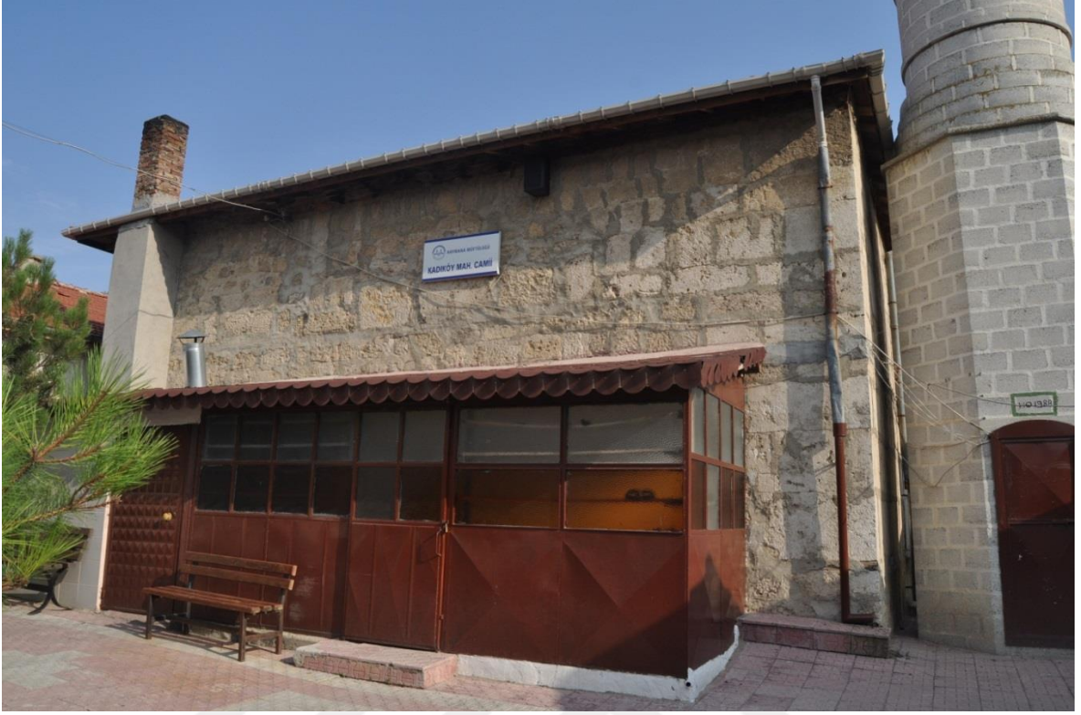
Fotoğraf 30: Kadıköy Cami kuzey cephesi
