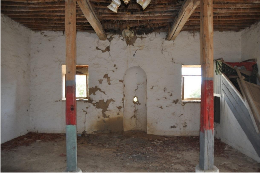
Fotoğraf 75: Küçükkonak Cami harim güney cephesi
