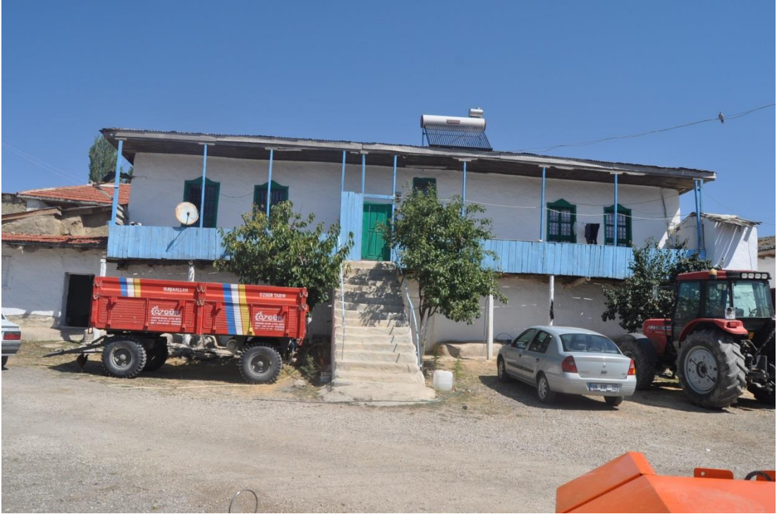
Fotoğraf 99: Karasüleymanlı Mahallesi Şihmet Evi güney cephesi
