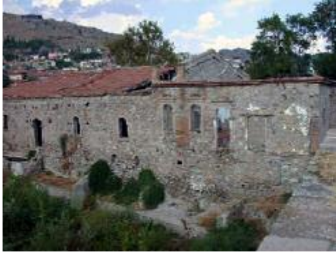
Foto 10: Bergama kent merkezindeki geleneksel mimariyi yansıtan, onarılmayı bekleyen Tabakhane
