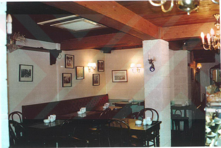
Resim 8.12 Kaset tipte split klimanın tavandaki yerleşimi
