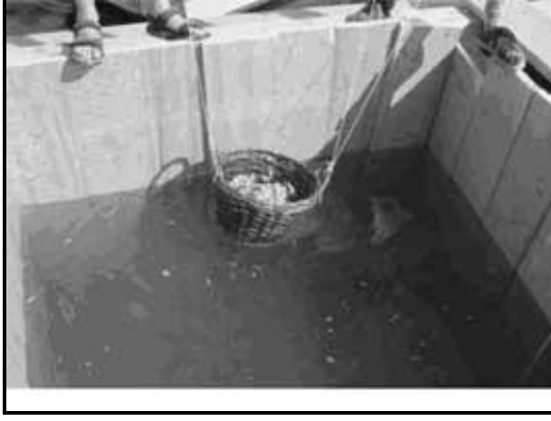
Resim 13. Harcın bir sazdan örülmüş bir sepetle kalıba indirilmesi. Sepet iki halatla tutulurken bir de boşaltmak için bir üçüncü halat da bağlanmıştır (Hohlfelder vd. 2006, 125 – Fig. 2).
