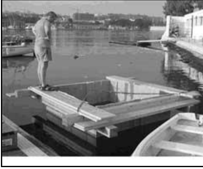
Resim 12. C. Brandon harç konulma işlemi öncesi yapımı tamamlanan kalıbı inceliyor (Hohlfelder vd. 2006, 125 – Fig.1).
