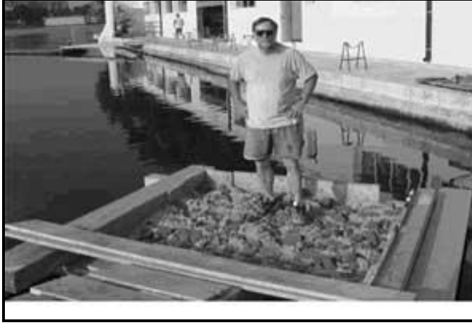
Resim 14. Son harç ve agrega kalıba yerleştirildikten sonra R. L. Hohfelder kalıbın üzerinde (Hohfelder vd. 2006, 126 – Fig. 3).
