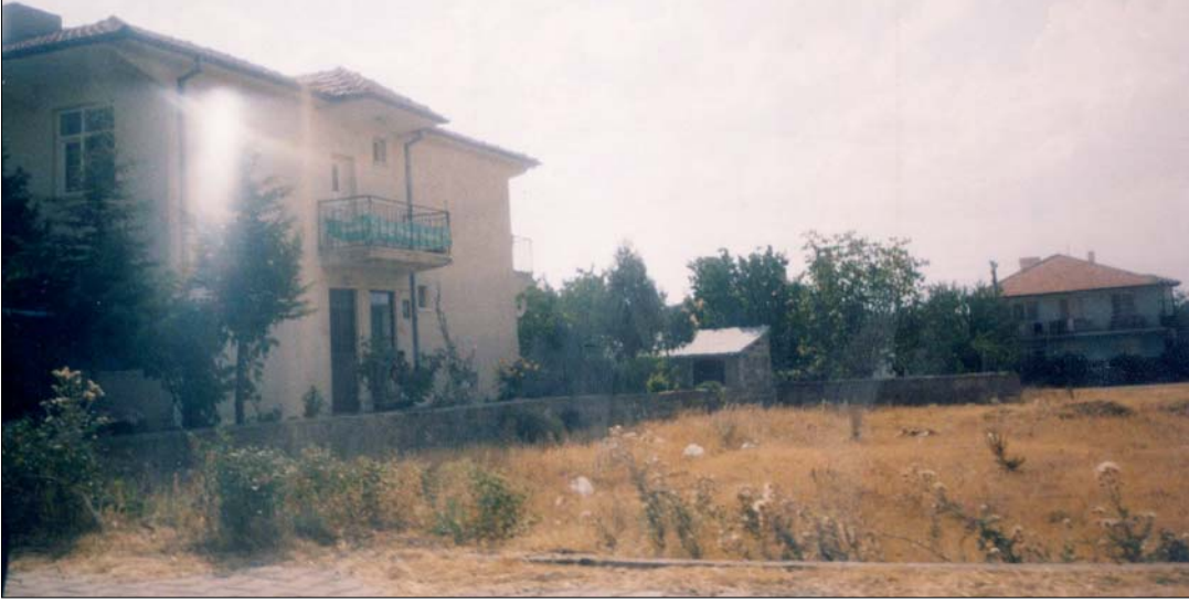
Fotoğraf 13: Hacıbektaş'ın girişinde bulunan bu iki katlı ev, diğer yapılara da bir örnektir. Hacıbektaş'ta yüksek katlı ev bulunmamaktadır (Gökçen ÇATLI, 24 Ağustos 2007, Cuma. Hacıbektaş/Nevşehir).
