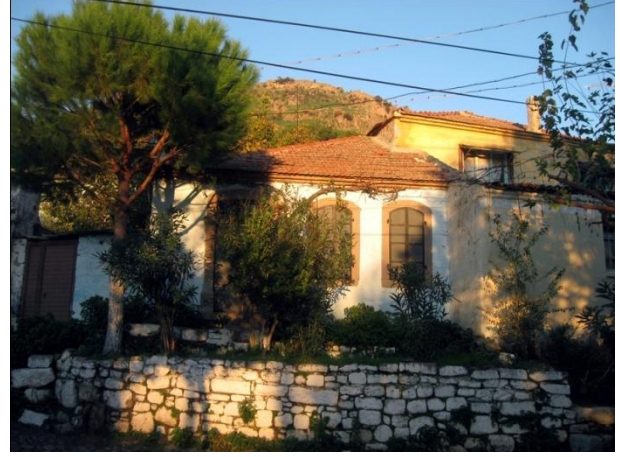
Resim 267: Ulucami Mah. İttihat-ı Terakki Cad. No. 84- Güneybatı cephe
