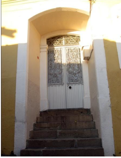
Resim 304: Ulucami Mah. Vakıfbahçe Sok. No. 2- Ana giriş kapısı
