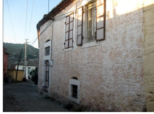
Resim 307: Ulucami Mah. Vakıfbahçe Sok. No. 8- Güneybatı cephe
