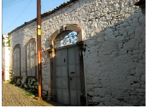
Resim 50: Talatpaşa Mah. Alp ÇıkmaZI Sok. No. 4- Kuzeybatı cephe
