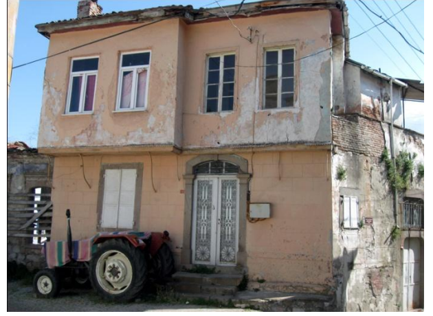
Resim 123: Talatpaşa Mah. Dede Sok. No. 35- Kuzeydoğu cephe
