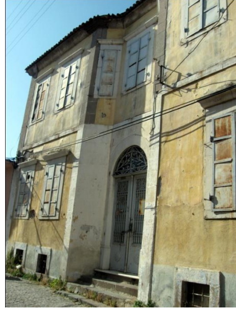
Resim 130: Talatpaşa Mah. Dede Sok. No. 41- Güneydoğu cephe
