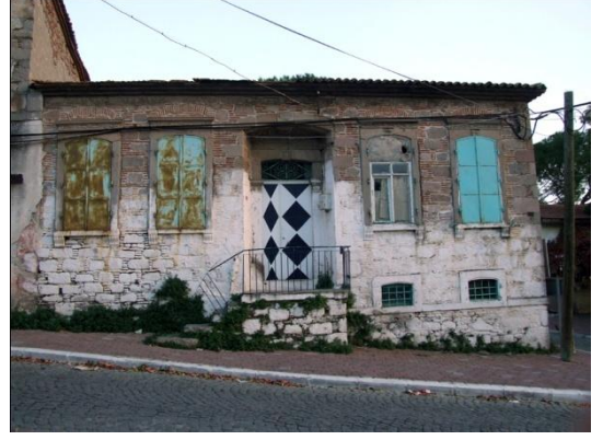
Resim 337: Kurtuluş Mah. Parmakbatıran Cad. No. 2- Kuzeybatı cephe
