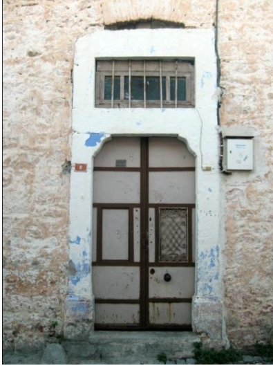
Resim 306: Ulucami Mah. Vakıfbahçe Sok. No. 8- Ana giriş kapısı
