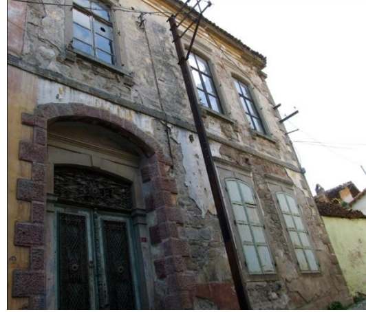
Resim 100: Talatpaşa Mah. Dede Sok. No. 21- Kuzeydoğu cephe
