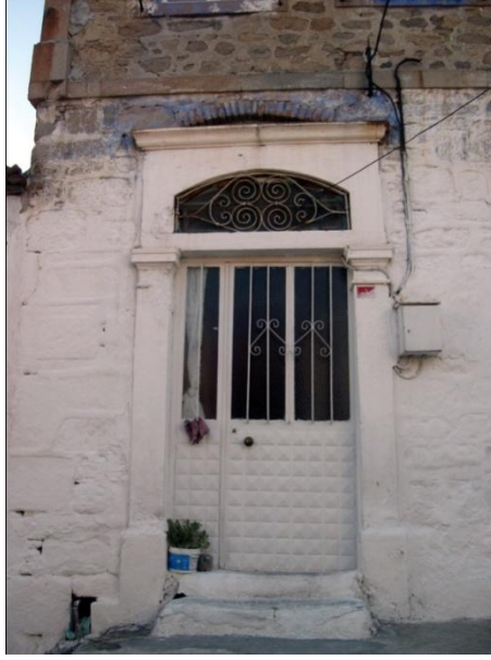
Resim 397: Kurtuluş Mah. Taksim ÇıkmaZI Sok. No. 3- Ana giriş kapısı
