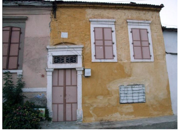
Resim 370: Kurtuluş Mah. Parmakbatıran Cad. No. 59- Güneydoğu cephe
