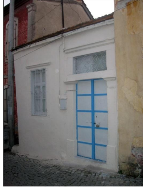
Resim 183: Talatpaşa Mah. Kılıç Ali Sok. No. 17- Kuzeydoğu cephe
