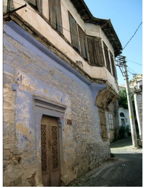
Resim 165: Talatpaşa Mah. Kadı Sok. No. 15- Güneydoğu cephe
