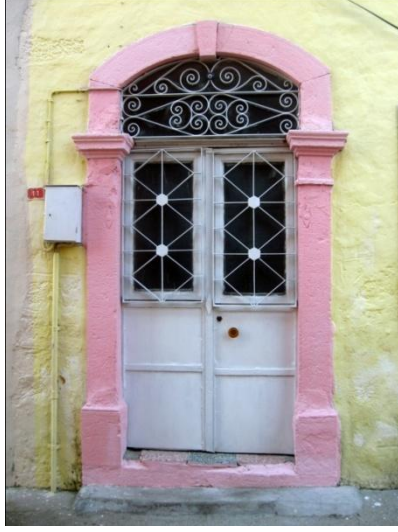
Resim 317: Kurtuluş Mah. Kalaycı Sok. No. 11- Ana giriş kapısı
