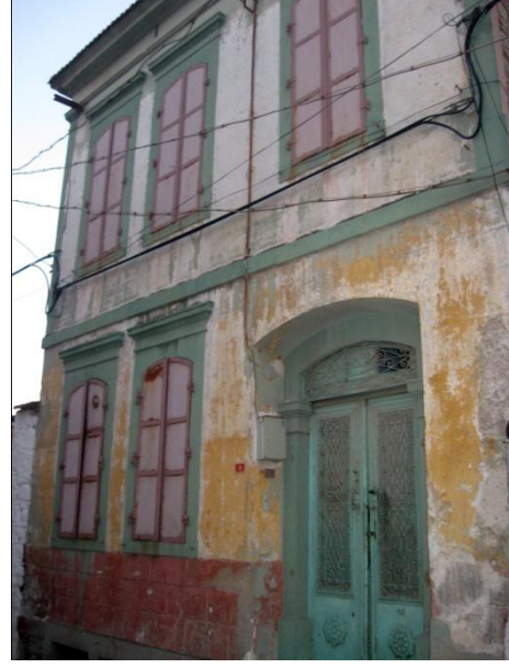
Resim 70: Talatpaşa Mah. Arifbey Sok. No. 3- Kuzey cephe
