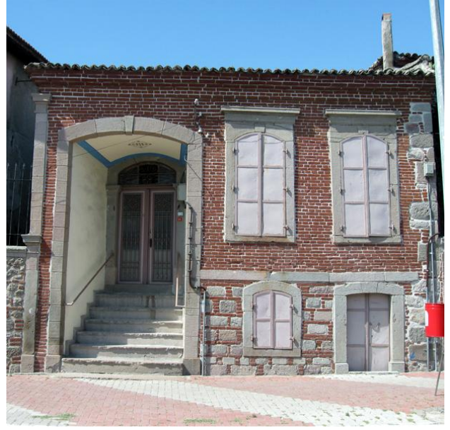
Resim 189: Talatpaşa Mah. Kınık Sok. No. 55- Güney cephe
