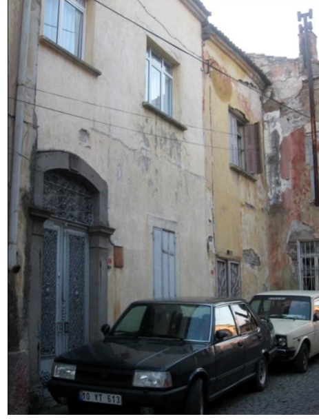
Resim 151: Talatpaşa Mah. Kadı Sok. No. 7- Kuzeydoğu cephe
