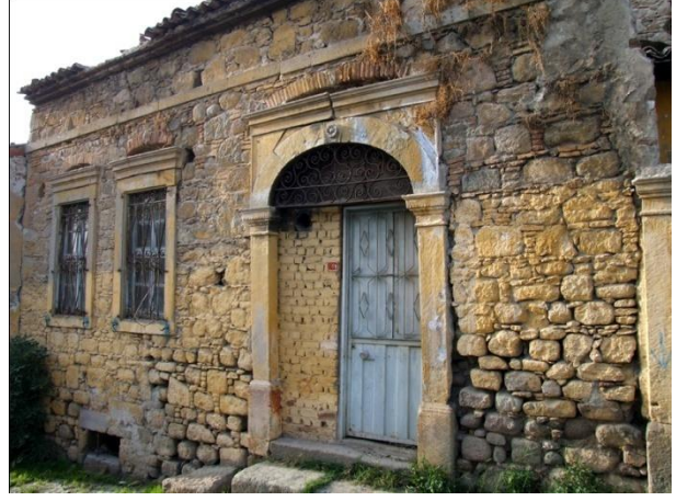
Resim 46: Talatpaşa Mah. Alp Çıkmaşı Sok. No. 1- Güneydoğu cephe
