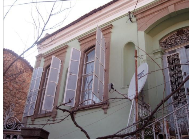
Resim 136: Talatpaşa Mah. Kadı Aralığı Sok. No. 3- Kuzey cephe
