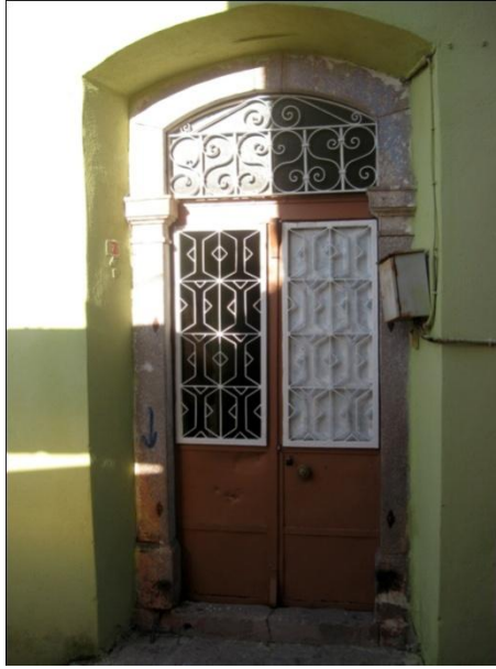
Resim 313: Kurtuluş Mah. Kalaycı Sok. No. 7- Ana giriş kapısı
