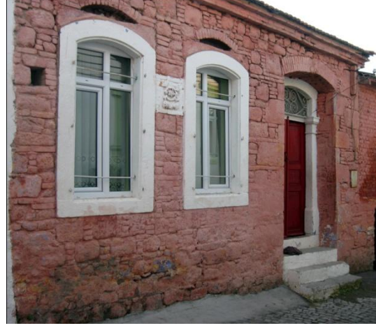
Resim 309: Ulucami Mah. Vakıfbahçe Sok. No. 9- Kuzeydoğu cephe
