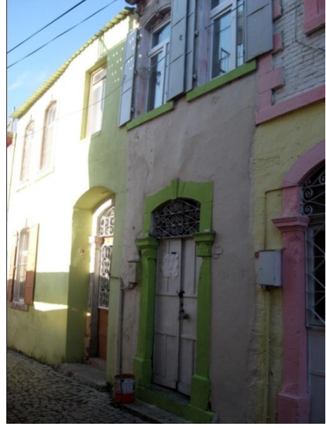
Resim 316: Kurtuluş Mah. Kalaycı Sok. No. 9- Güney cephe
