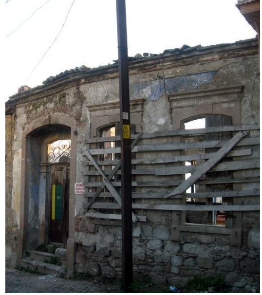
Resim 112: Talatpaşa Mah. Dede Sok. No. 33- Kuzeydoğu cephe
