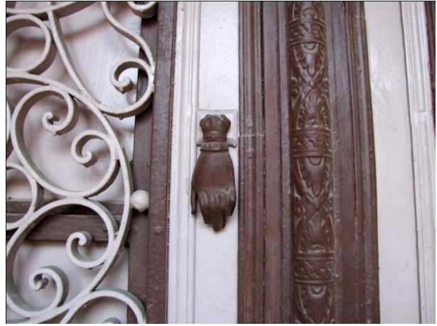
Resim 350: Kapı kanatlarından detay, el biçimli kapı tokmağı
