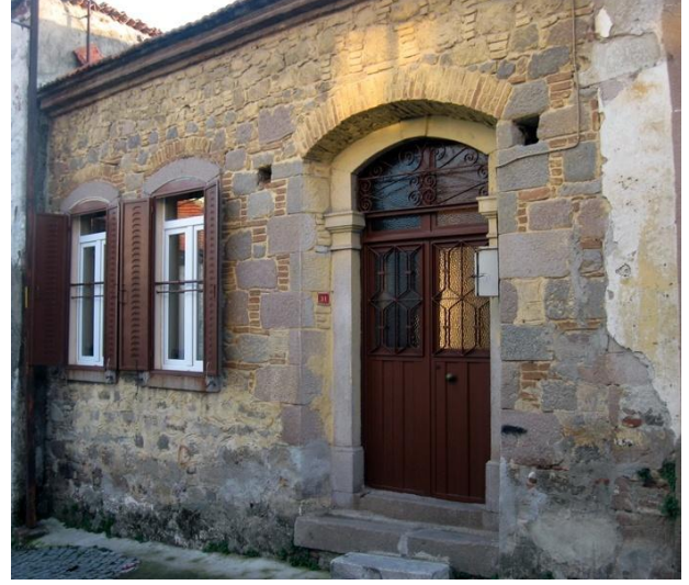
Resim 104: Talatpaşa Mah. Dede Sok. No. 31- Kuzeydoğu cephe
