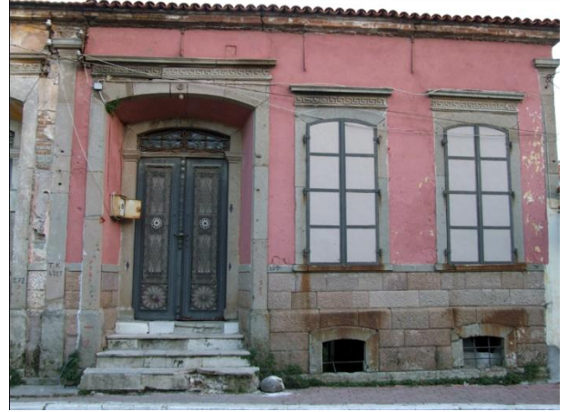
Resim 352: Kurtuluş Mah. Parmakbatıran Cad. No. 30- Kuzeybatı cephe
