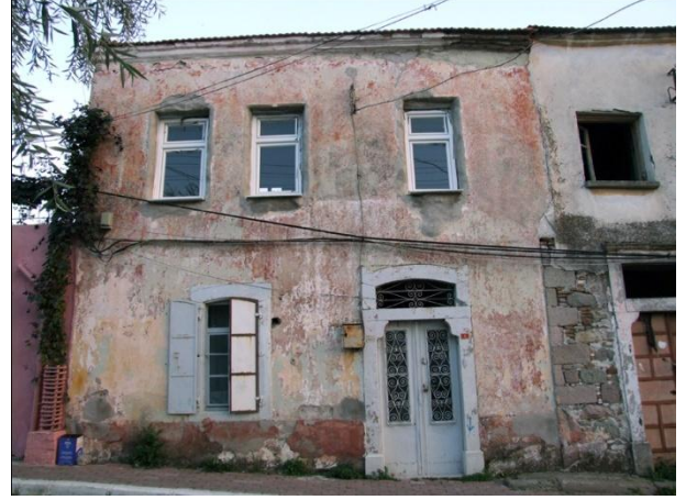
Resim 344: Kurtuluş Mah. Parmakbatıran Cad. No. 6- Kuzeybatı cephe
