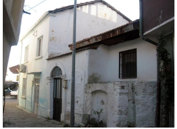
Resim 226: Talatpaşa Mah. Tabak ÇıkmaZI Sok. No. 3- Kuzeydoğu cephe
