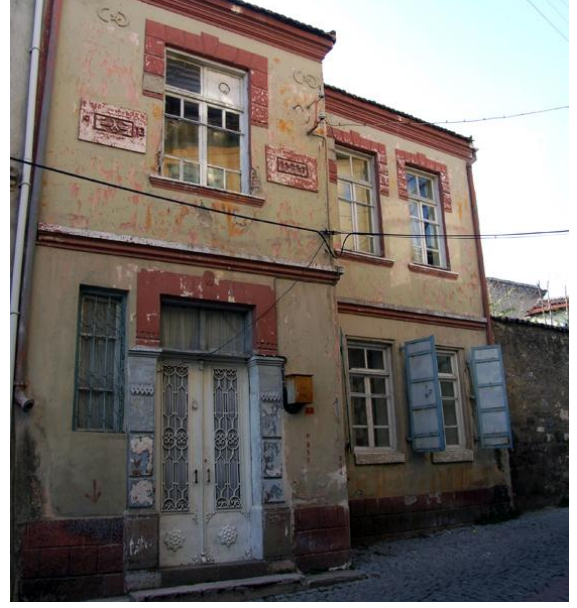
Resim 83: Talatpaşa Mah. Dede Sok. No. 7- Kuzeydoğu cephe
