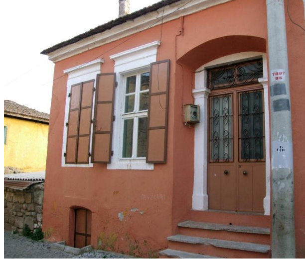
Resim 402: Kurtuluş Mah. Turgut Sok. No. 11- Kuzeydoğu cephe
