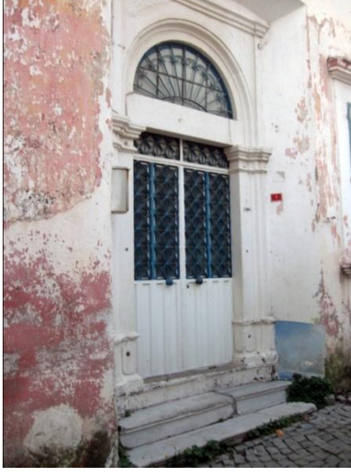
Resim 252: Talatpaşa Mah. Zafer Sok. No. 1- Ana giriş kapısı
