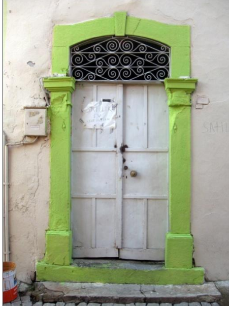
Resim 315: Kurtuluş Mah. Kalaycı Sok. No. 9- Ana giriş kapısı
