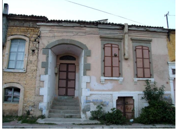
Resim 368: Kurtuluş Mah. Parmakbatıran Cad. No. 57- Güneydoğu cephe
