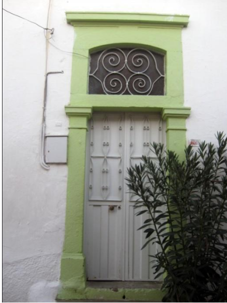
Resim 311: Ulucami Mah. Vakıfbahçe Sok. No. 10- Ana giriş kapısı
