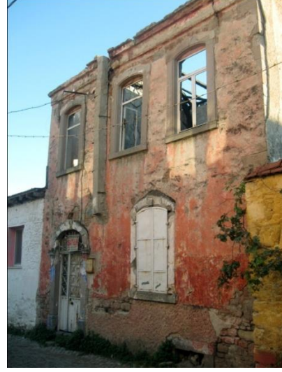
Resim 77: Talatpaşa Mah. Arifbey Sok. No. 17- Kuzeydoğu cephe
