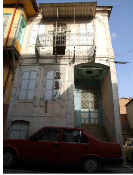
Resim 79: Talatpaşa Mah. Dede Sok. No. 4- Güneybatı cephe
