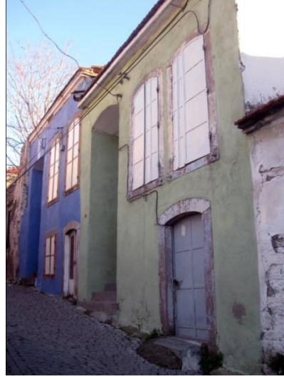
Resim 281: Ulucami Mah. Soğandere Sok. No. 5- Kuzey cephe
