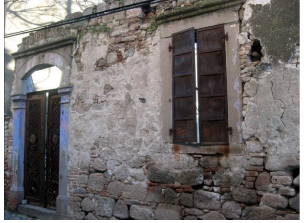
Resim 277: Ulucami Mah. Soğandere Sok. No. 1- Kuzey cephe
