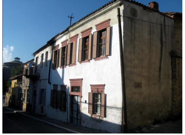
Resim 331: Kurtuluş Mah. Kınık Cad. No. 91- Güney cephe
