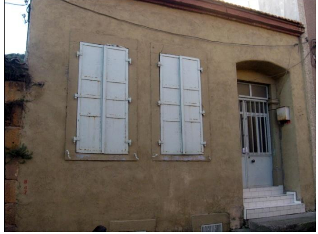
Resim 10: Talatpaşa Mah. Abacıhan Sok. No. 5- Güneydoğu cephe
