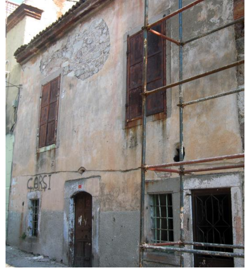
Resim 8: Talatpaşa Mah. Samanpazarı Sok. No. 2'de yer alan kuzeybatı cephe
