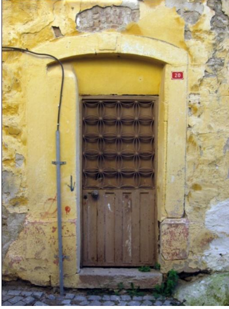
Resim 322: Kurtuluş Mah. Kalaycı Sok. No. 20- Ana giriş kapısı
