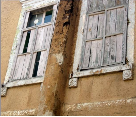
Resim 19: Talatpaşa Mah. Abacıhan Sok. No. 11- İki pencere arasındaki baca ile sövelerin altında yer alan rozetlerden detay
