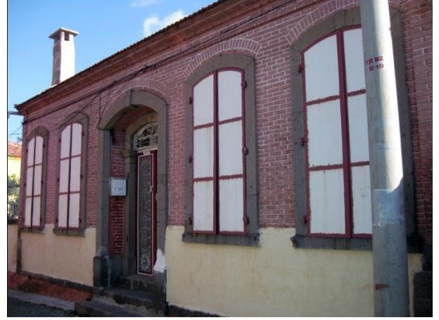
Resim 293: Ulucami Mah. Soğandere Sok. No. 33-35- Kuzey cephe
