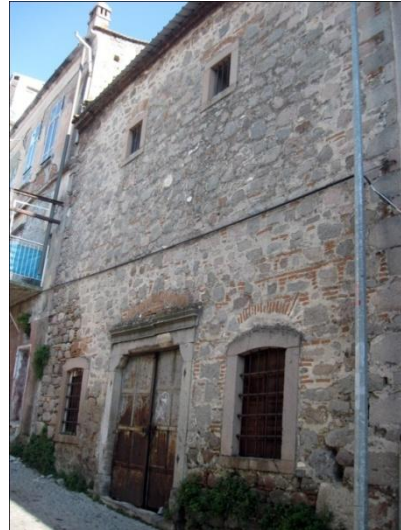
Resim 16: Talatpařa Mah. Samanpazarı Sok. No. 8’de yer alan kuzeybatı cephe
