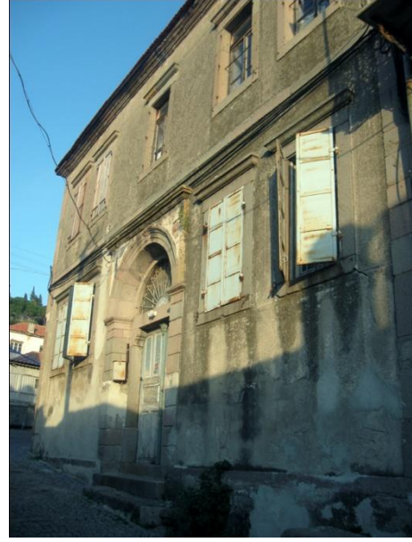
Resim 117: Talatpaşa Mah. Dede Sok. No. 34- Kuzeybatı cephe
