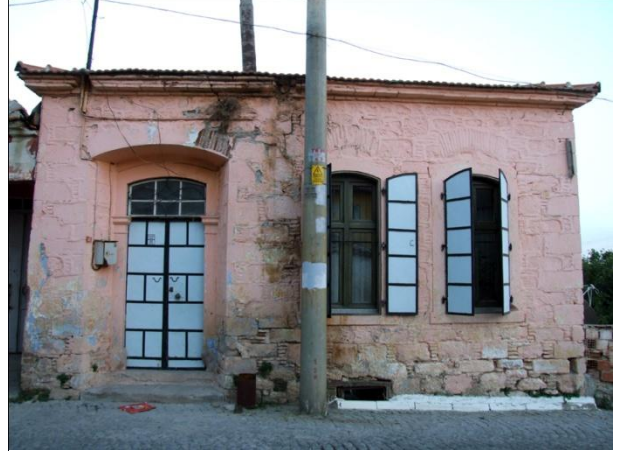
Resim 362: Kurtuluş Mah. Parmakbatıran Cad. No. 34- Kuzeybatı cephe
