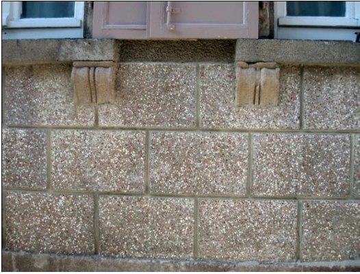
Resim 25: Talatpaşa Mah. Abacıhan Sok. No. 13- Rüstik sıva detayı
