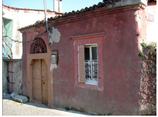
Resim 234: Talatpaşa Mah. Tabak Köprü Cad. No. 2- Kuzeybatı cephe
