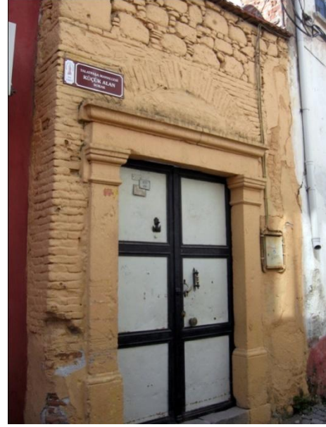
Resim 191: Talatpaşa Mah. Küçük Alan Sok. No. 1- Güneydoğu cephe
