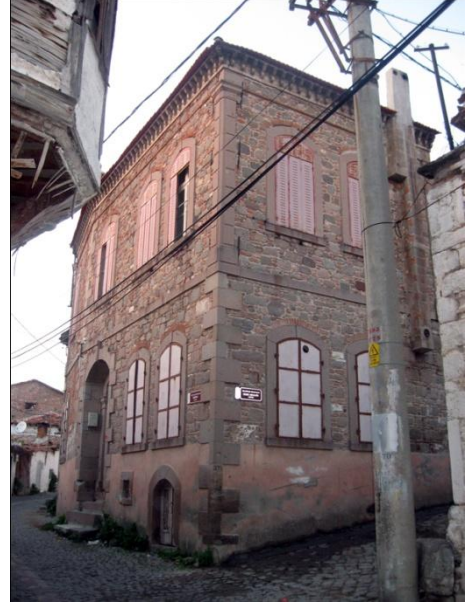
Resim 66: Talatpaşa Mah. Arifbey Sok. No. 2- Güneybatı ve güneydoğu cepheler
