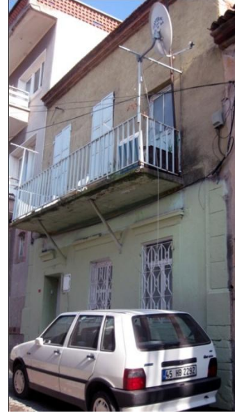
Resim 12: Talatpaşa Mah. Samanpazarı Sok. No. 4'te yer alan kuzeybatı cephe
