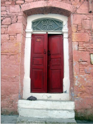
Resim 308: Ulucami Mah. Vakıfbahçe Sok. No. 9- Ana giriş kapısı
