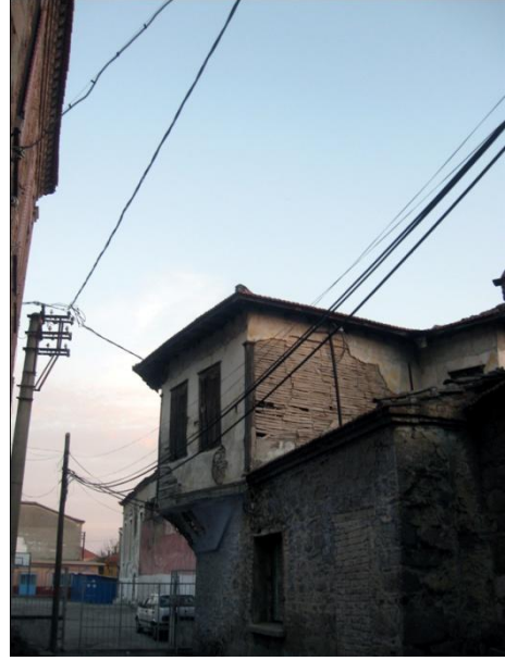
Resim 167: Arifbey Sokak'a bakan kuzeydoğu cephe
