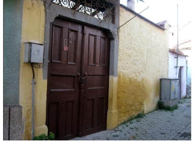
Resim 228: Talatpaşa Mah. Tabak ÇıkmaZI Sok. No. 7- Kuzeydoğu cephe
