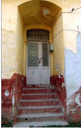
Resim 172: Talatpaşa Mah. Kara Halil Sok. No. 5- Ana giriş kapısı
