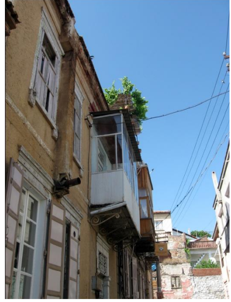
Resim 18: Talatpaşa Mah. Abacıhan Sok. No. 11- Güneydoğu cephe
