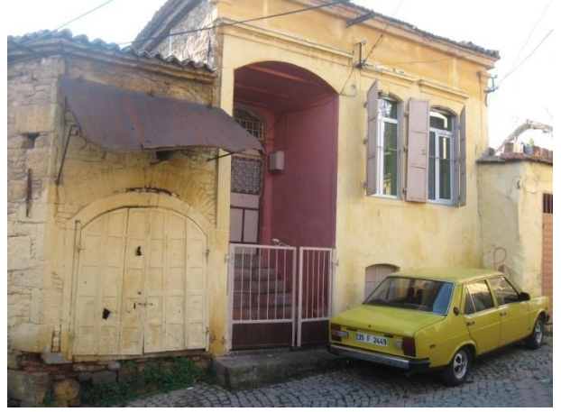
Resim 177: Talatpaşa Mah. Kılıç Ali Sok. No. 1- Kuzeydoğu cephe
