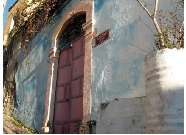
Resim 236: Talatpaşa Mah. Tabak Köprü ÇıkmaZI Sok. No. 2- Kuzeybatı cephe
