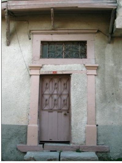
Resim 371: Kurtuluş Mah. Paşa Çıkmazi Sok. No. 1- Ana giriş kapısı
