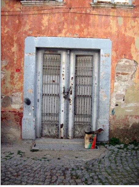
Resim 137: Talatpaşa Mah. Kadı Çıkmaşı Sok. No. 1- Ana giriş kapısı
