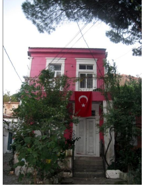
Resim 259: Ulucami Mah. İttihat-ı Terakki Cad. No. 60- Güneybatı cephe
