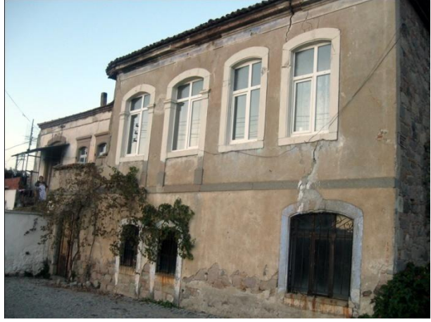
Resim 271: Ulucami Mah. İttihat-ı Terakki Cad. No. 108- Güneybatı cephe
