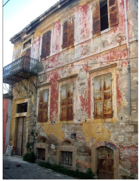
Resim 374: Kurtuluş Mah. Paşa ÇıkmaZI Sok. No. 4- Kuzeydoğu cephe
