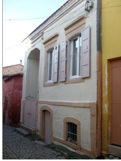
Resim 320: Kurtuluş Mah. Kalaycı Sok. No. 19- Güney cephe
