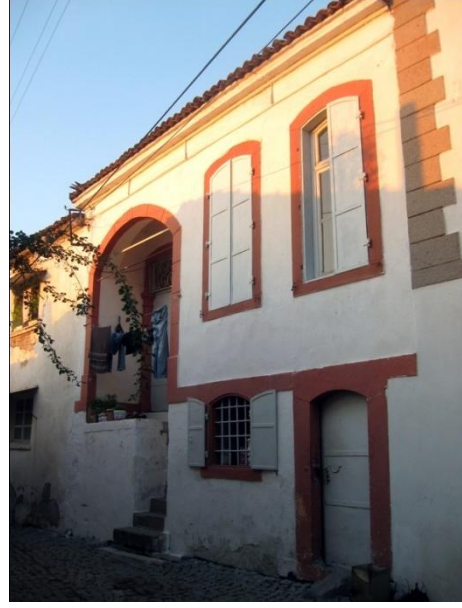
Resim 143: Talatpaşa Mah. Kadı ÇıkmaZI Sok. No. 4- Güneybatı cephe
