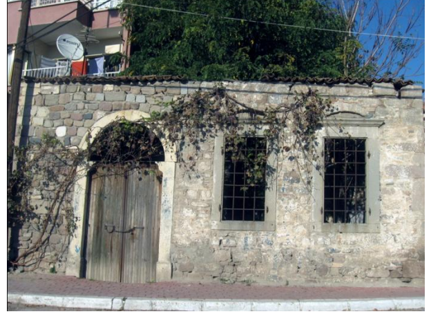
Resim 325: Kurtuluş Mah. Kınık Cad. No. 79- Güney cephe
