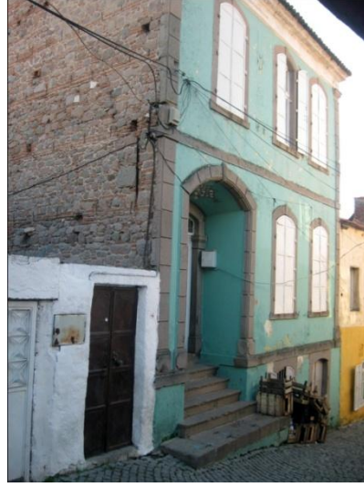
Resim 283: Ulucami Mah. Soğandere Sok. No. 11- Kuzey cephe
