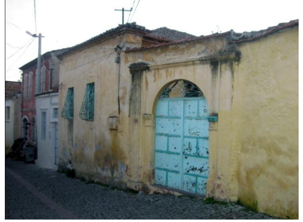
Resim 185: Talatpaşa Mah. Kılıç Ali Sok. No. 19- Kuzeydoğu cephe
