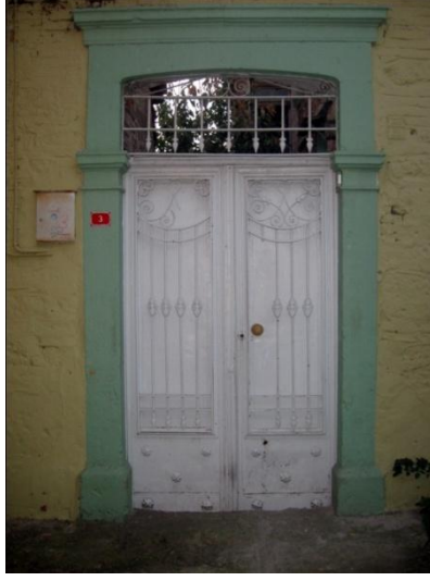
Resim 170: Talatpaşa Mah. Kara Halil Sok. No. 3- Ana giriş kapısı
