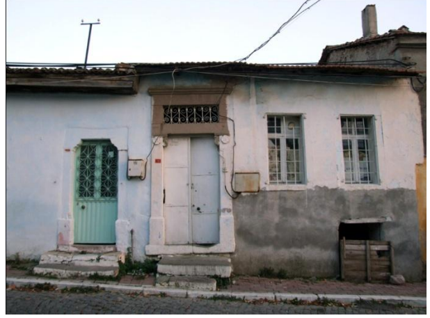
Resim 346: Kurtuluş Mah. Parmakbatıran Cad. No. 12- Kuzeybatı cephe
