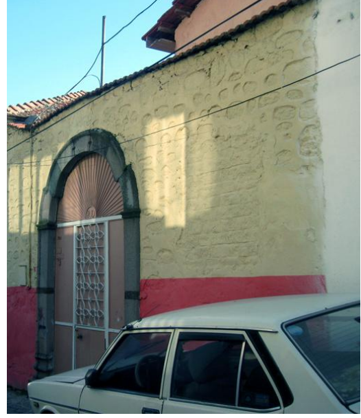
Resim 147: Talatpaşa Mah. Kadı Sok. No. 1- Kuzeydoğu cephe
