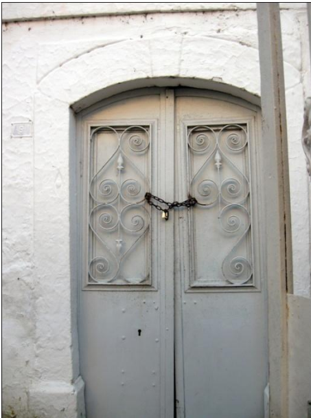
Resim 53: Zemin kattaki tali giriş
