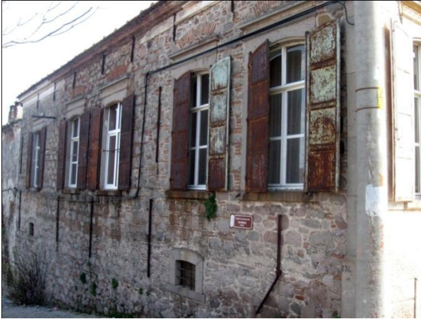
Resim 359: Kuzeydoğu cepheden detay
