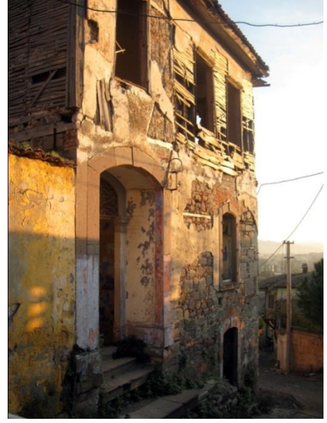
Resim 335: Kurtuluş Mah. Mahmut Şevket Paşa Cad. No. ?- Kuzeybatı cephe
