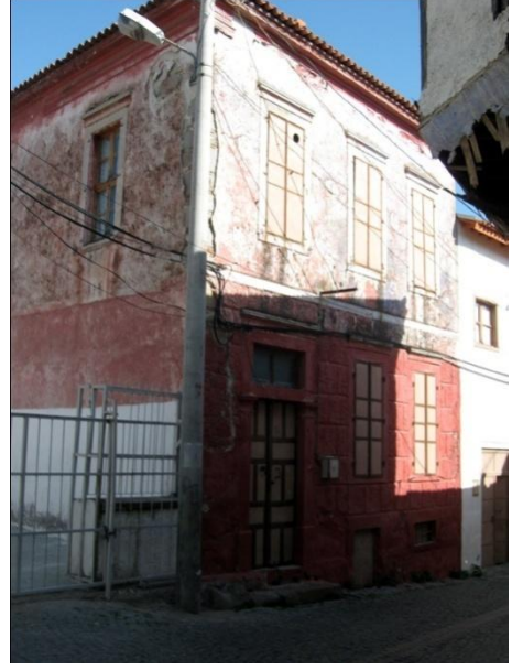
Resim 169: Talatpaşa Mah. Kadı Sok. No. 20- Kuzeybatı cephe
