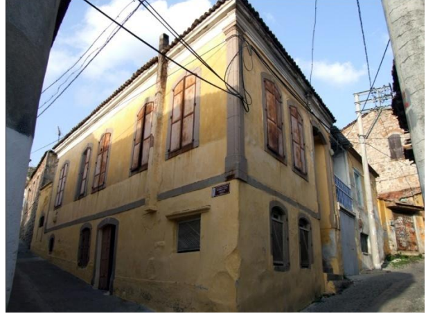
Resim 205: Talatpaşa Mah. Mahmut Şevket Paşa Sok. No. 7 - Mahmut Paşa Çıkma Sok. No. 2- Güneydoğu ve güneybatı cepheler
