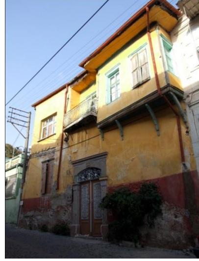
Resim 81: Talatpaşa Mah. Dede Sok. No. 6- Güneybatı cephe
