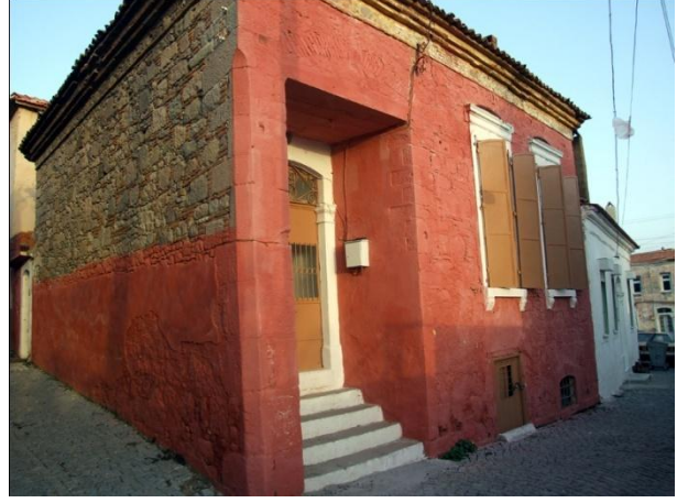
Resim 406: Kurtuluş Mah. Turgut Sok. No. 14- Güneybatı cephe
