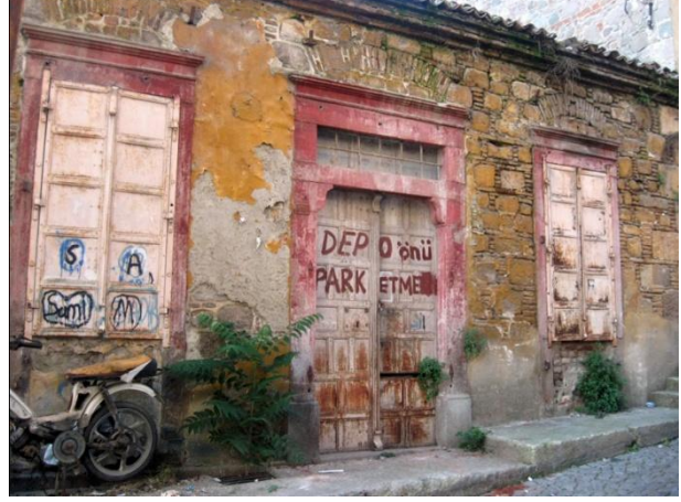
Resim 6: Talatpaşa Mah. Abacıhan Sok. No. 3- Güneydoğu cephe
