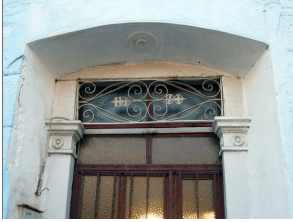
Resim 390: Aydınlatma penceresi ve inşa tarihinden detay
