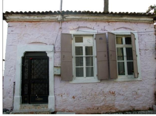
Resim 410: Kurtuluş Mah. Turgut Sok. No. 19- Kuzeydoğu cephe
