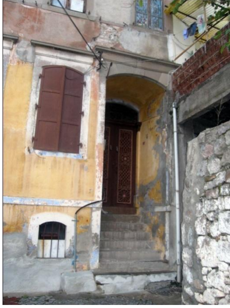
Resim 216: Talatpaşa Mah. Şark ÇıkmaZI Sok. No. 2A- Ana giriş kapısı
