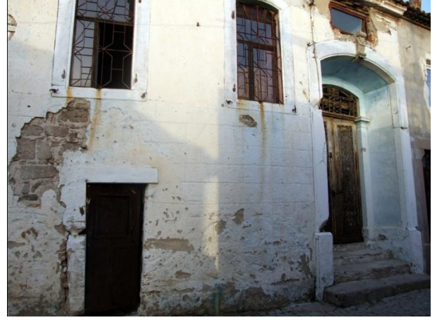
Resim 412: Kurtuluş Mah. Turgut Sok. No. 22- Kuzeydoğu cephe
