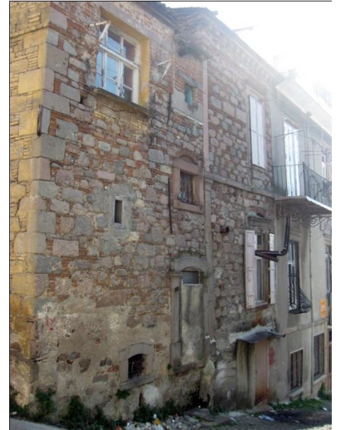
Resim 34: Talatpaşa Mah. Samanpazarı Sok. No. 17'deki kuzeybatı cephe
