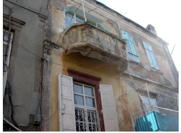
Resim 22: Talatpaşa Mah. Samanpazarı Sok. No. 10-14A'daki kuzeybatı cephe
