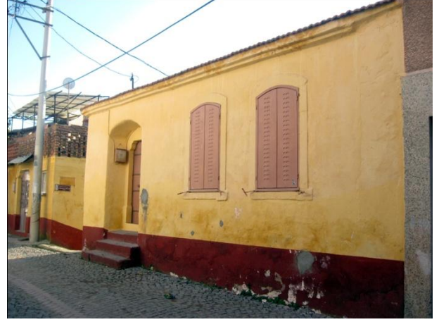
Resim 416: Kurtuluş Mah. Turgut Sok. No. 23- Kuzeydoğu cephe
