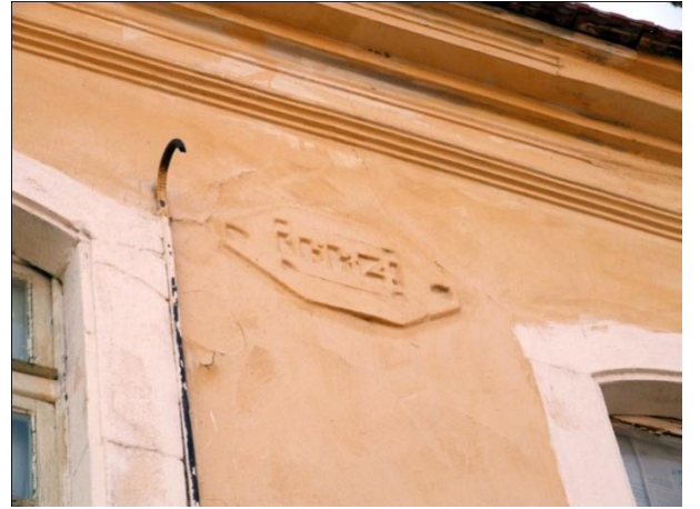
Resim 203: Yapının inşa tarihini gösteren pano
