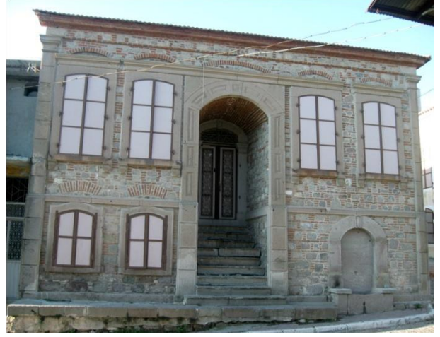
Resim 348: Kurtuluş Mah. Parmakbatıran Cad. No. 17- Güneydoğu cephe
