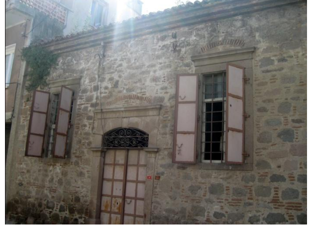
Resim 14: Talatpaşa Mah. Abacıhan Sok. No. 9- Güneydoğu cephe
