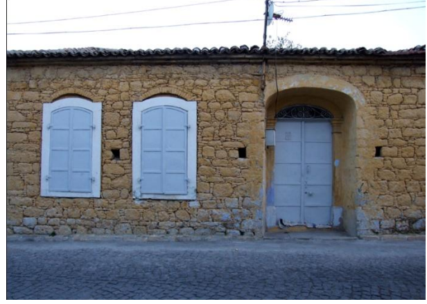
Resim 364: Kurtuluş Mah. Parmakbatıran Cad. No. 38- Kuzeybatı cephe
