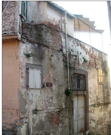
Resim 126: Talatpaşa Mah. Abacıhan Sok. No. 44- Kuzeybatı cephe
