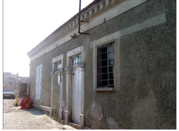
Resim 232: Talatpaşa Mah. Tabak Köprü Cad. No. 1- Güneydoğu cephe
