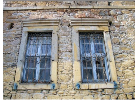
Resim 48: Talatpaşa Mah. Alp Çıkması Sok. No. 1- Pencerelerden detay
