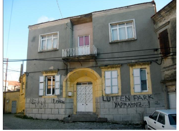
Resim 128: Talatpaşa Mah. Dede Sok. No. 36- Kuzey cephe
