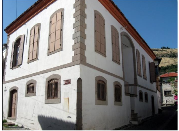
Resim 161: Talatpaşa Mah. Kadı Sokak ve Kadı Çıkmazı Sokak'taki güneydoğu ve güneybatı cepheler
