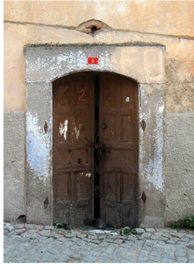
Resim 7: Talatpaşa Mah. Samanpazarı Sok. No. 2'de yer alan tali giriş kapısı
