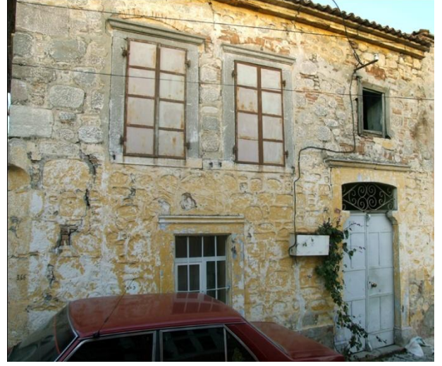
Resim 408: Kurtuluş Mah. Turgut Sok. No. 16- Güneybatı cephe
