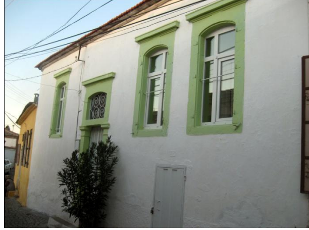
Resim 312: Ulucami Mah. Vakıfbahçe Sok. No. 10- Güneybatı cephe
