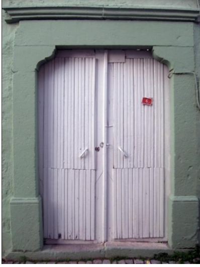
Resim 174: Talatpaşa Mah. Kara Halil Sok. No. 6- Ana giriş kapısı
