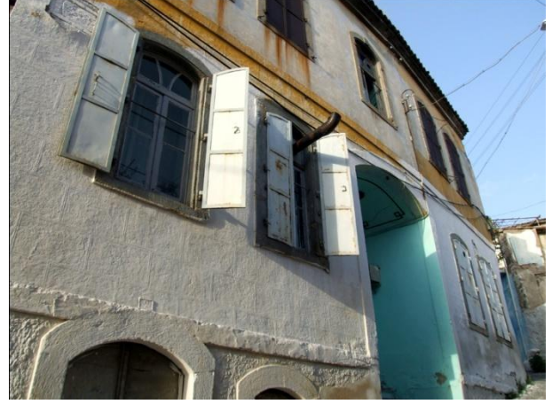
Resim 209: Talatpaşa Mah. Mahmut Şevket Paşa Sok. No. 13- Güneydoğu cephe
