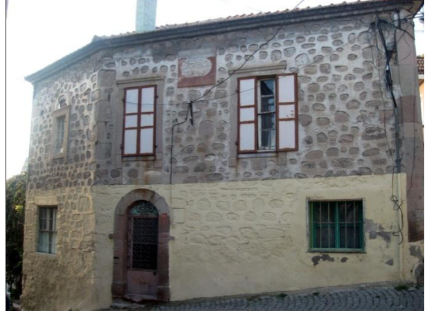
Resim 36: Talatpaşa Mah. Abacıhan Sok. No. 25- Güney ve güneydoğu cephe
