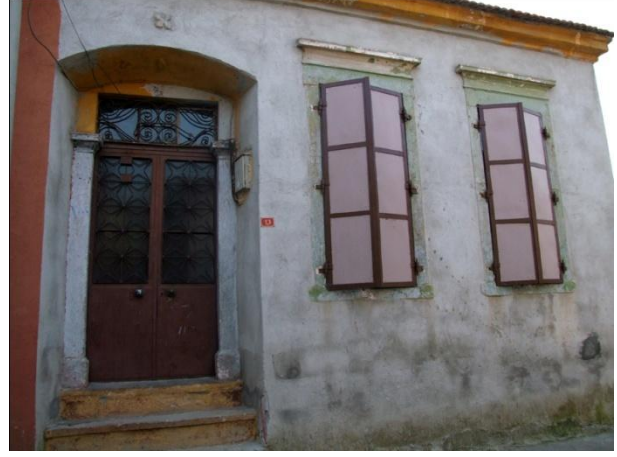
Resim 404: Kurtuluş Mah. Turgut Sok. No. 13- Kuzeydoğu cephe
