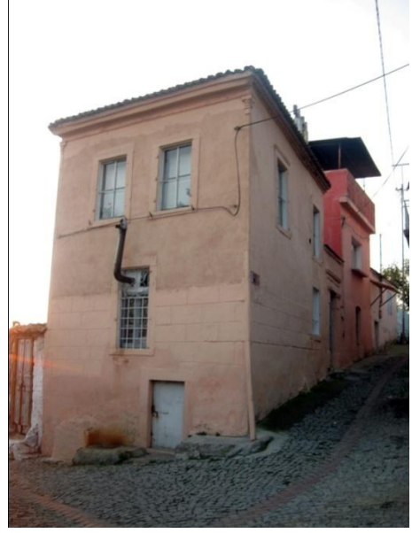
Resim 238: Talatpaşa Mah. Talatpaşa Ertuğrul ÇıkmaZI Sok. No. 1- Kuzey cephe
