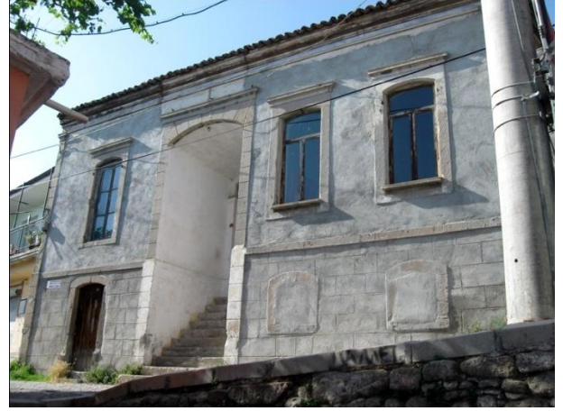
Resim 240: Talatpaşa Mah. Talatpaşa Ertuğrul Sok. No. 3- Güney cephe
