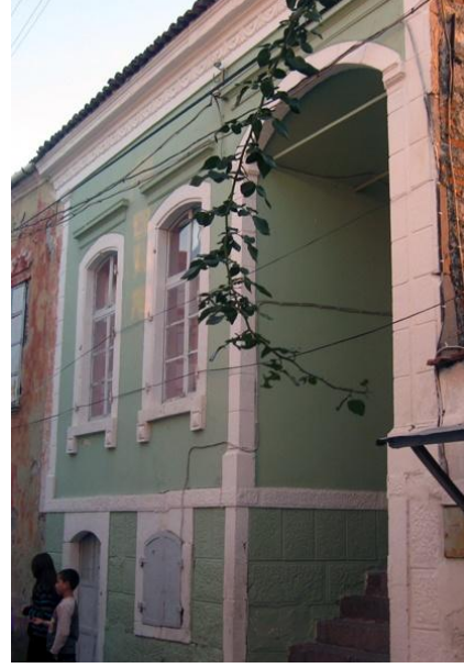
Resim 141: Talatpaşa Mah. Kadı ÇıkmaZI Sok. No. 3- Kuzeydoğu cephe
