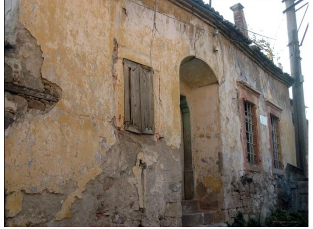
Resim 134: Talatpaşa Mah. DüNDAR Sok. No. 19- Kuzey cephe
