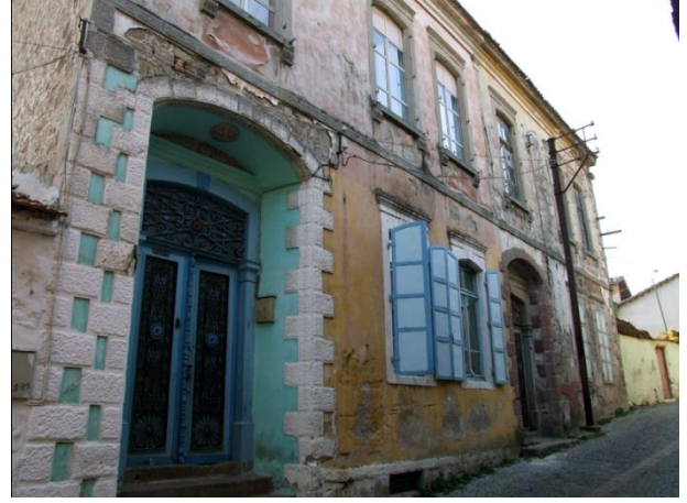
Resim 92: Talatpaşa Mah. Dede Sok. No. 19- Kuzeydoğu cephe
