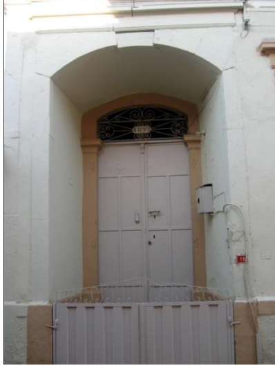
Resim 319: Kurtuluş Mah. Kalaycı Sok. No. 19- Ana giriş kapısı
