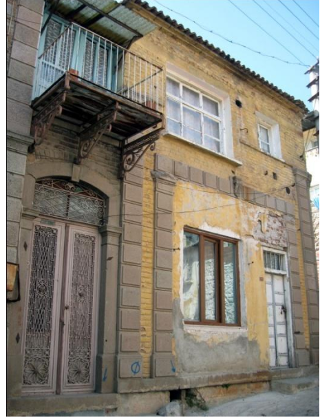
Resim 30: Talatpaşa Mah. Abacıhan Sok. No. 15-17- Güneydoğu cephe
