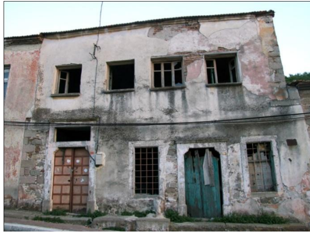
Resim 342: Kurtuluş Mah. Parmakbatıran Cad. No. 4- Kuzeybatı cephe
