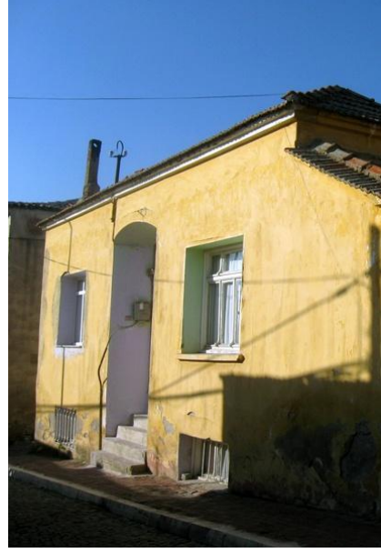
Resim 333: Kurtuluş Mah. Kınık Cad. No. 93- Güney cephe
