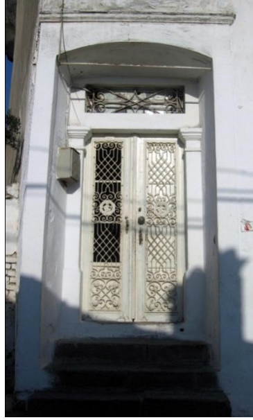
Resim 72: Talatpaşa Mah. Arıfbey Sok. No. 10- Ana giriş kapısı
