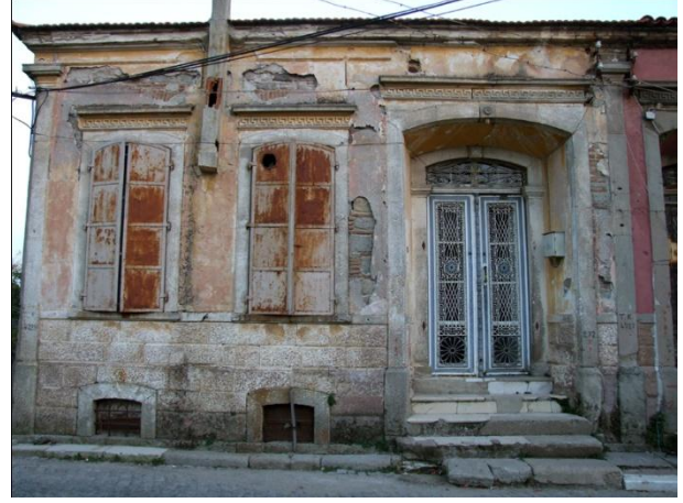
Resim 356: Kurtuluş Mah. Parmakbatıran Cad. No. 32- Kuzeybatı cephe
