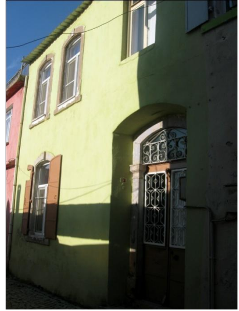
Resim 314: Kurtuluş Mah. Kalaycı Sok. No. 7- Güney cephe
