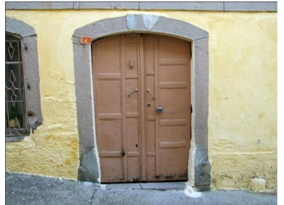
Resim 207: Güneybatı cephede yer alan tali giriş
