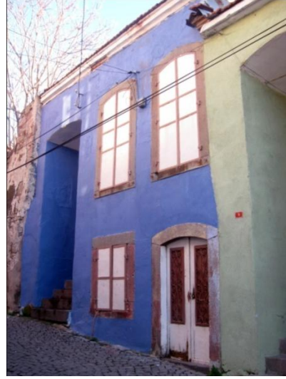
Resim 279: Ulucami Mah. Soğandere Sok. No. 3- Kuzey cephe
