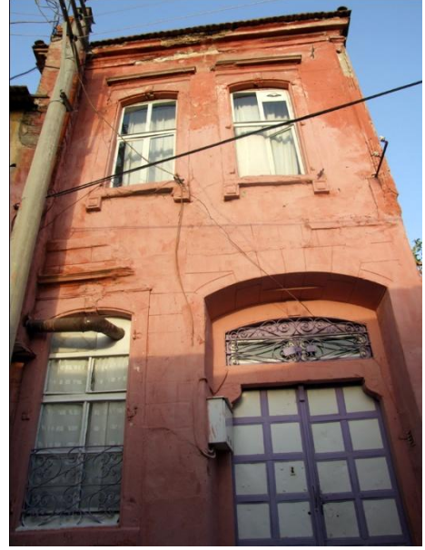
Resim 418: Kurtuluş Mah. Turgut Sok. No. 36- Güneybatı cephe
