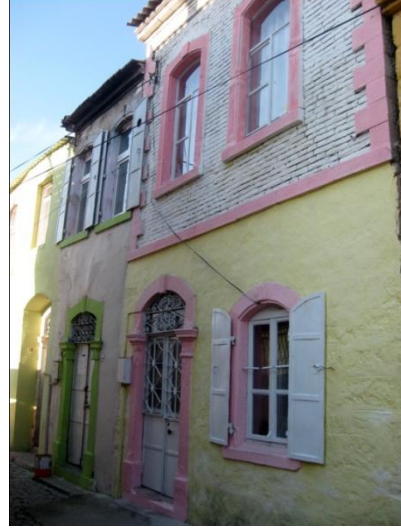
Resim 318: Kurtuluş Mah. Kalaycı Sok. No. 11- Güney cephe
