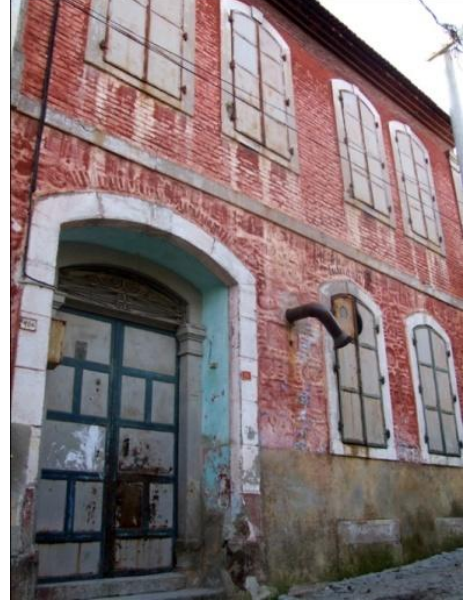
Resim 179: Talatpaşa Mah. Kılıç Ali Sok. No. 15- Kuzeydoğu cephe
