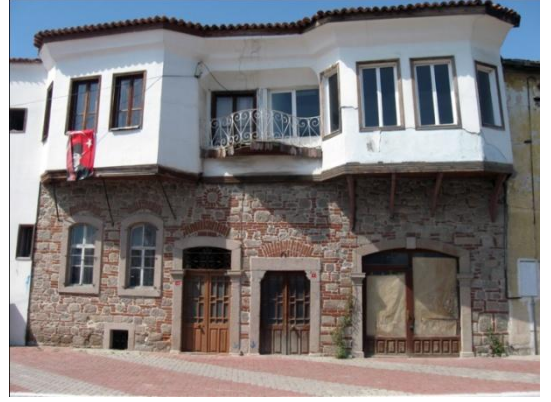
Resim 187: Talatpaşa Mah. Kınık Sok. No. 49-51- Güney cephe
