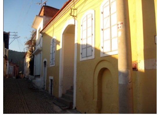
Resim 305: Ulucami Mah. Vakıfbahçe Sok. No. 2- Güneybatı cephe
