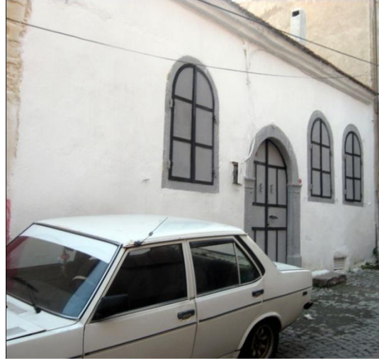
Resim 149: Talatpaşa Mah. Kadı Sok. No. 3- Kuzeydoğu cephe
