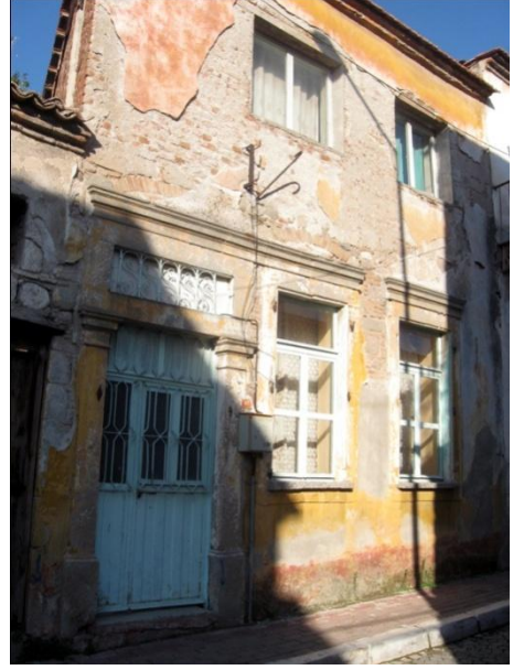
Resim 327: Kurtuluş Mah. Kınık Cad. No. 87- Güney cephe
