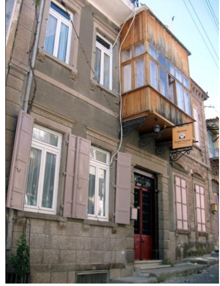
Resim 24: Talatpaşa Mah. Abacıhan Sok. No. 13- Güneydoğu cephe
