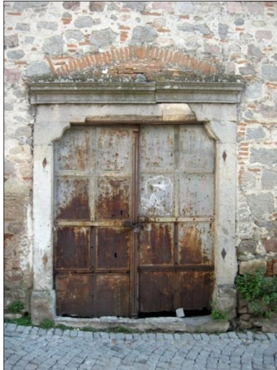
Resim 15: Talatpařa Mah. Samanpazarı Sok. No. 8’de yer alan tali giriř kapısı
