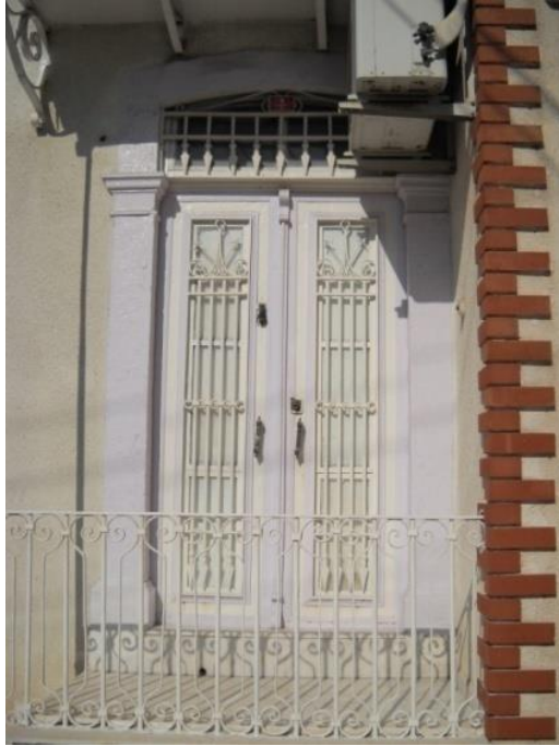
Resim 240: Zemin Kat Giriş Kapısı
