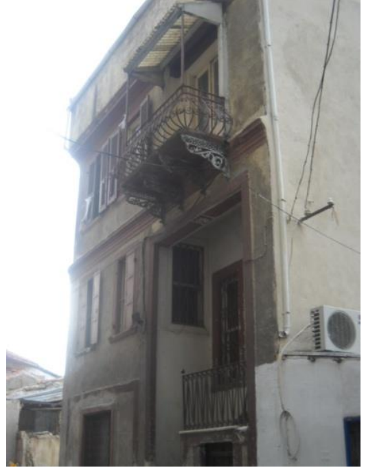
Resim 218: Güney Cephesi (Doğudan)
