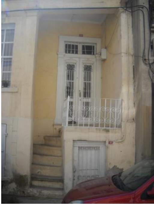
Resim 229: Ana Giriş ve Bodrum Kapıları
