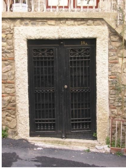
Resim 26: Bodrum giriş kapısı
