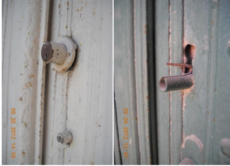
Resim 267: Urla ev kapılarında bir arada bulunan eski ve yeni kilit sistemlerine örnekler 287
