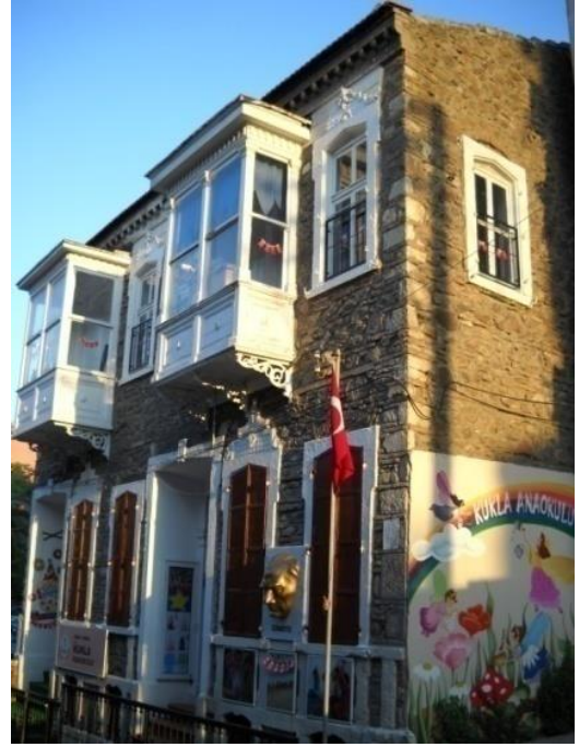
Resim 246: Güney Cephesi (Doğudan)
