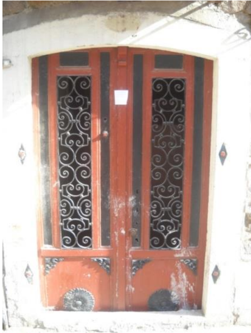
Resim 260: Bodrum Giriş Kapısı
