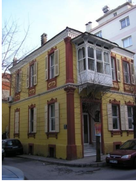
Resim 69: Doğu ve Güneydoğu Cepheleri
