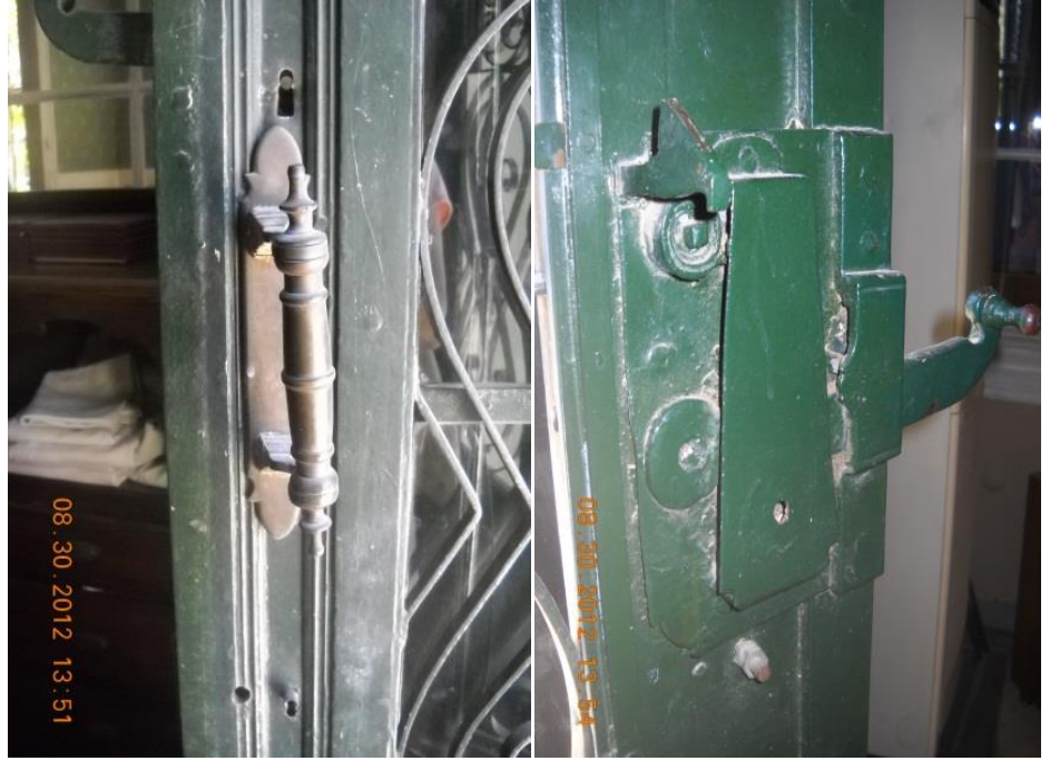
Resim 265: 1800 lü yılların ikinci yarısında yaptırılan bir Rum evinde hizmet veren Urla Mahfel Restoran'a ait kapının kilit mekanizmasının içeriden ve dışarıdan görünümü 285
