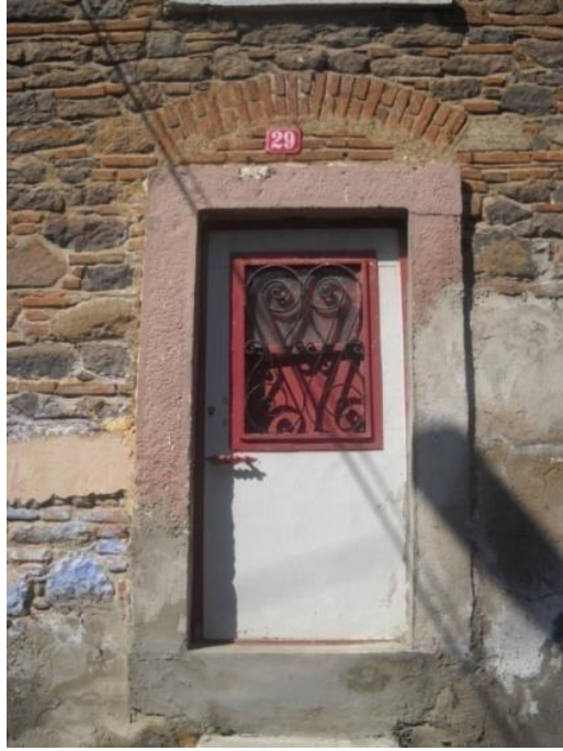
Resim 58: Doğu Cephesi Üzerindeki Kapı (No. 29)
