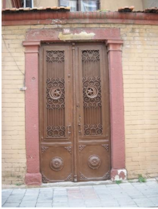
Resim 165: Batı cephesi üzerindeki bahçe kapısı
