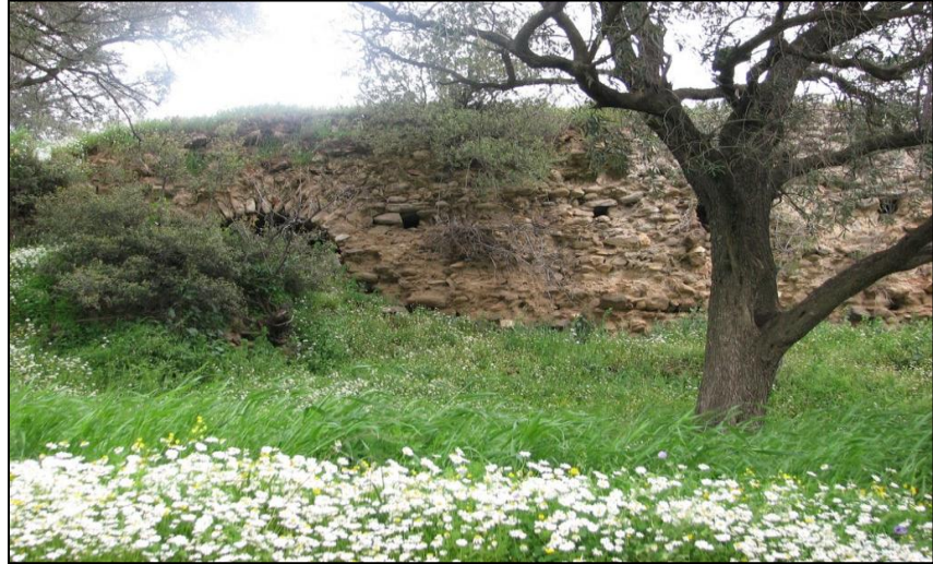
Şekil 26: Hypaipa Sur Duvarları
