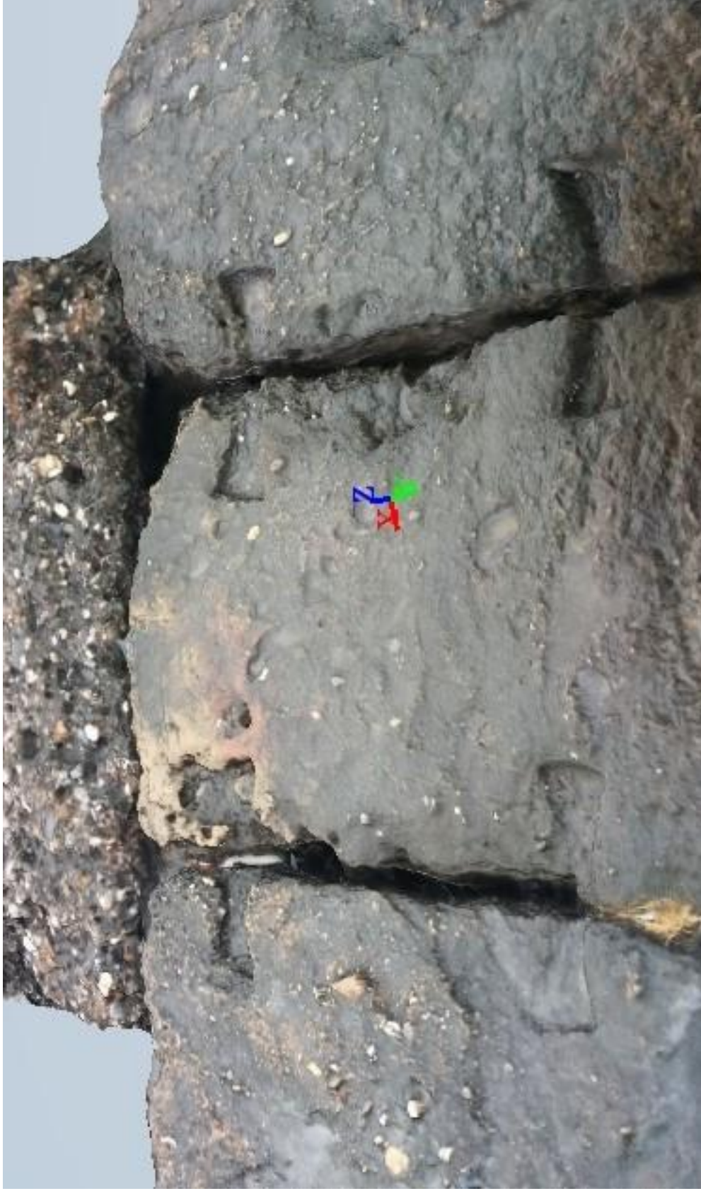
Katalog 15: Mendirek platformunda kenet yuvalarının izlenebildiği in situ üç sıra blok fotogrametri kesiti
