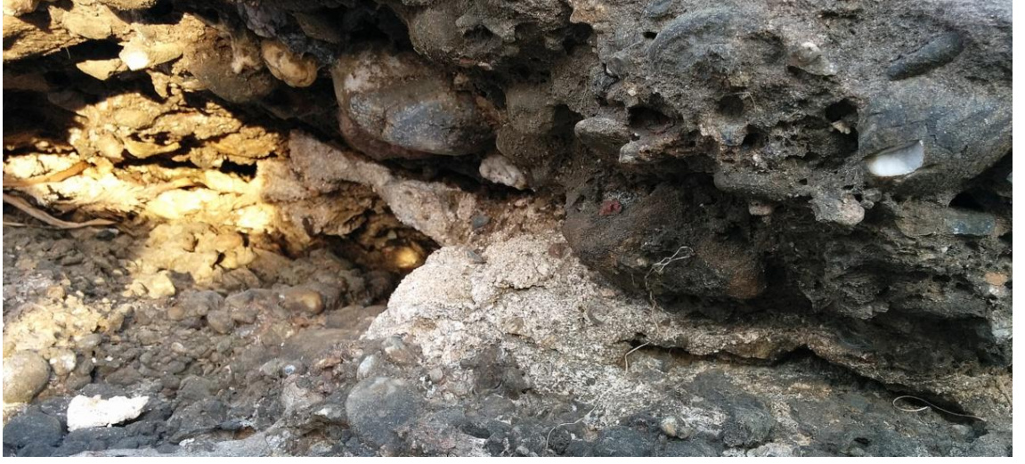
Şekil 16: 3. ve 4. sıra blokların arasında tespit edilen harç izleri. (Elmalı G., Ege Üniversitesi, Sualtı Arkeolojisi Yüksek Lisans Programı Arşivi-2015)
