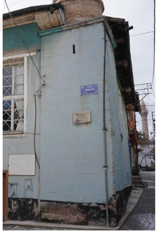
Fot.10- Minare kaidesi.
