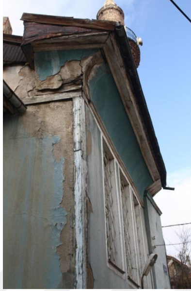
Fot.5- Ahşap karkas tekniđi
