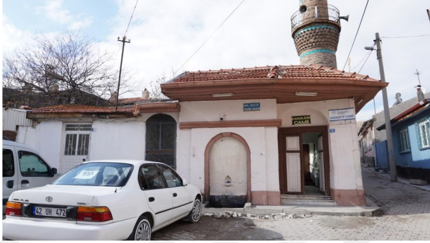
Fot.1- Doğu cephe.
