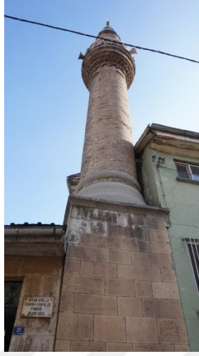
Fot.4- Minare ve kaidesi.
