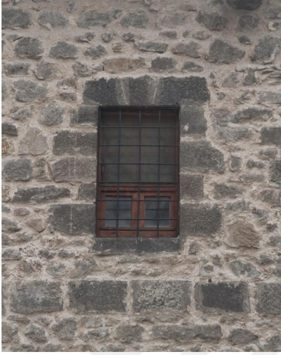
Fot. 9- Kuzey cephe, dikdörtgen pencere açıklığı.
