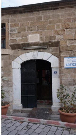
Fot. 2- Ana giriş kapısı.
