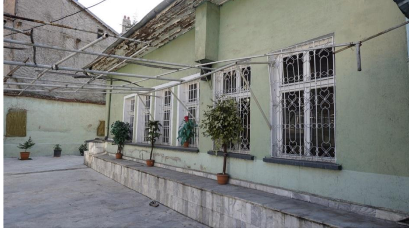
Fot.1- Batı cephe.
