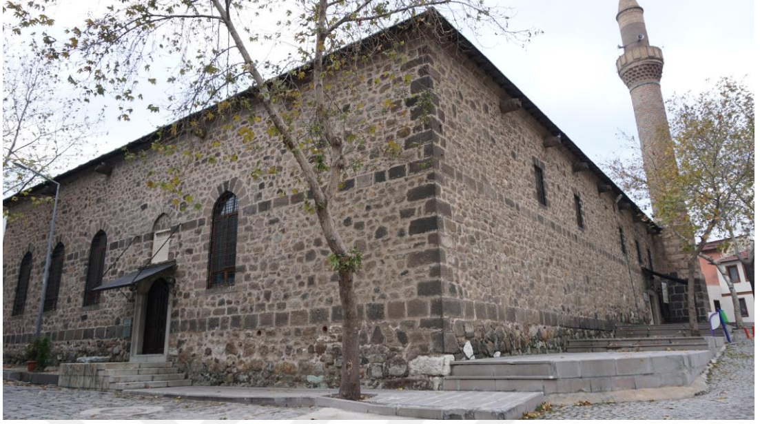
Fot. 4- Dođu ve kuzey cephedeki üç sıra düzgün kesme taş sırası.
