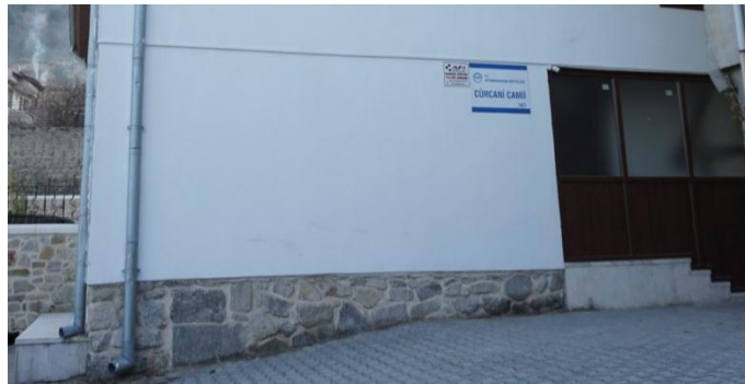
Fot.3- Giriş cephesi.
