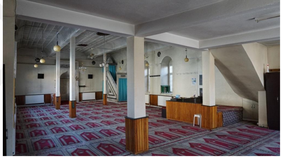
Fot.9- Ahşap destekler.
