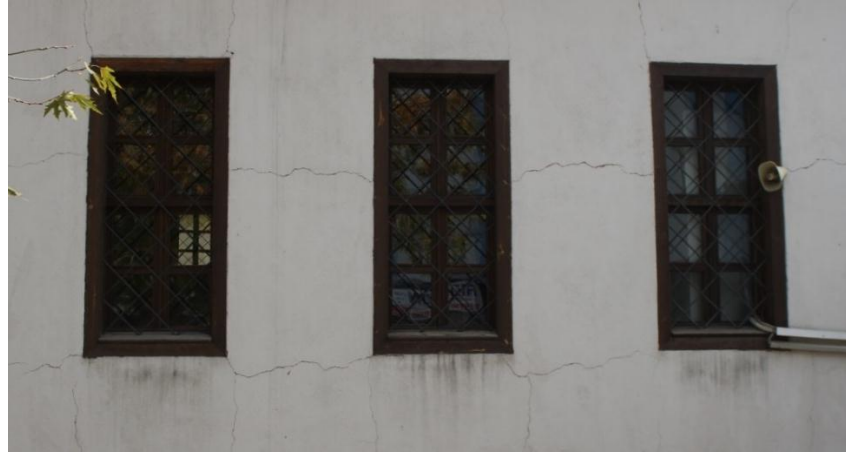
Fot.3- Batı cephe.
