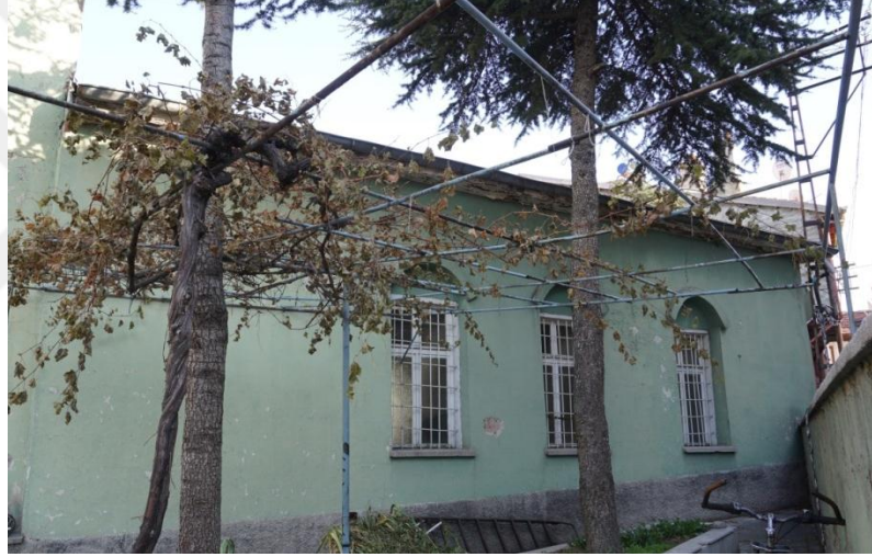
Fot.2- Doğu cephe.
