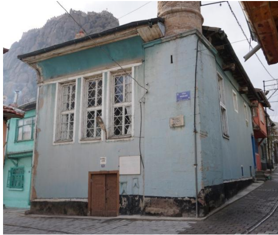
Fot.4- Doğu cephe.
