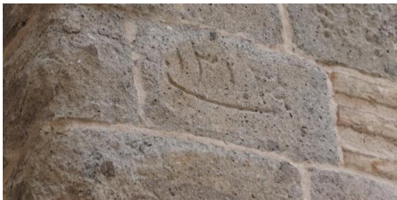
Fot.25- Minare kaidesindeki yazı.
