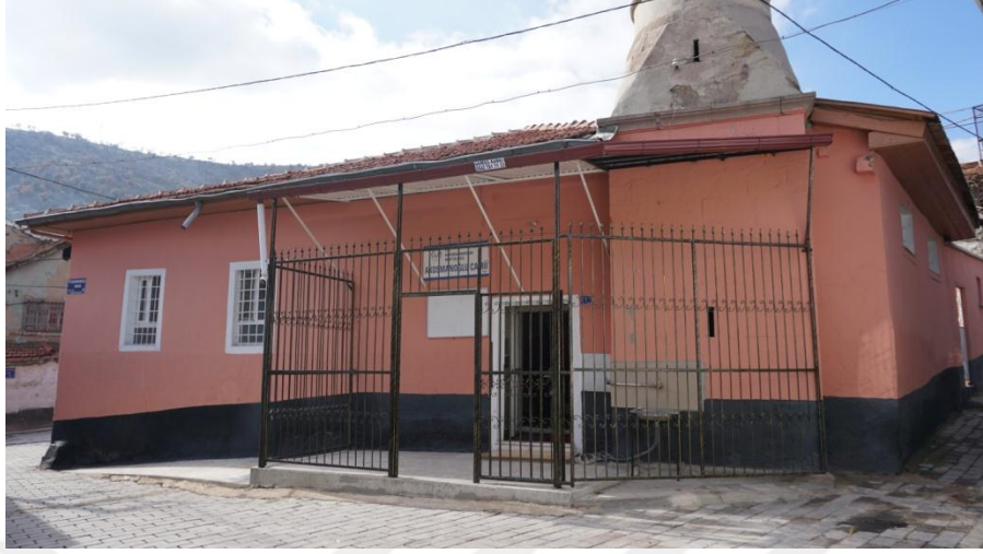
Fot.1- Doğu cephe.
