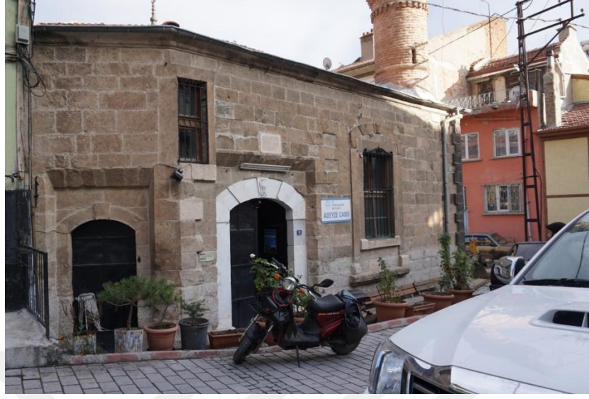
Fot. 1- Batı cephe.
