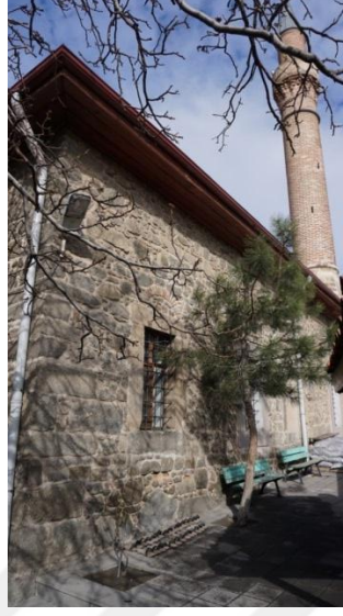
Fot.5- Güney cephe.
