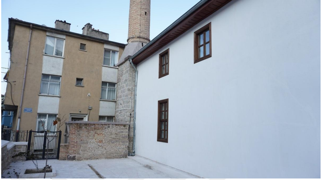
Fot.7- Batı cephe.
