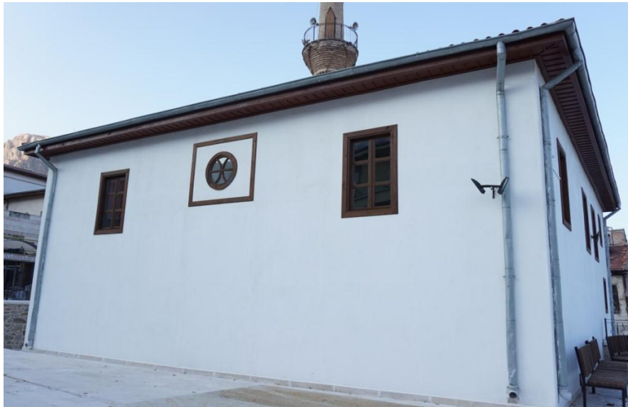
Fot.6- GÜney cephe.
