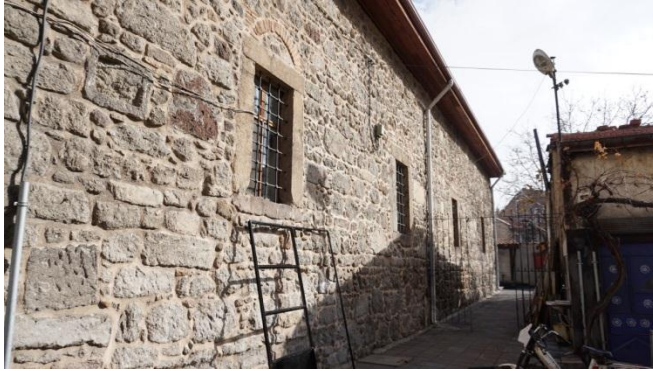
Fot.4- Batı cephe.
