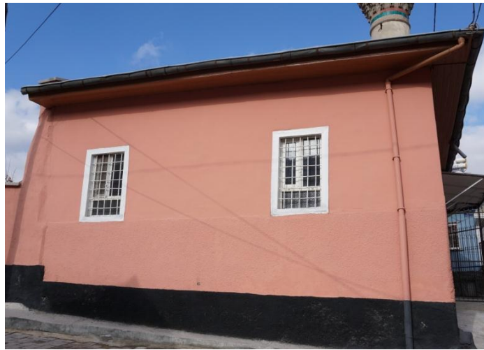
Fot.3- Güney cephe.
