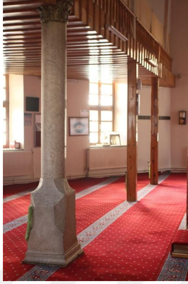
Fot.10- Mermer ve ahşap destekler.
