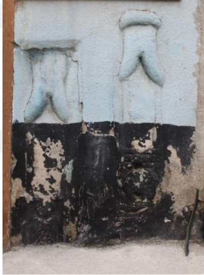
Fot.2- Doğu cephedeki devşirme taşlar.
