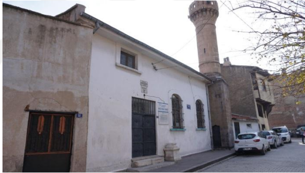
Fot.3- Hacı Nuh Camii.
