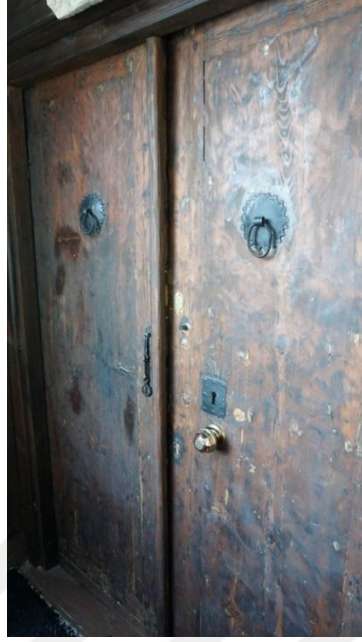
Fot.1- Kuzey cephe. Kapı.
