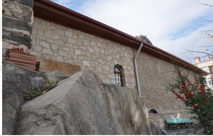
Fot.6- Doğu cephe.
