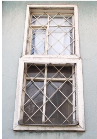
Fot.7- Kuzey cephe dikdörtgen pencere aıklığı.
