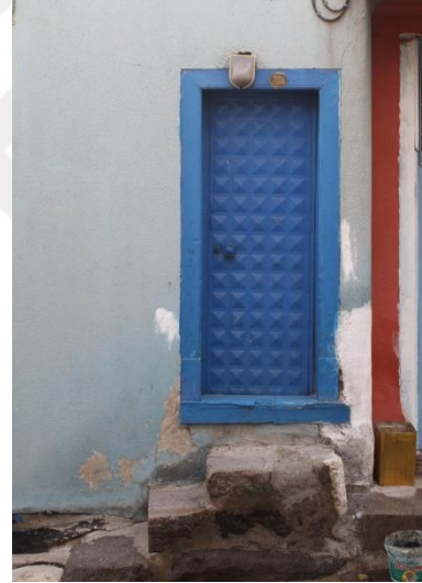
Fot.3- Kuzey cephe, kadınlar mahfili girişi.
