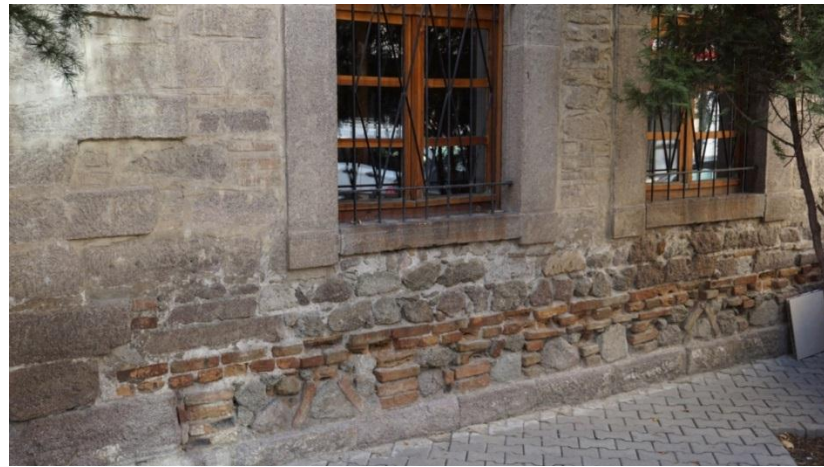
Fot.3- Batı cephe. Kasetleme tekniği.
