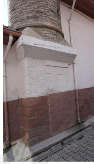
Fot.6- Minare kaidesi.
