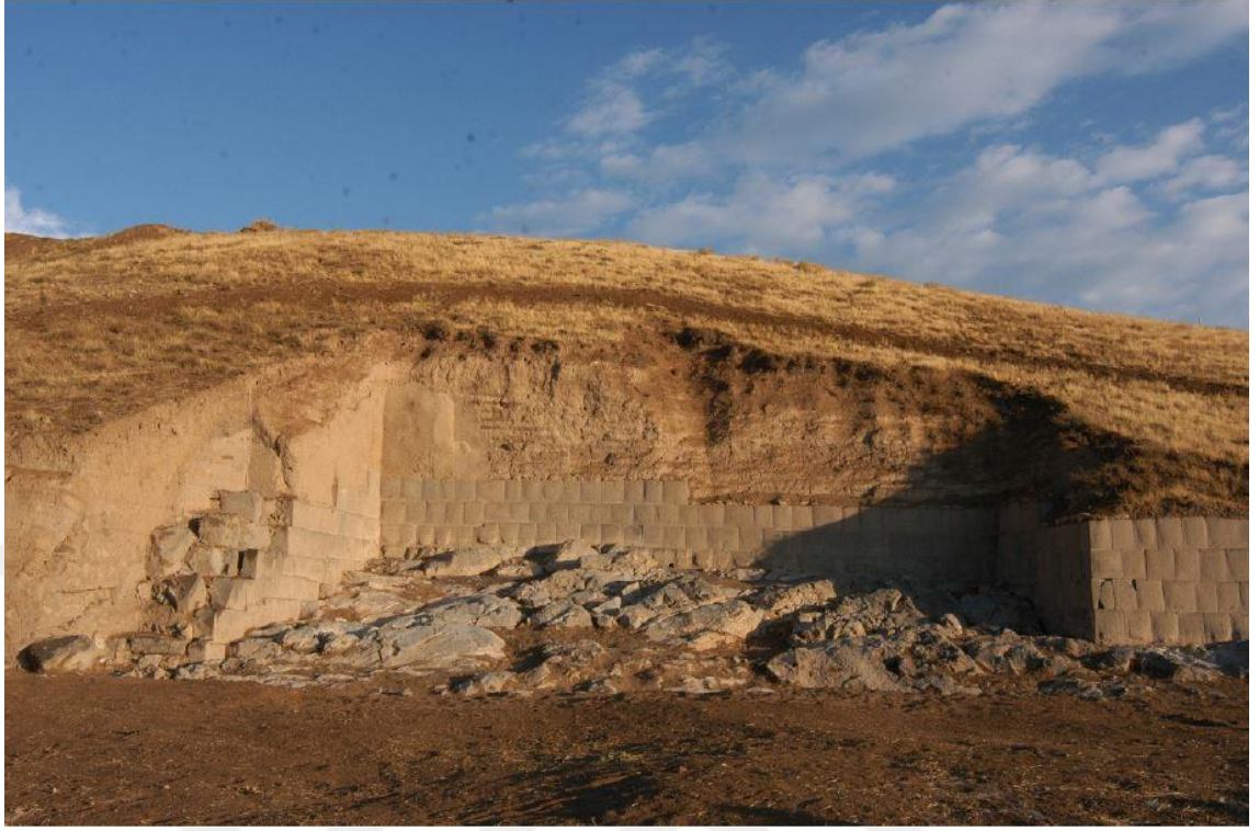
Şekil 5: Güney Sur Duvarı
