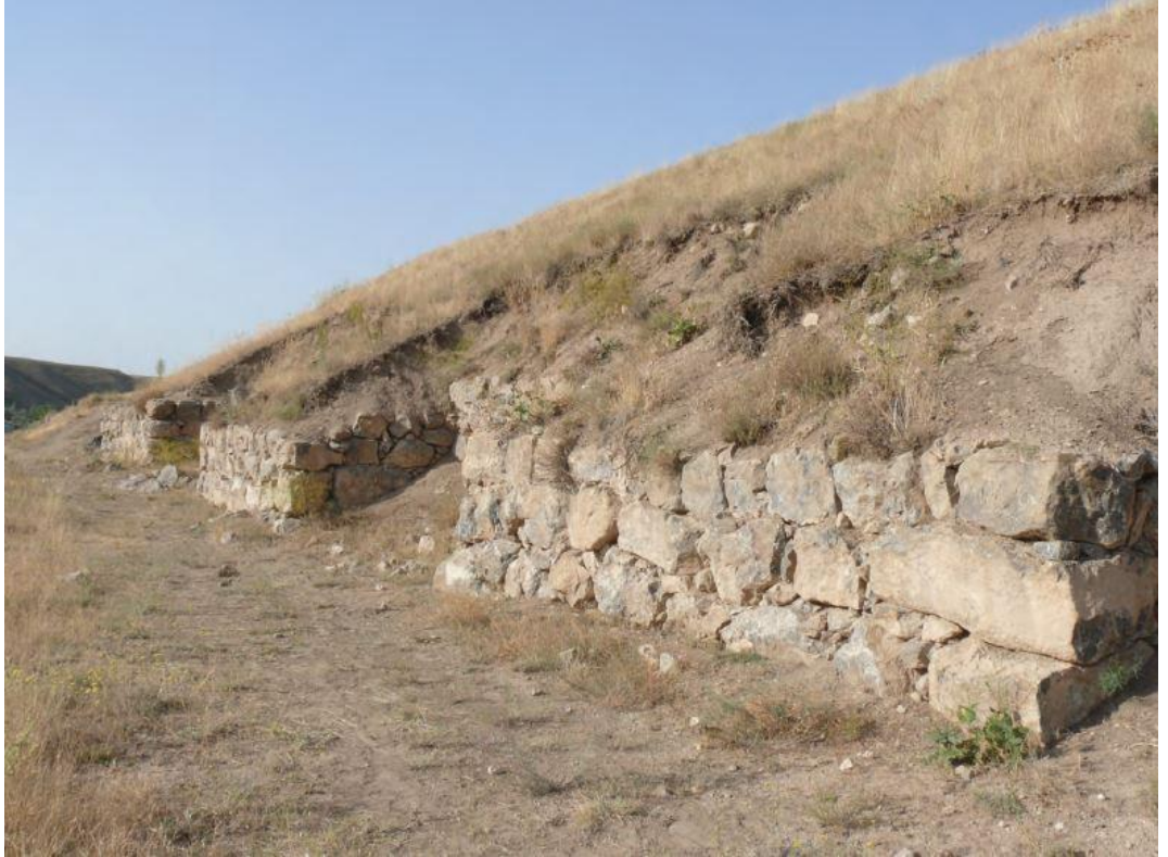
Şekil 4: Doğu Sur Duvarı
