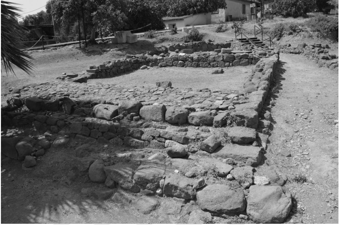
Resim 61: 1.Bölgedeki Athena Caddesi'ne bakan duvarlar ve yapılar. (Erdoğan 2016 23, Res. 7)
