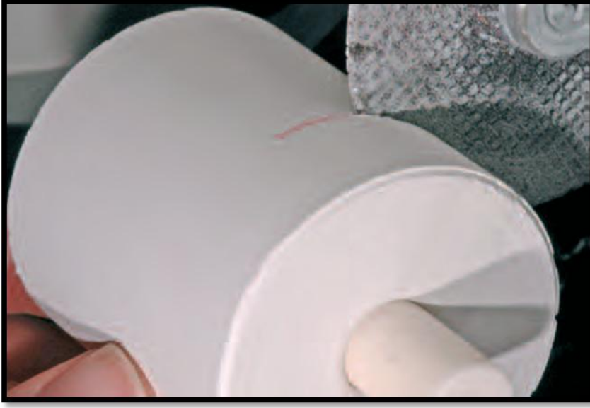
Resim 46: İşaretlenen uzunluktan revetmanın separe ile kesilmesi
