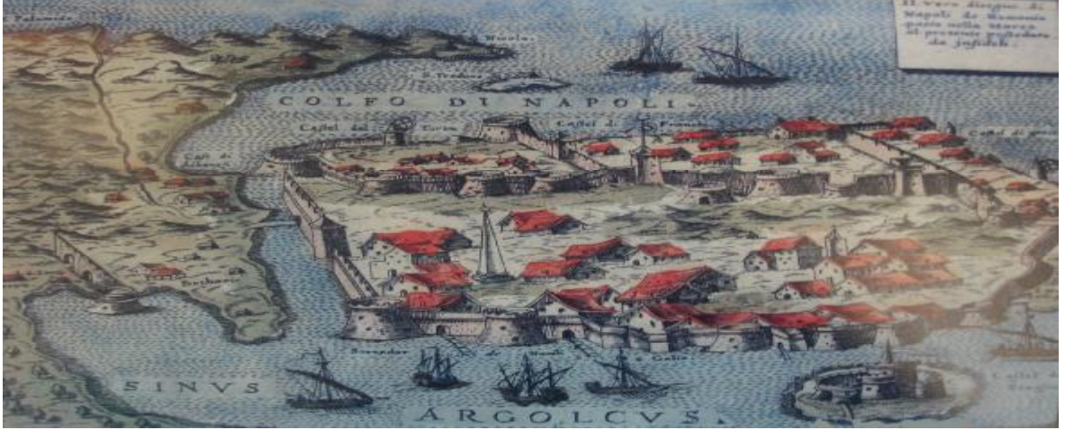
Şekil 3.3.4.1. Anabolu Limanı, Palamento Kalesi ve Bokia Ada Kalesi, Pınargenti, 1573, Kudüs Üniversitesi Kütüphanesi
