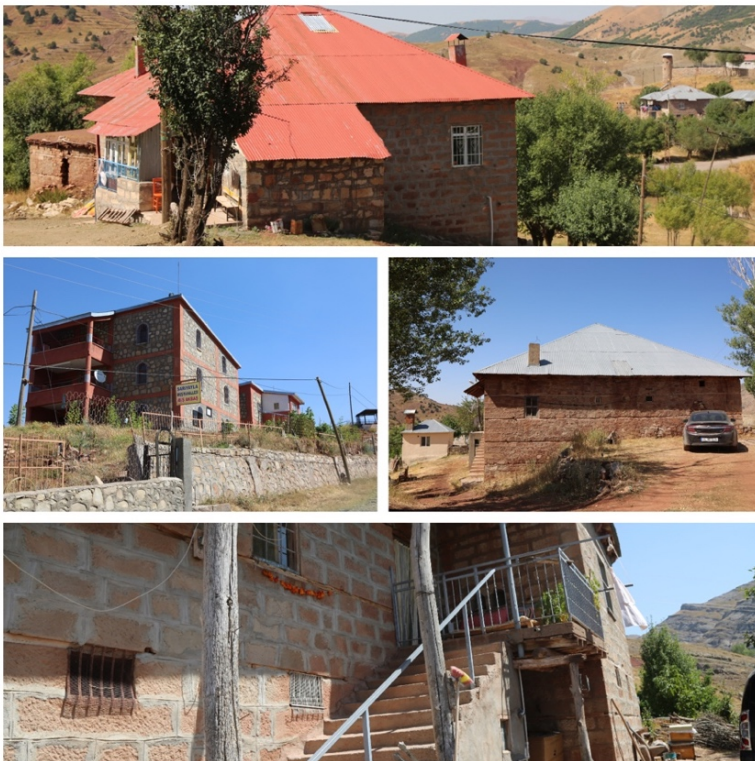
Fotoğraf 3.25 Sarıyayla köyünde çoğu konutun tamamı taş malzemenen, çatıları ise sacdan oluşmuştur.
