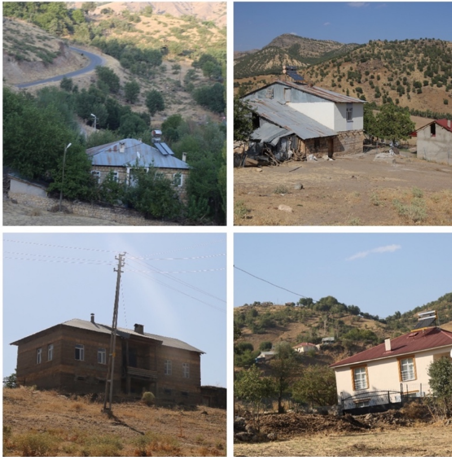
Fotoğraf 3.22 Aşağıdoluca köyünde konutların çoğu, tek veya çift katlı, sac çatılı betonarme yapılarıdır.
