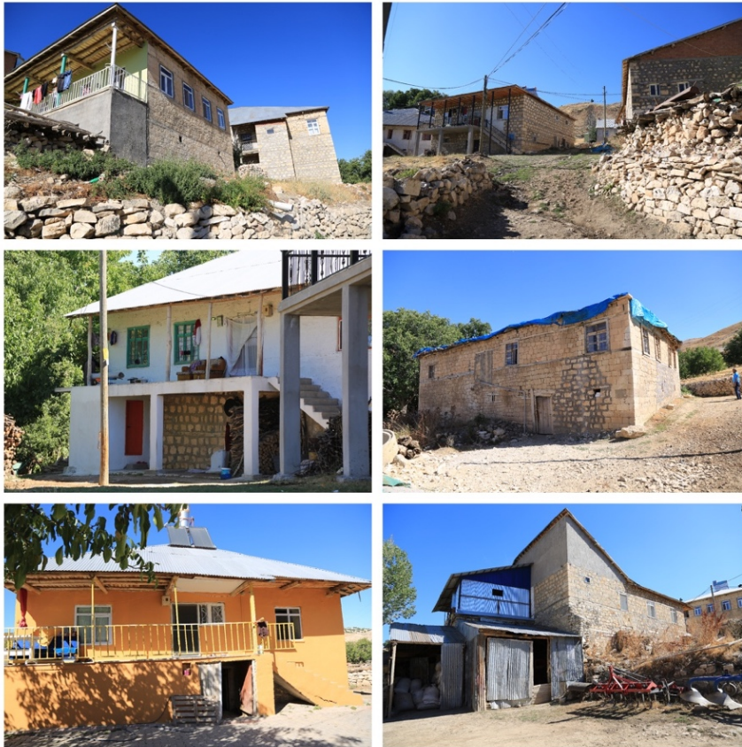
Fotoğraf 3.45 Dervişcemaal köyünde konutlar genellikle iki katlı, alt katı ahır ve taş malzemeden oluşmaktadır.
