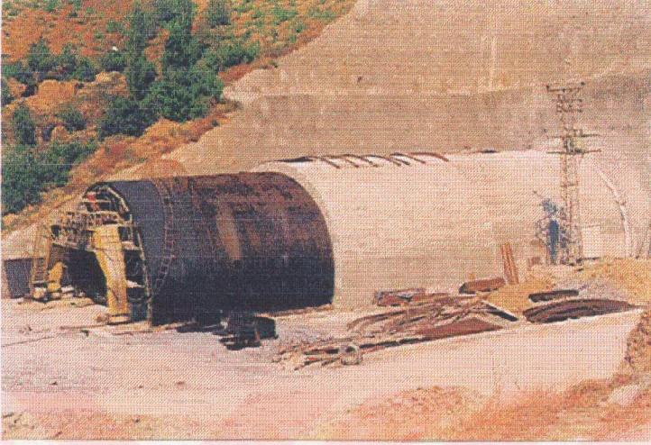
Resim 4. Kızlaç (T3A) tüneline ölçüm piminin yerleştirilmesi için jumbo ile delik delinirken.
