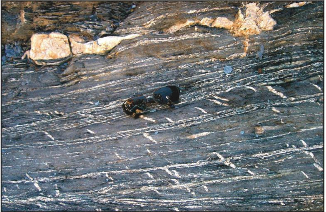
Şekil 4.67. Yelli Burun civarında, Üst Permiyen yaşlı Cocakdere Formasyonu'na ait şistlerde makaslama etkisiyle gelişmiş kalsit dolgulu tansiyon çatlakları.
