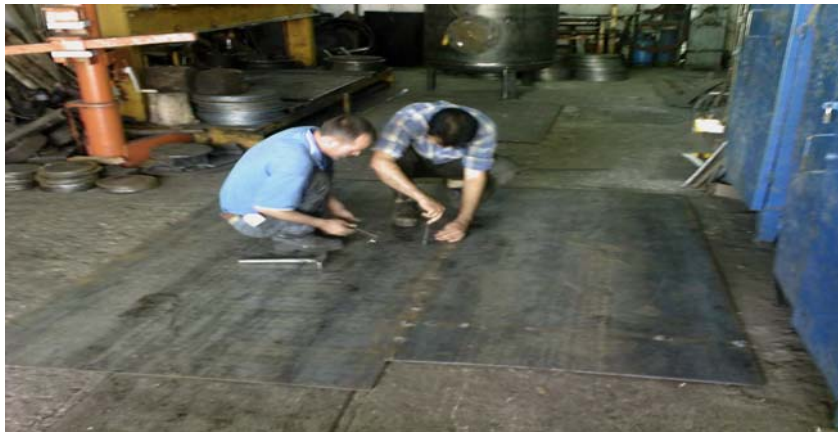
Şekil 3.43. Yerde Tabaka Saclar Üzerine Koninin Açılımının Çizilmesi
