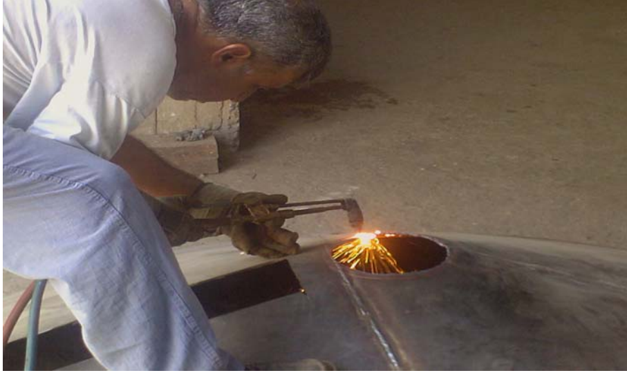
řekil 3.48. Flanř İin Kesim Yapılırken
