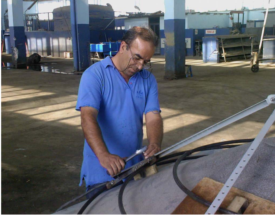
Şekil 3.66. Köşebentlerin 5/16 Bağlantı Somunlarının Sıkılması
