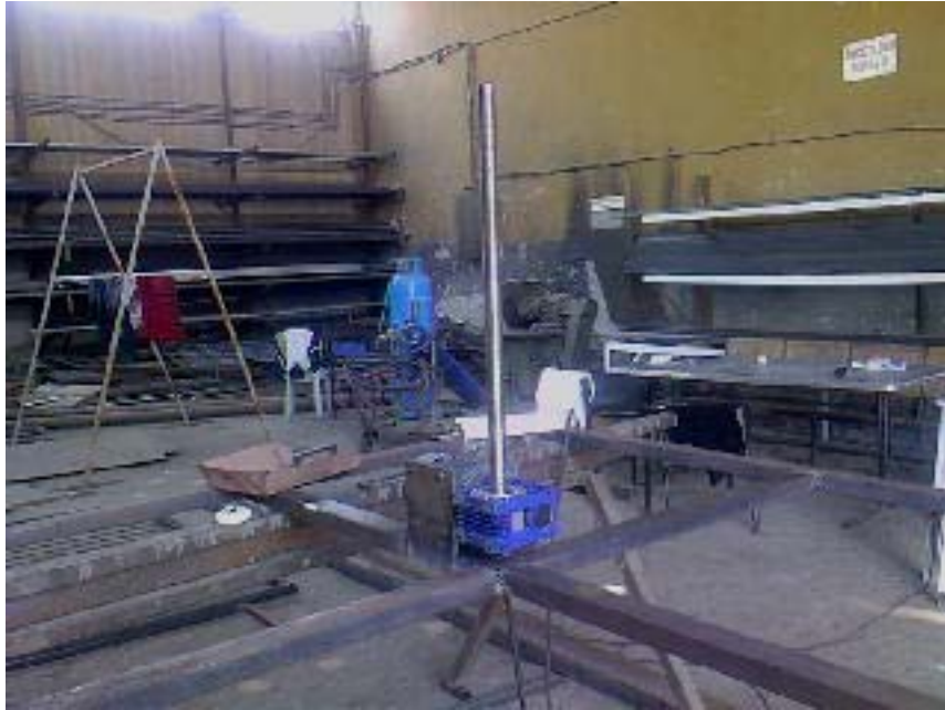
Şekil 3.58. Redüktörün Alt Tablaya Merkezlenmesi
