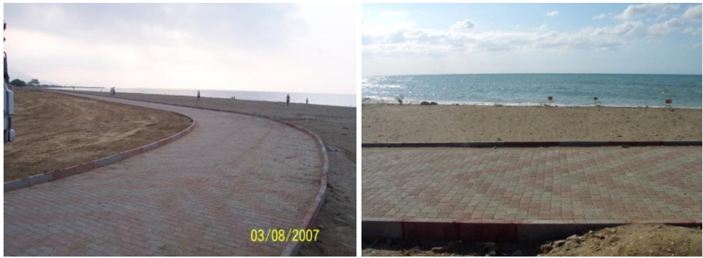
Şekil 4.20. 2007 yılında İskele - Dragon Çayı (Kocaçay) arasındaki (IV. alt bölüm) kumsalda kumsalın daralmasına sebep olan Anamur Belediyesince yapılmış olan beton parke taşlarından yürüme bandı ve bu yürüme bandı yüzünden daraltılmış kumsalda bulunan kafes ve tabela ile korunan Caretta caretta yuvalarının görünümü.
