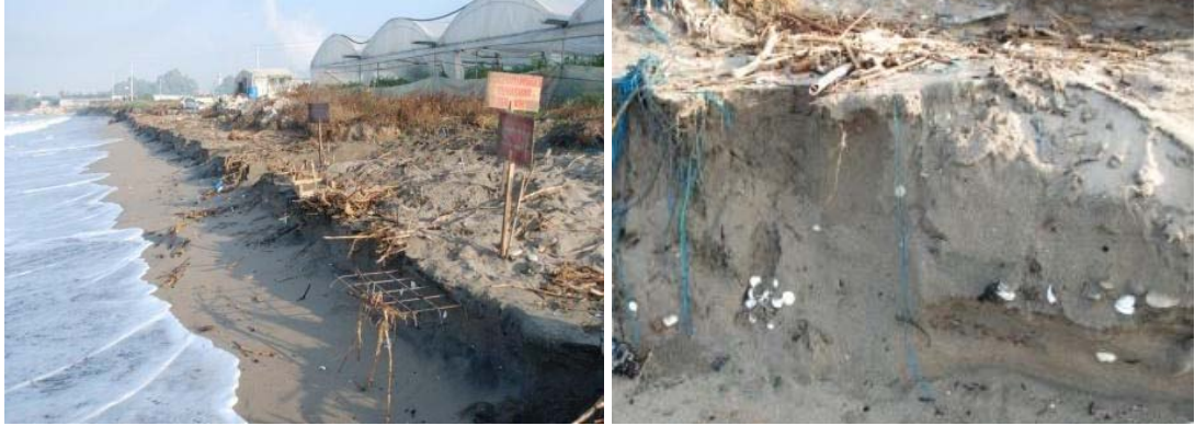
Şekil 4.21. K3 bölümünde görülen kum erozyonu ve açığa çıkan yumurtalar.
