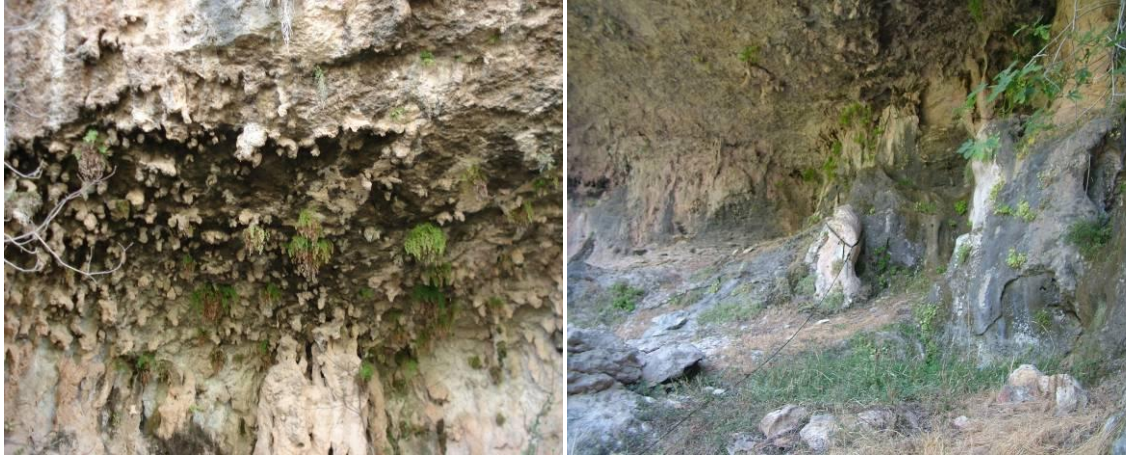
Şekil 4. 16. Lamas kanyonunun yan duvar ve ceplerinde görülen deforme olmuş damlataş oluşumları.
