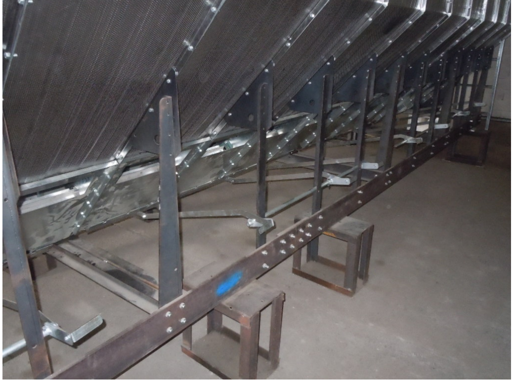
Şekil 3.12. Acil Boşaltma Kapağı Uygulaması
