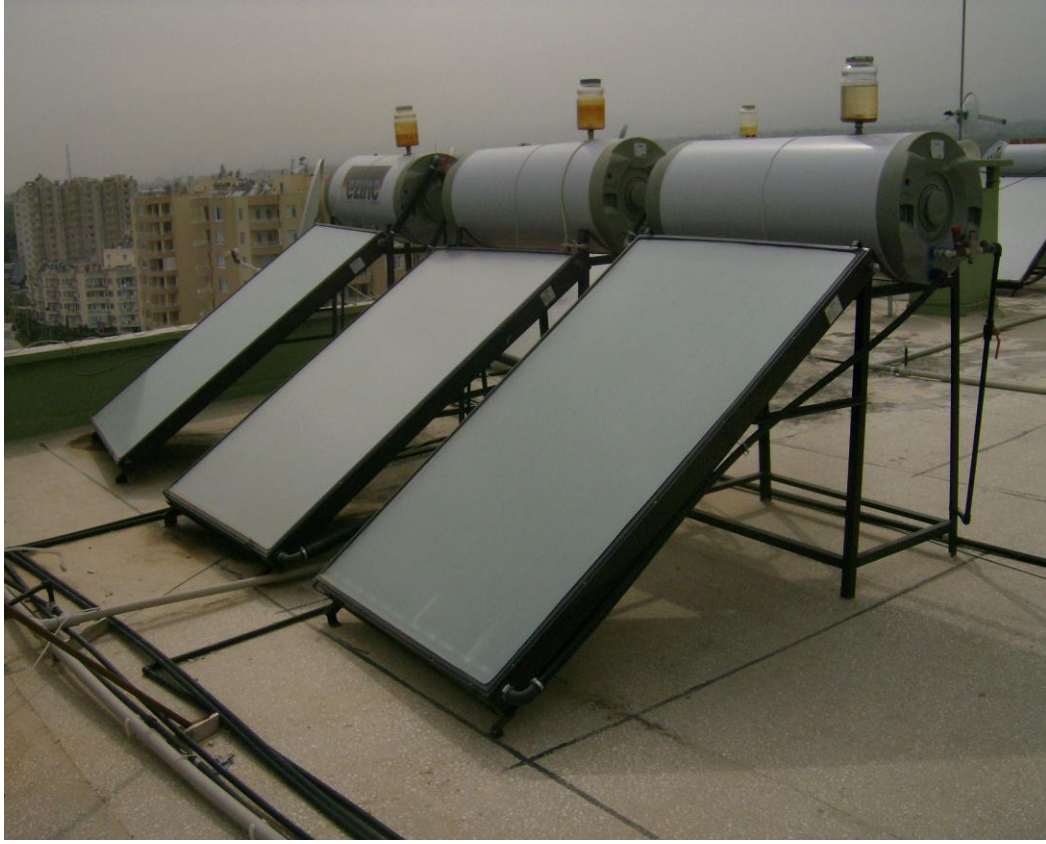
Şekil 5.12. Tek kolektörlü basınçlı güneş enerjili sıcak su sistemi örneği
