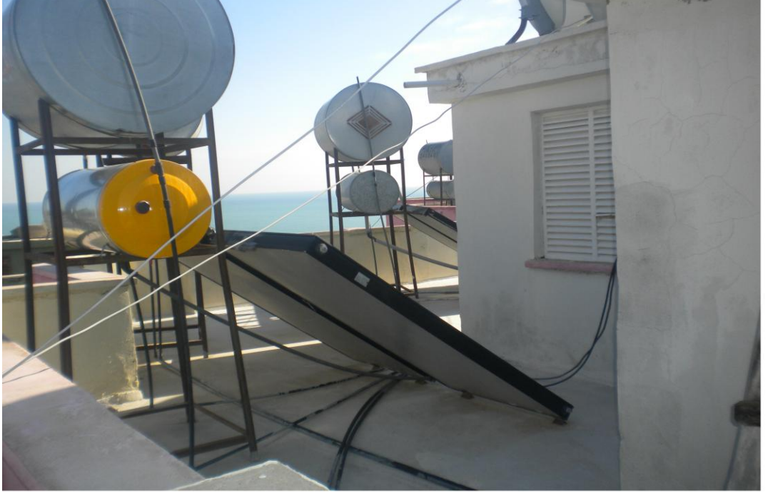
Şekil 4.4. Merdiven boşluğu arkasına konulan güneş enerjili sıcak su sistemi örneği
