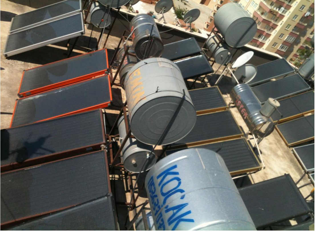
Şekil 5.2. Uygulama yapılan çok katlı binada düzlemsel kolektör ve su depolarının üstten görüntüsü
