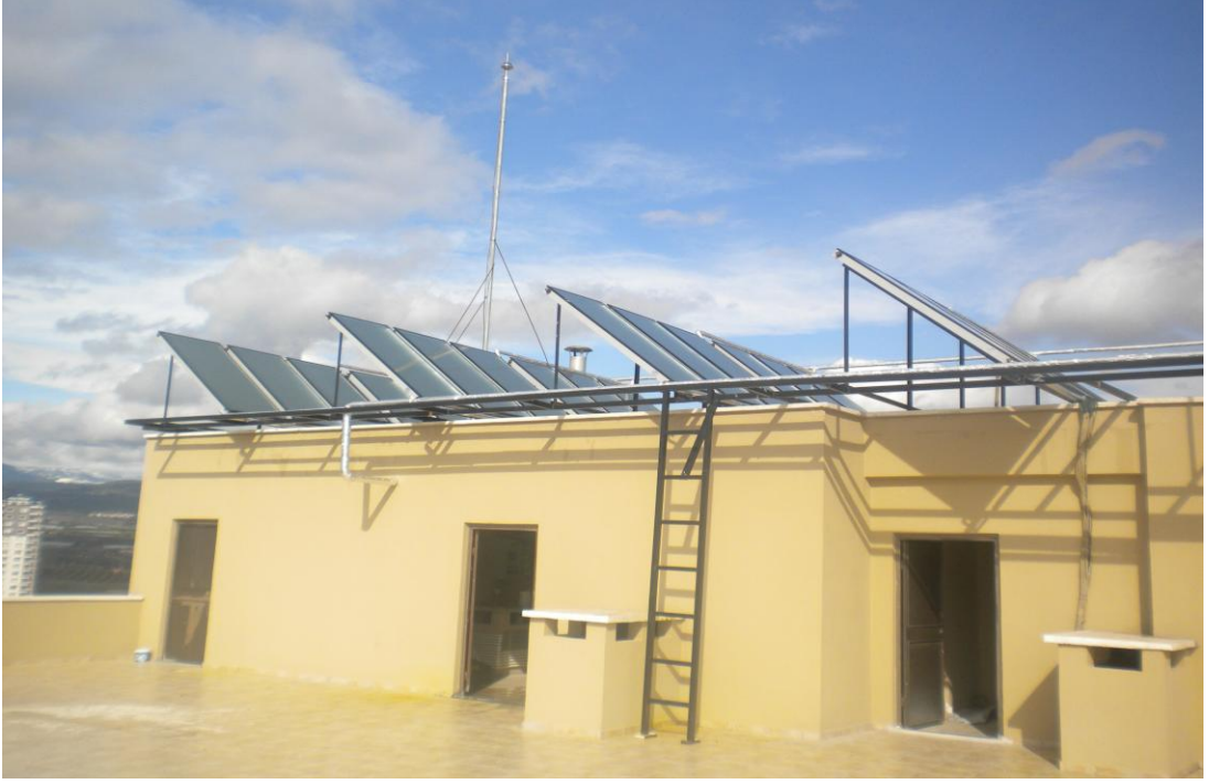
Şekil 5.11. Merkezi güneş enerjili sıcak su sistemlerinden yararlanan bir bina
