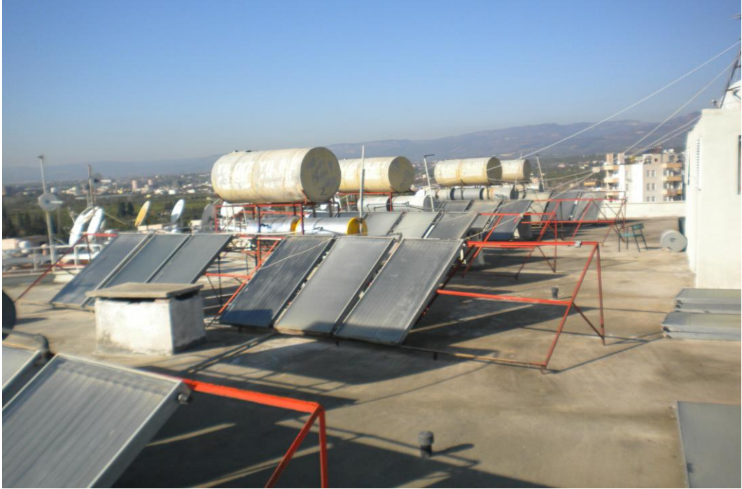
Şekil 5.10. Merkezi güneş enerjili sıcak su sistemi örneği
