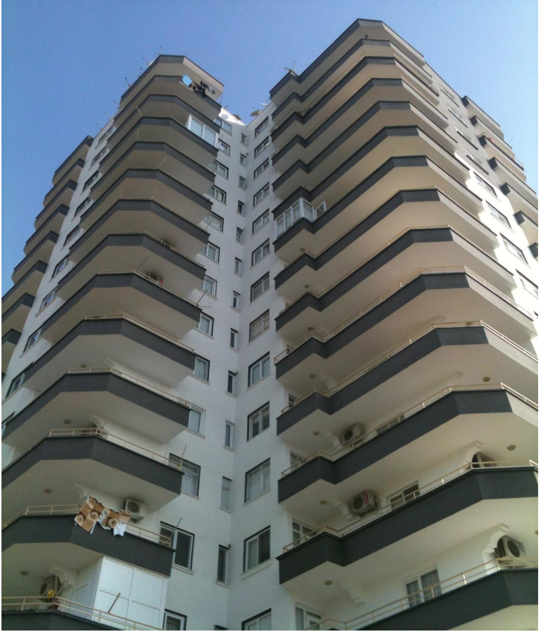
Şekil 5.1. Düzlemsel kolektör yerine vakum borulu kolektör uygulaması yapılan çok katlı bina
